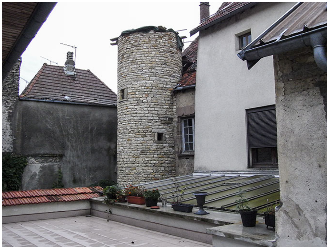
Façade postérieure : la tour en cours de restauration.
