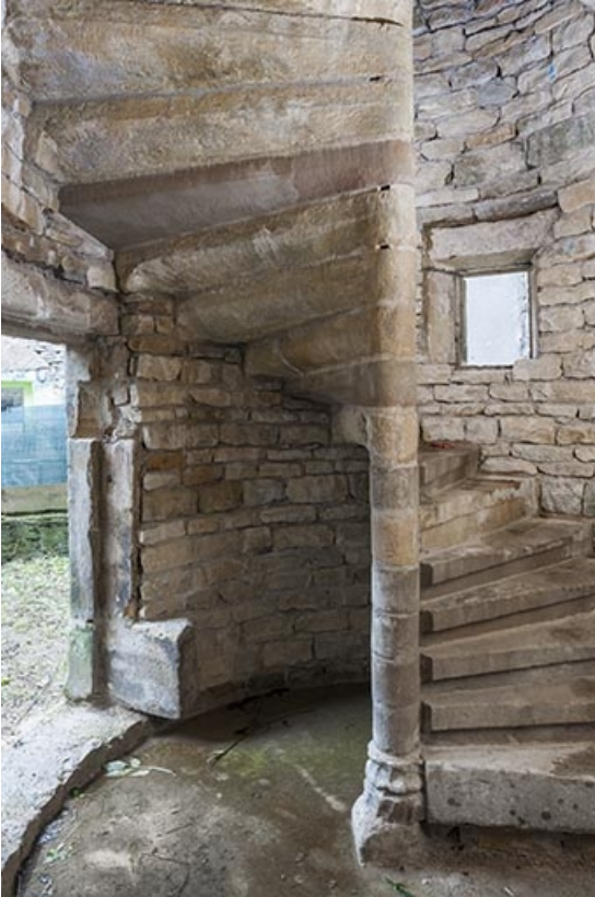
Intérieur de la tour : escalier en vis.
