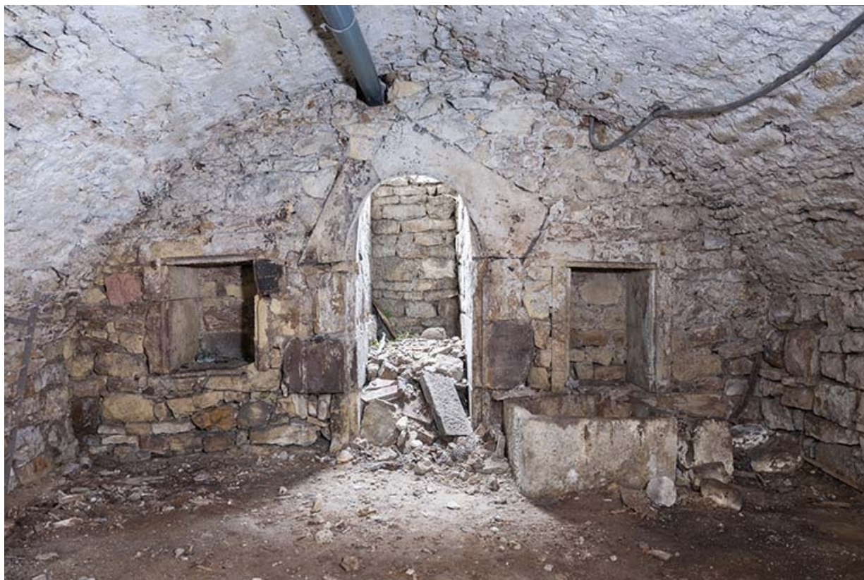
Intérieur : sous-sol, vue rapprochée du mur côté cour. 70, Faverney, 17 rue Thiers
