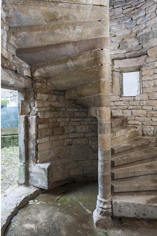
Intérieur de la tour : escalier en vis.
