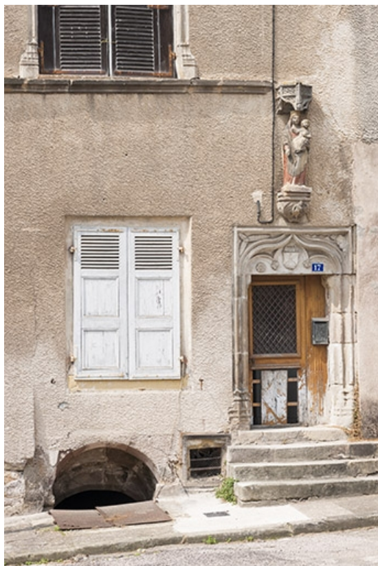
Façade antérieure : détail du rez-de-chaussée.
