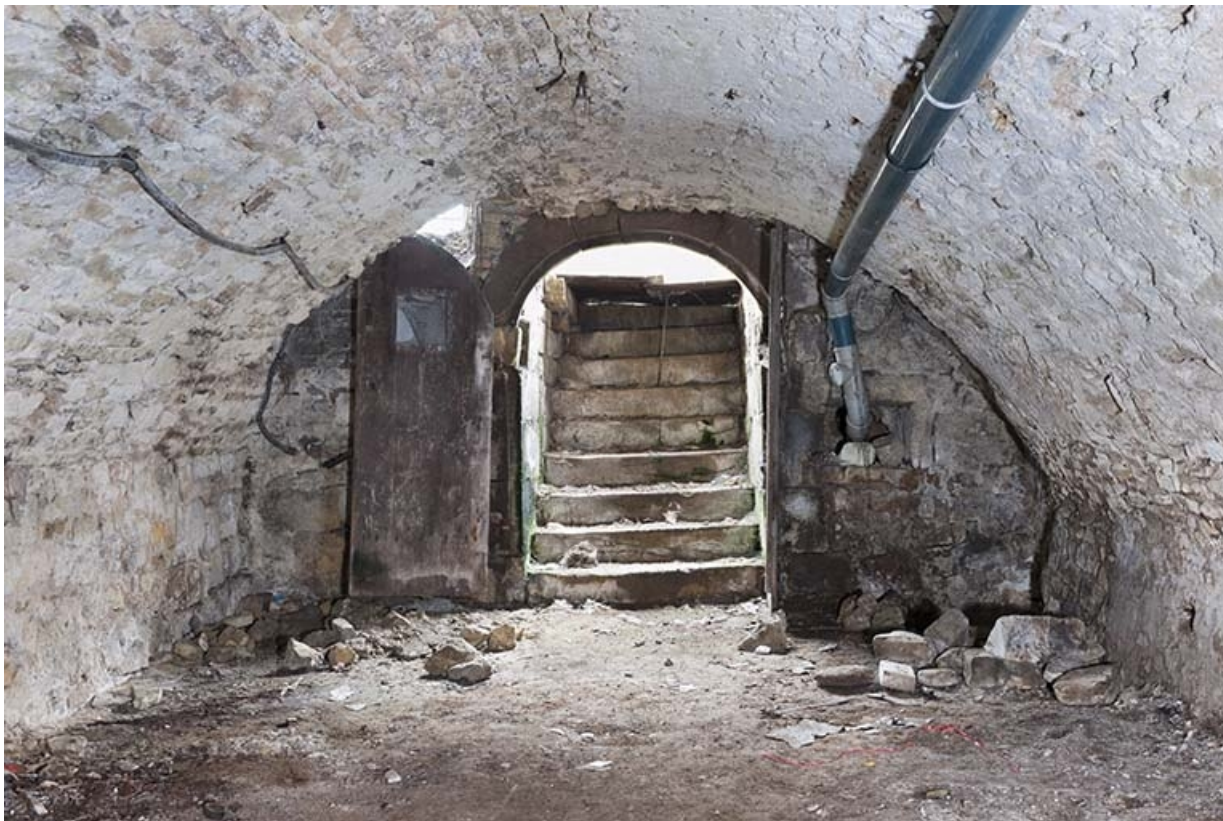
Intérieur : sous-sol, entrée du côté de la rue Thiers.
