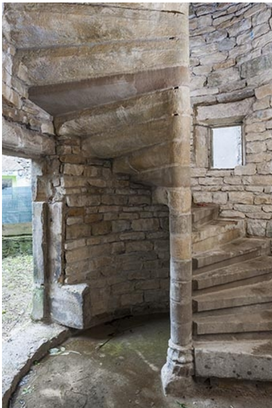
Intérieur de la tour : escalier en vis.
