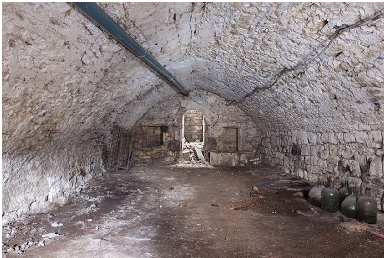
Intérieur : sous-sol vu en direction de la cour.
