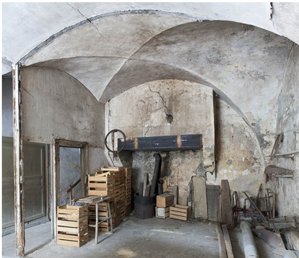
La cuisine et sa cheminée.
