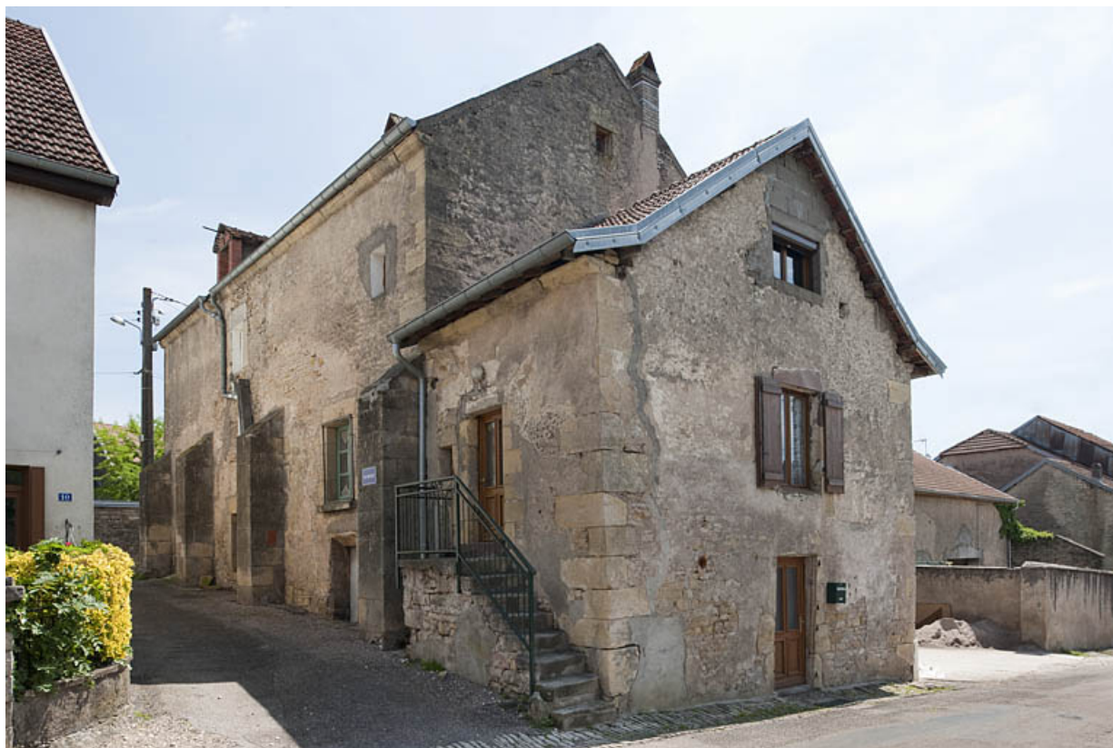
Vue générale depuis la rue Catinat.
