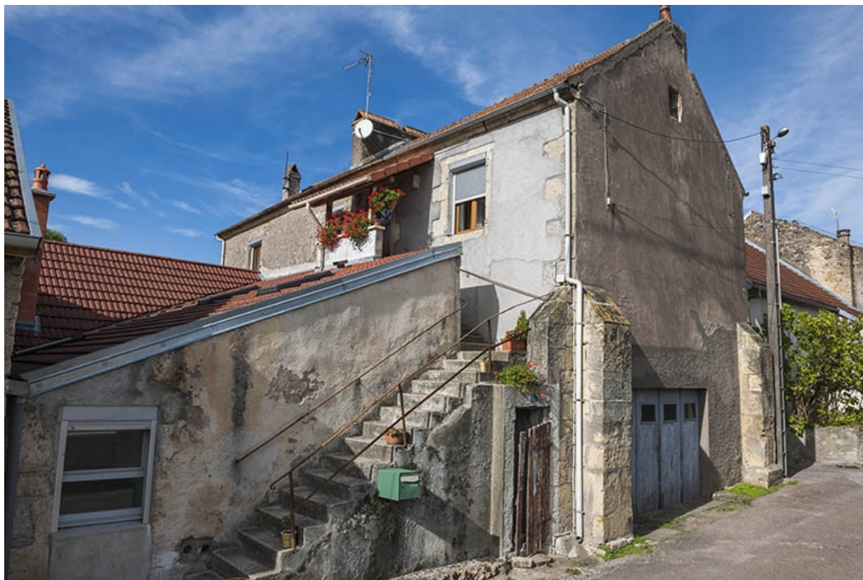
Vue générale depuis la rue des Raux.
