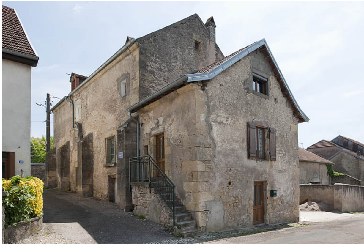
Vue générale depuis la rue Catinat.
