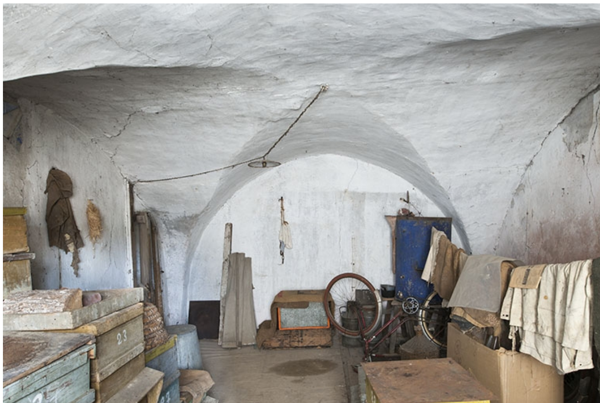
La seconde pièce, en direction de l'escalier. 70, Faverney rue des Ruaux
