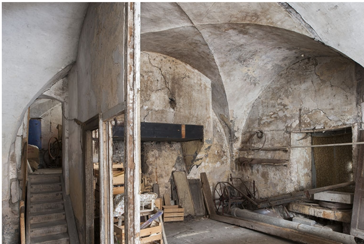
La cuisine et l'escalier conduisant à la seconde pièce.
