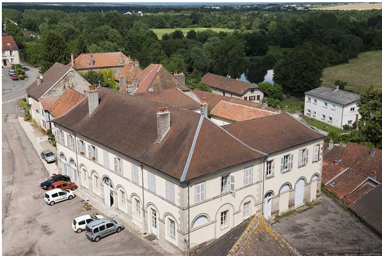
Vue d'ensemble depuis le clocher de l'église paroissiale. 70, Favorney rue Bossuet
