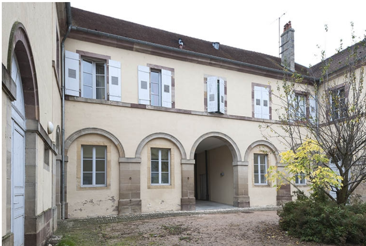
Façade postérieure, avec passage couvert et les deux ailes en retour sur cour. 70, Faverney rue Bossuet
