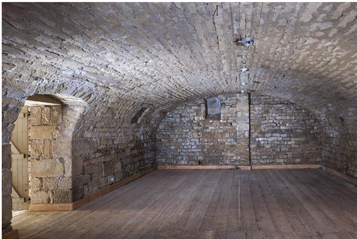
Intérieur : la cave aménagée pour la gendarmerie dans le mur de soutènement côté rue de l'Official. 70, Favorney rue Bossuet
