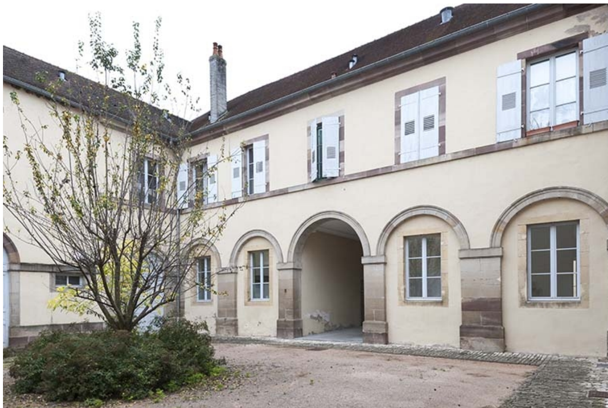
Façade postérieure et aile sud.
