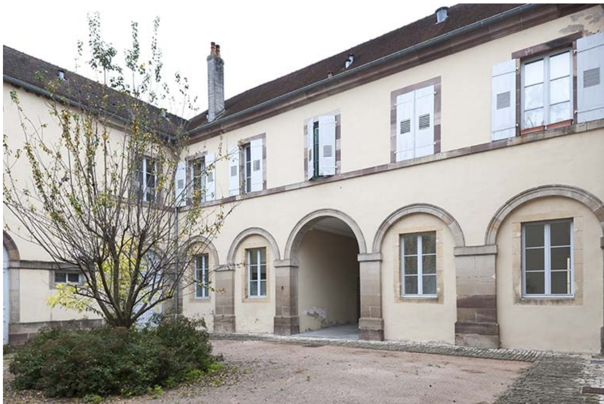
Façade postérieure et aile sud.
