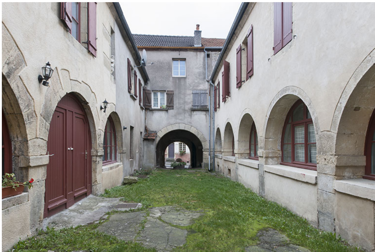
Cour intérieure en direction de la rue Thiers (aile nord à gauche, aile sud à droite). 70, Faverney, 4, 6 Grande Rue
