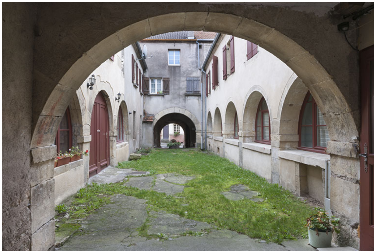
Cour intérieure en direction de la rue Thiers.
