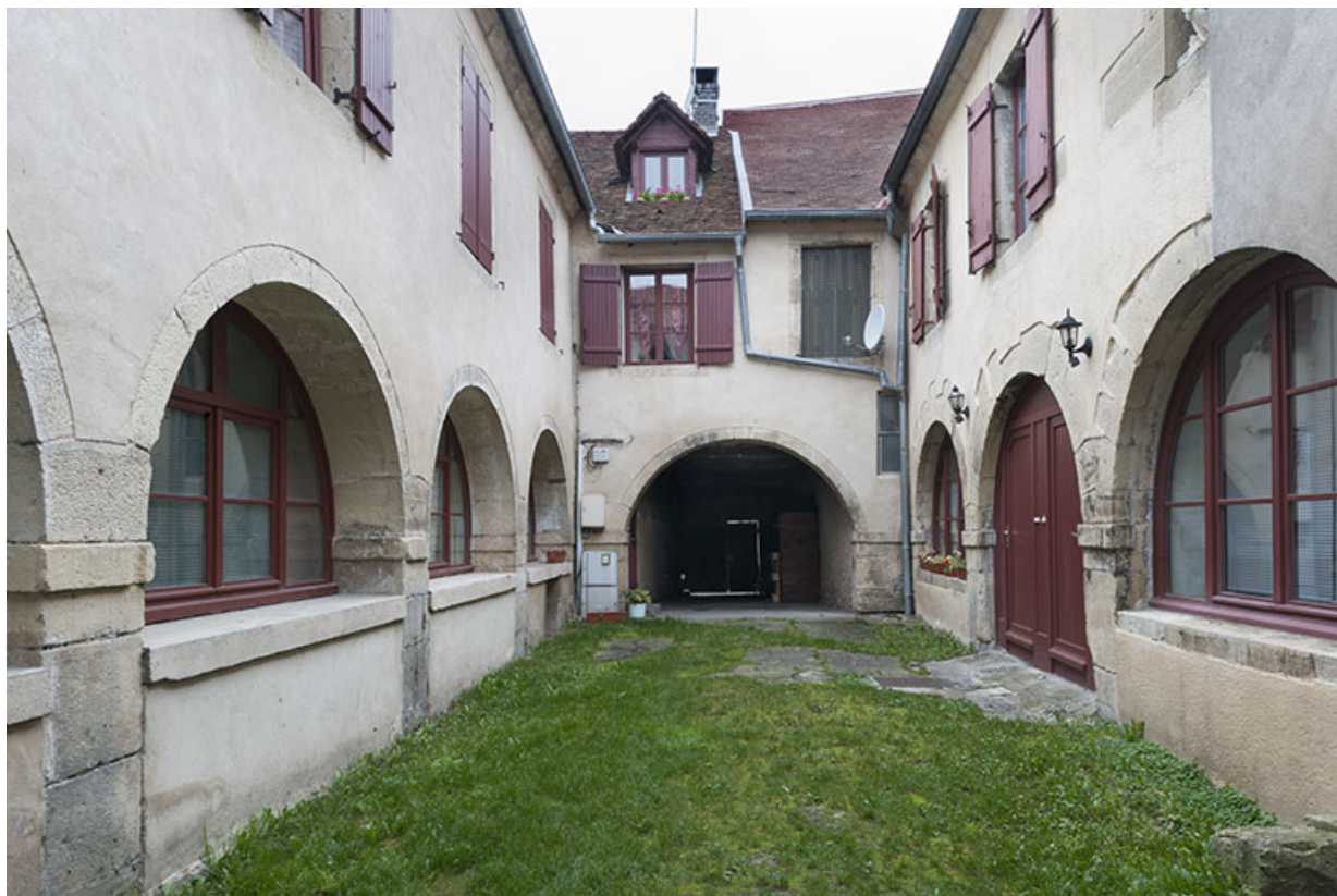
Cour intérieure en direction de la Grande Rue.
