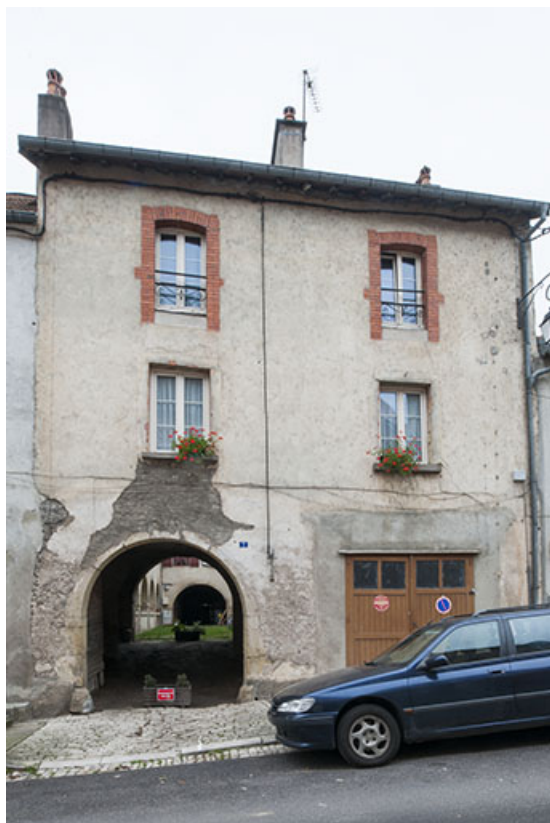
Façade côté rue Thiers.
