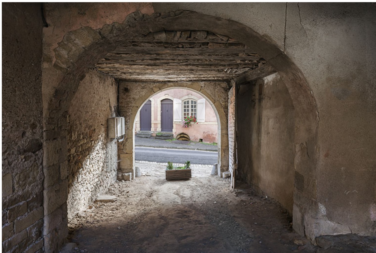
Passage couvert en direction de la rue Thiers.
