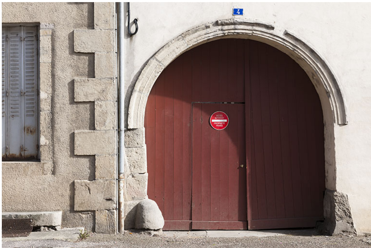
Porte charretière, Grande-Rue.
