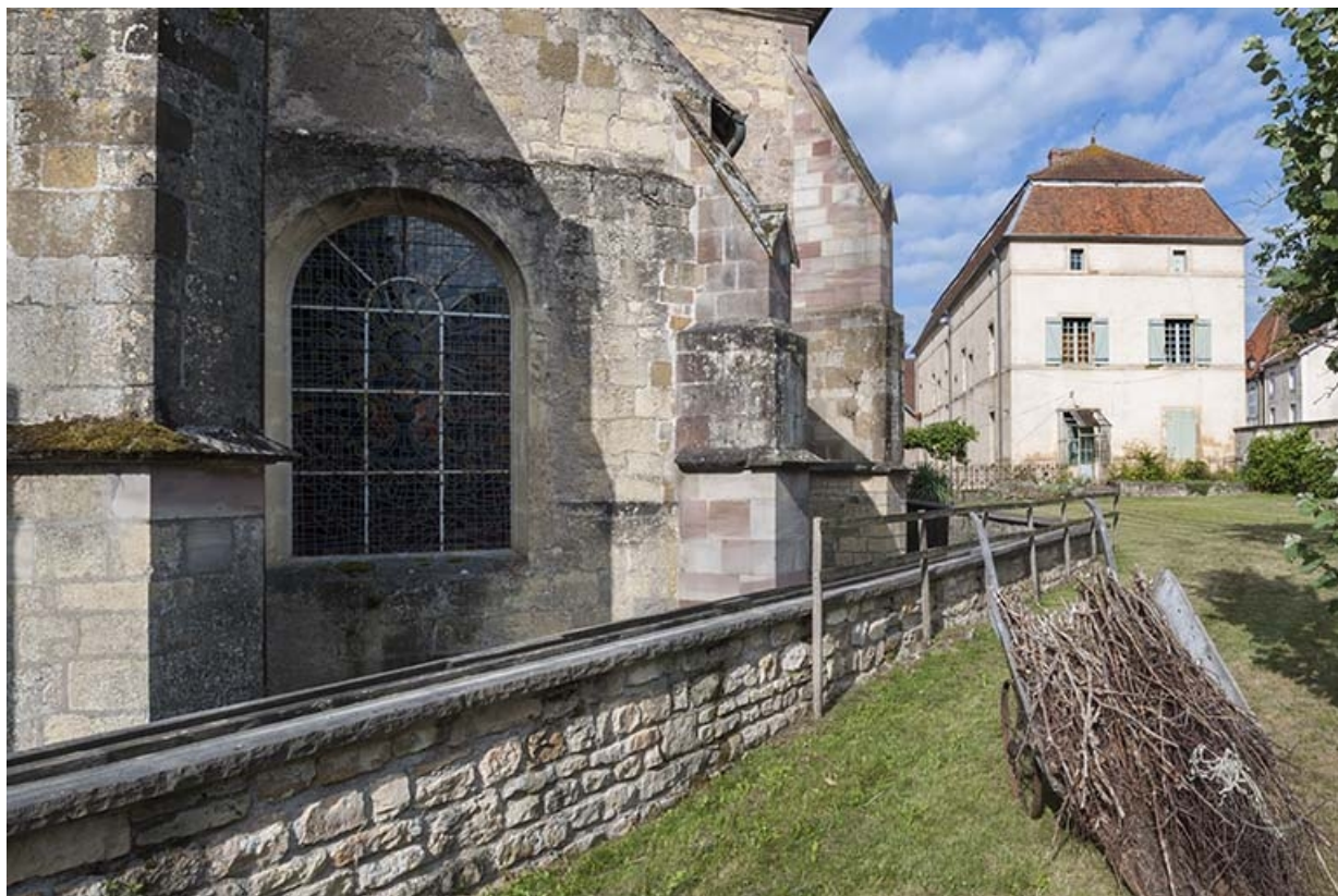
Façade latérale gauche depuis le jardin de l'ancien presbytère.
