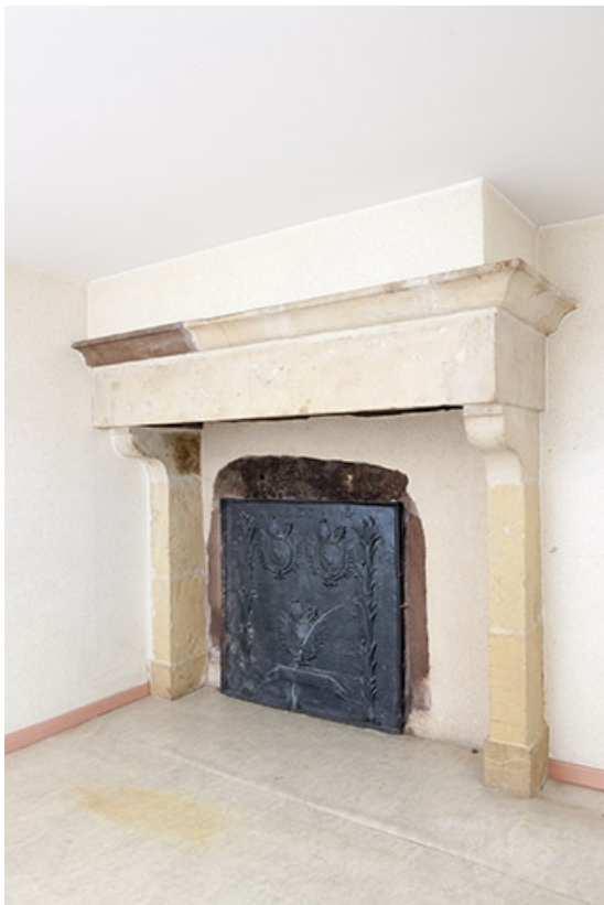
La cheminée de la cuisine.
