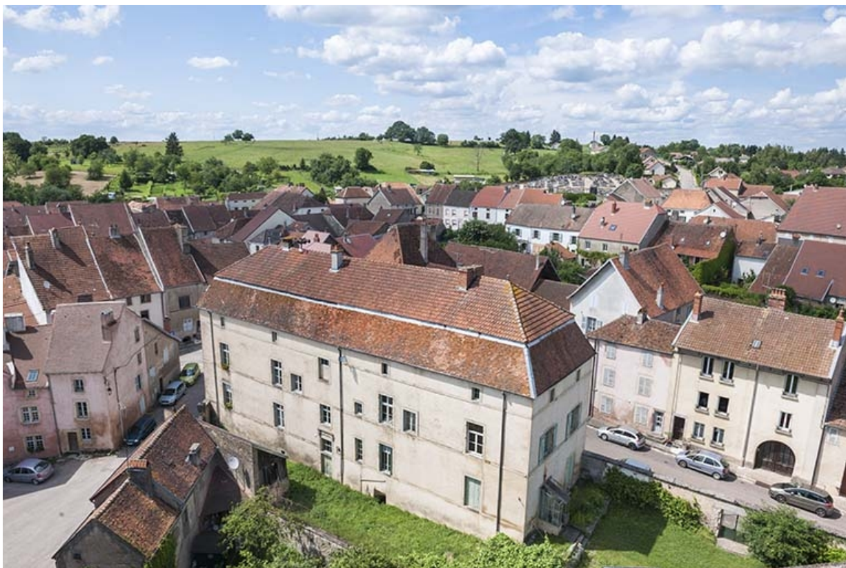
Façade postérieure depuis le clocher de l'église Notre-Dame.
