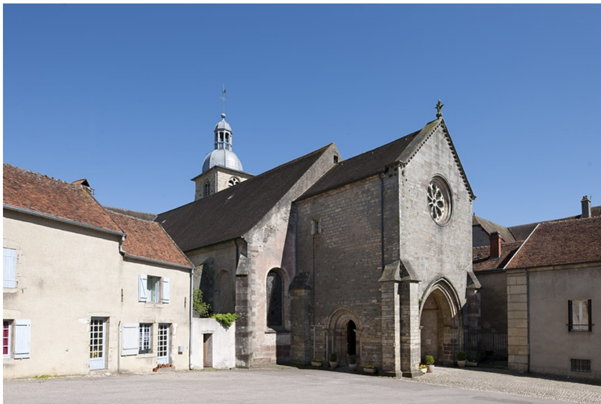
Vue générale depuis la place Sainte-Gude.
