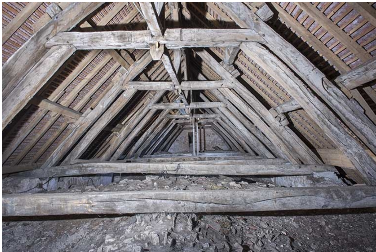
Vue d'ensemble de la charpente.
