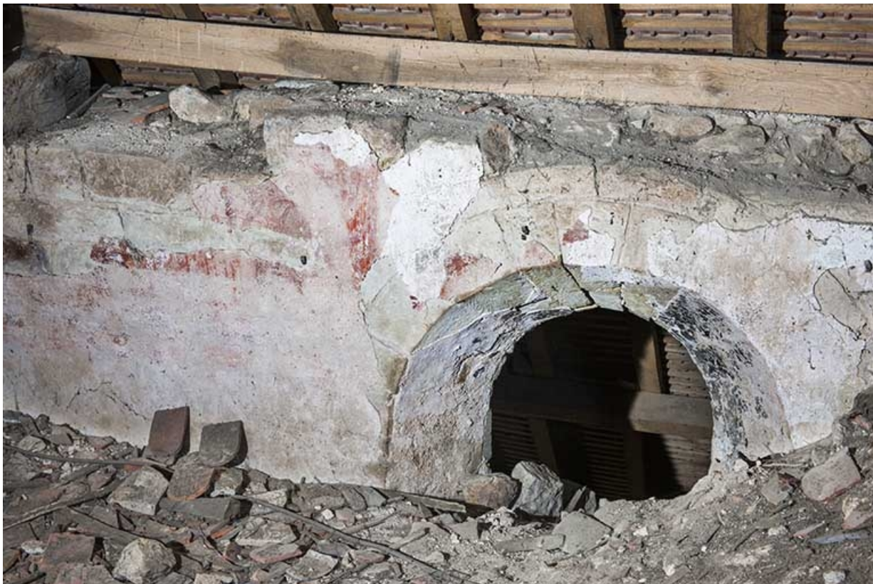
Ancienne baie en plein cintre située au-dessus de la voûte, avec traces d'enduit. 70, Favorney place Sainte-Gude
