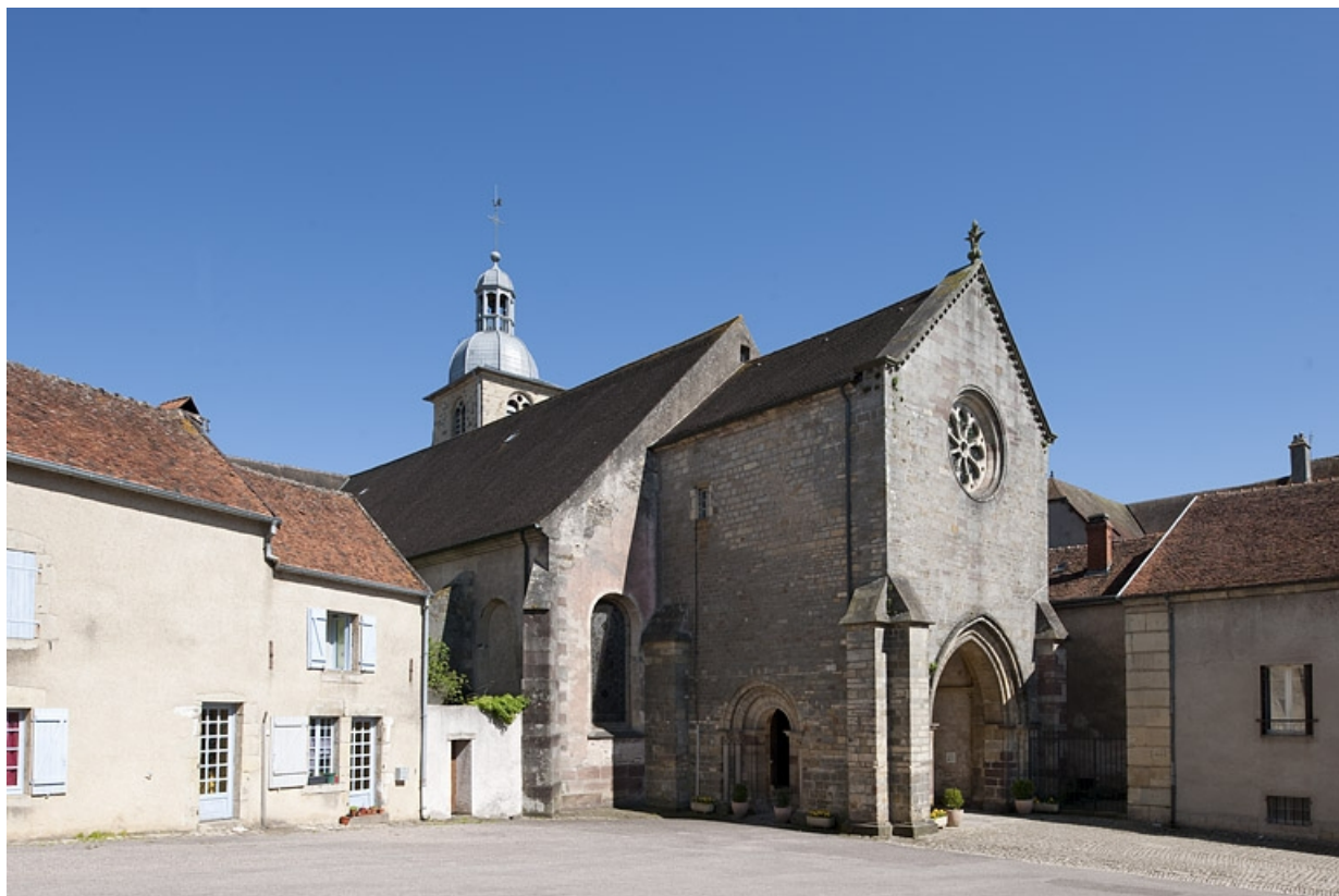
Vue générale depuis la place Sainte-Gude.
