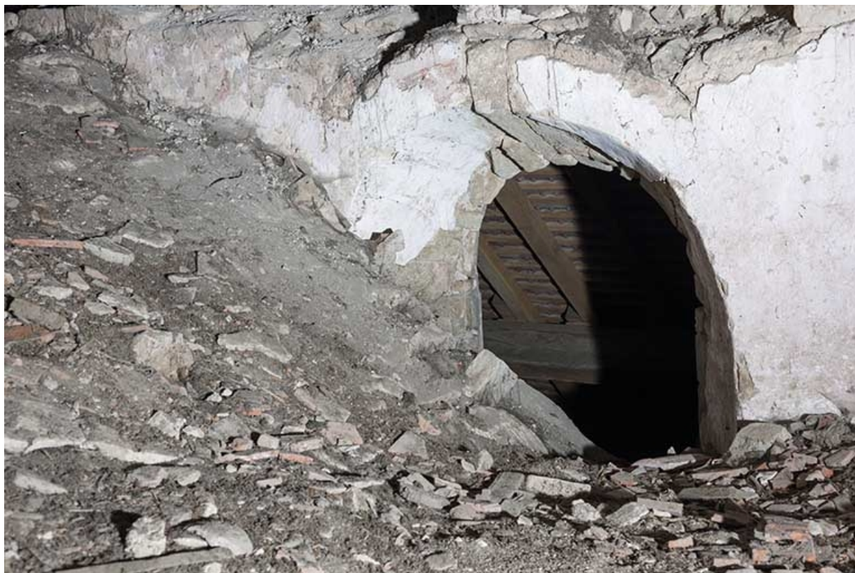
Ancienne baie au-dessus de la voûte.
