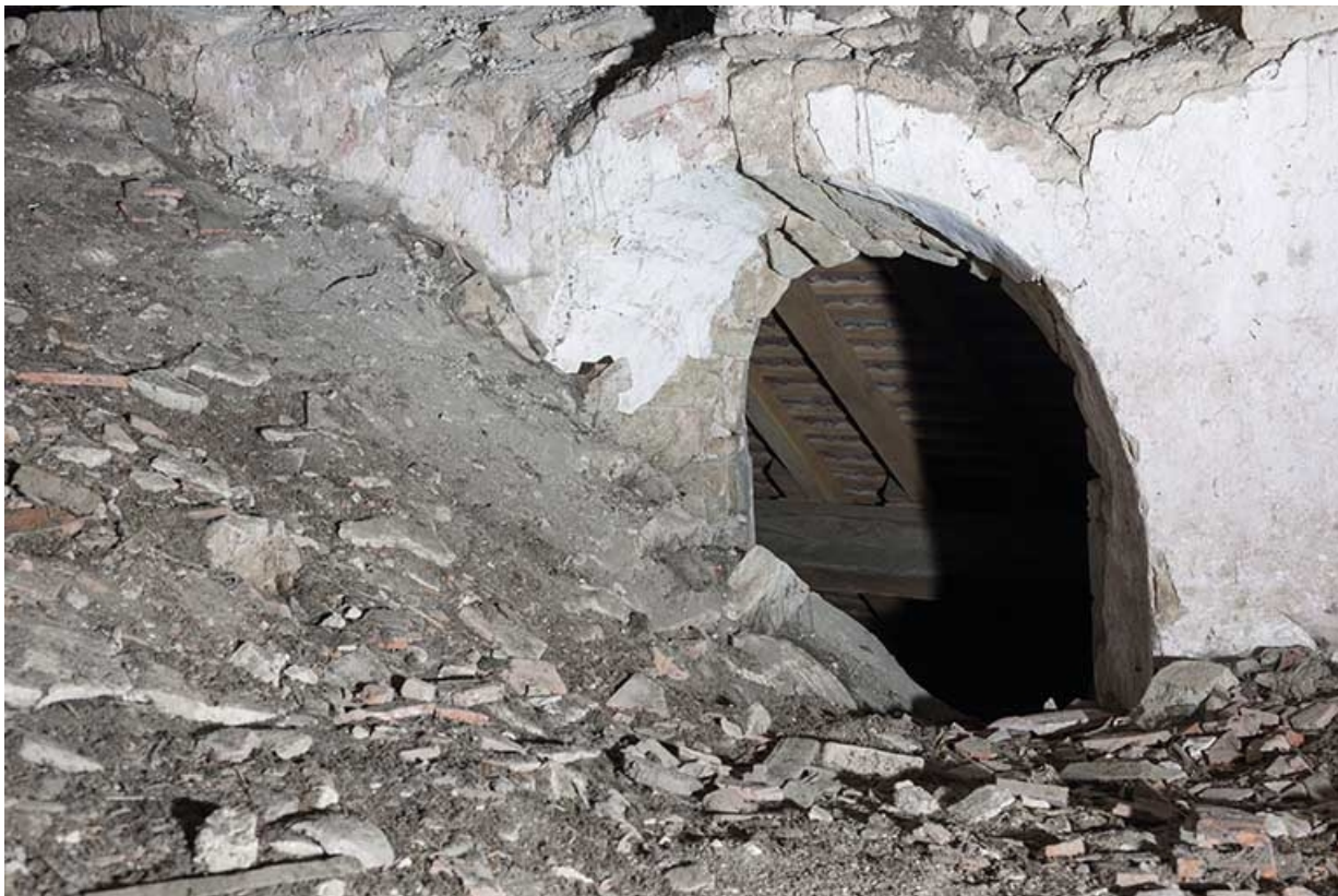
Ancienne baie au-dessus de la voûte.
