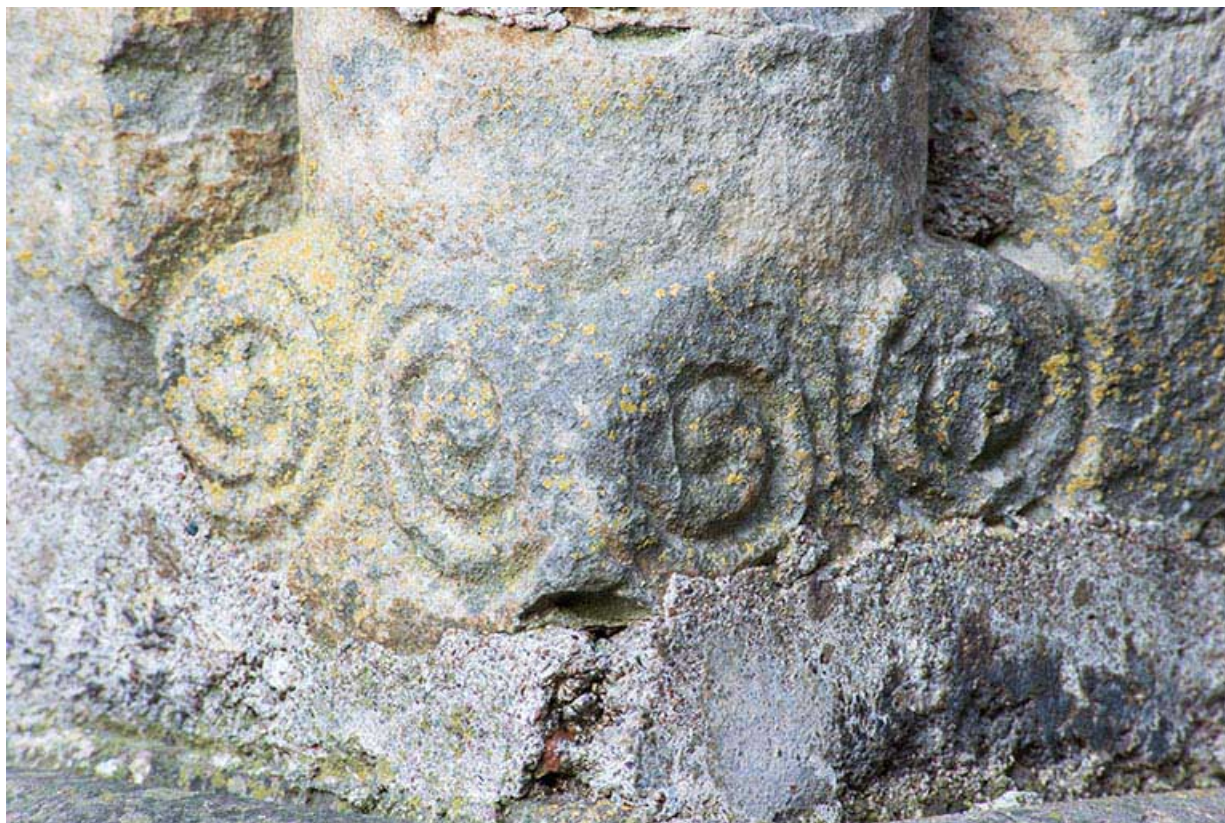
Pilier gauche du porche : détail de la colonnette en réemploi.
