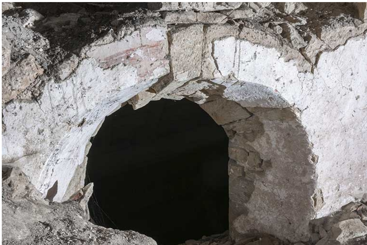
Autre baie en plein cintre au-dessus de la voûte.
