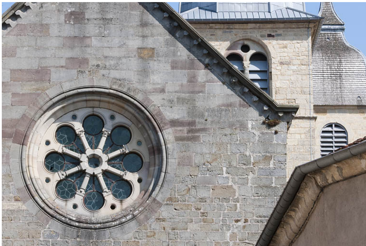
Façade antérieure, détail : l'oculus.
