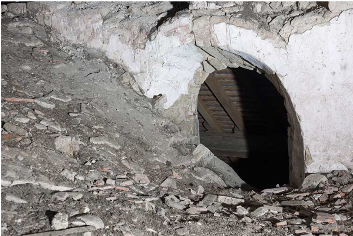
Ancienne baie au-dessus de la voûte.
