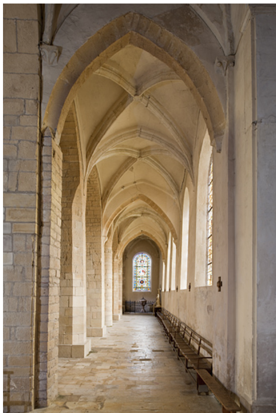
Bas-côté gauche vu depuis le transept.
