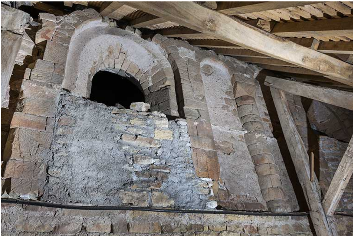
Baie en plein cintre vue depuis le comble du bas-côté sud. 70, Favorney place Sainte-Gude
