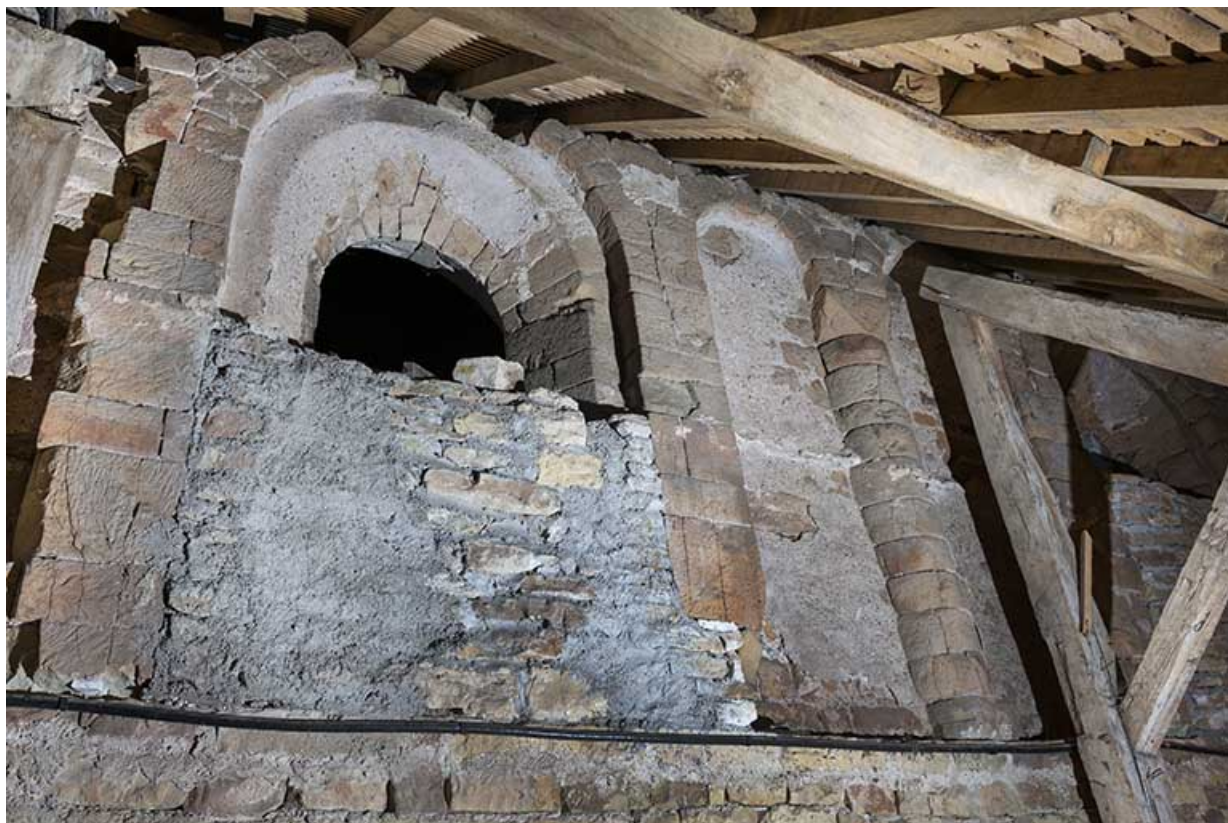
Baie en plein cintre vue depuis le comble du bas-côté sud. 70, Favorney place Sainte-Gude
