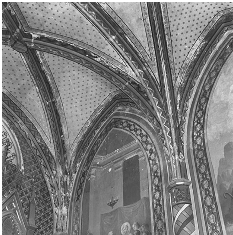
Chapelle du Miracle [des Saintes-Hosties : voûtement peint], s.d. [avant 1975]. 70, Faverney place Sainte-Gude
