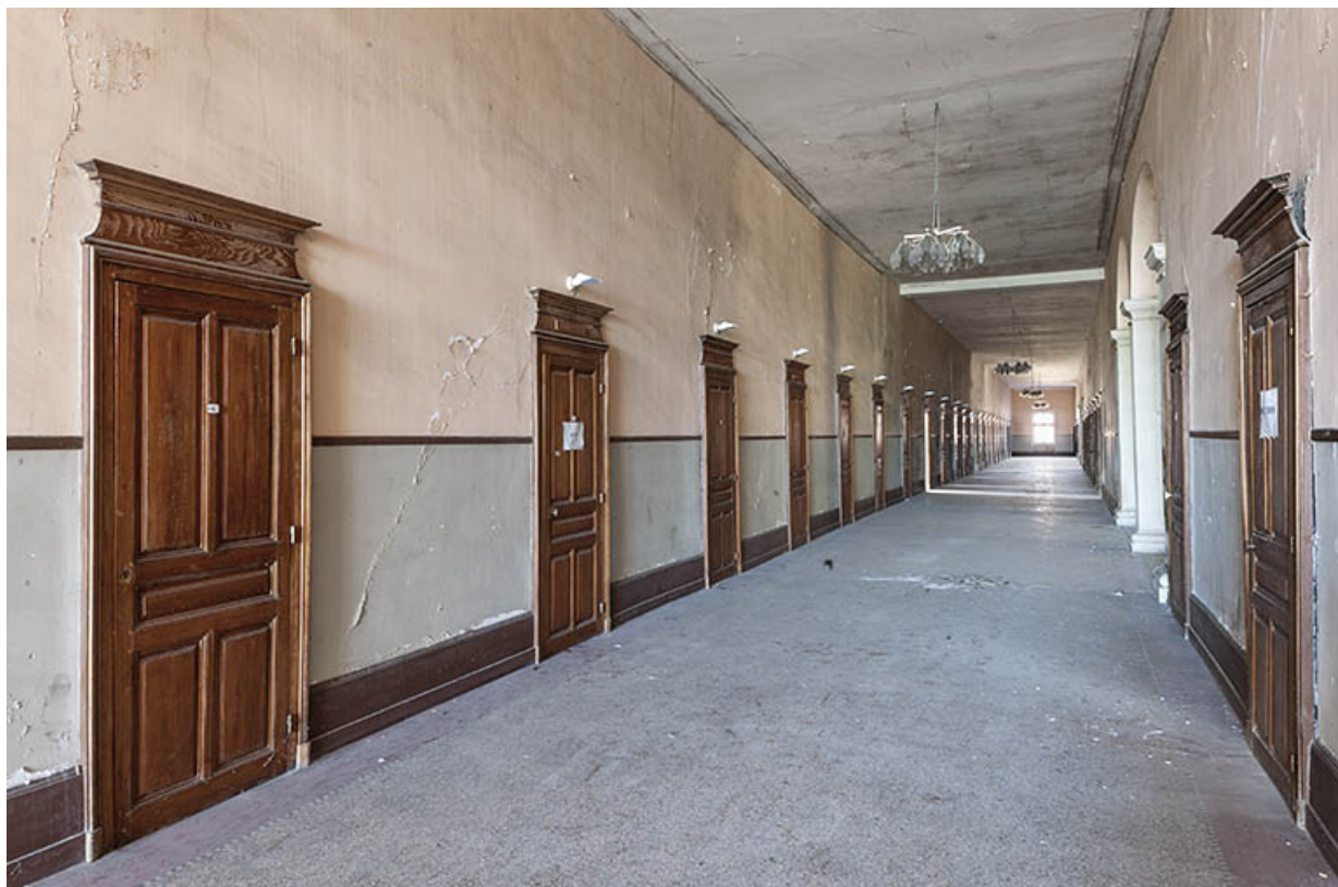
Intérieur : le couloir en direction de l'ouest.
