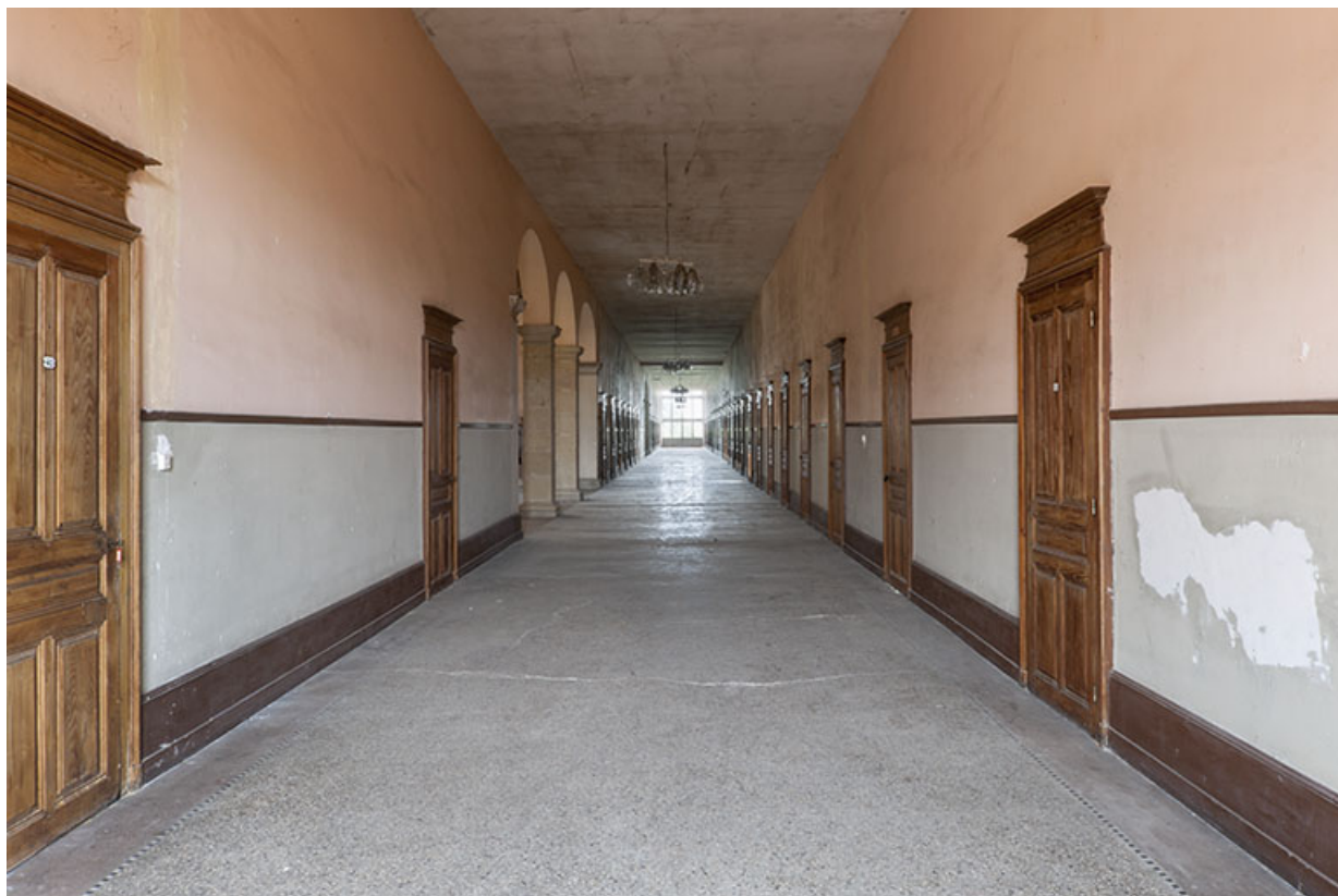
Intérieur : le couloir ouvrant sur les chambres.
