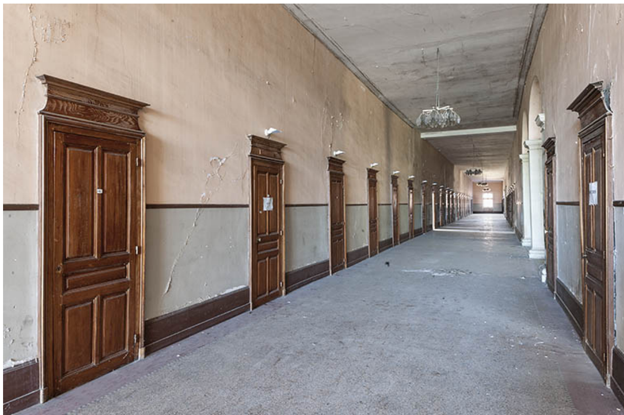
Intérieur : le couloir en direction de l'ouest.
