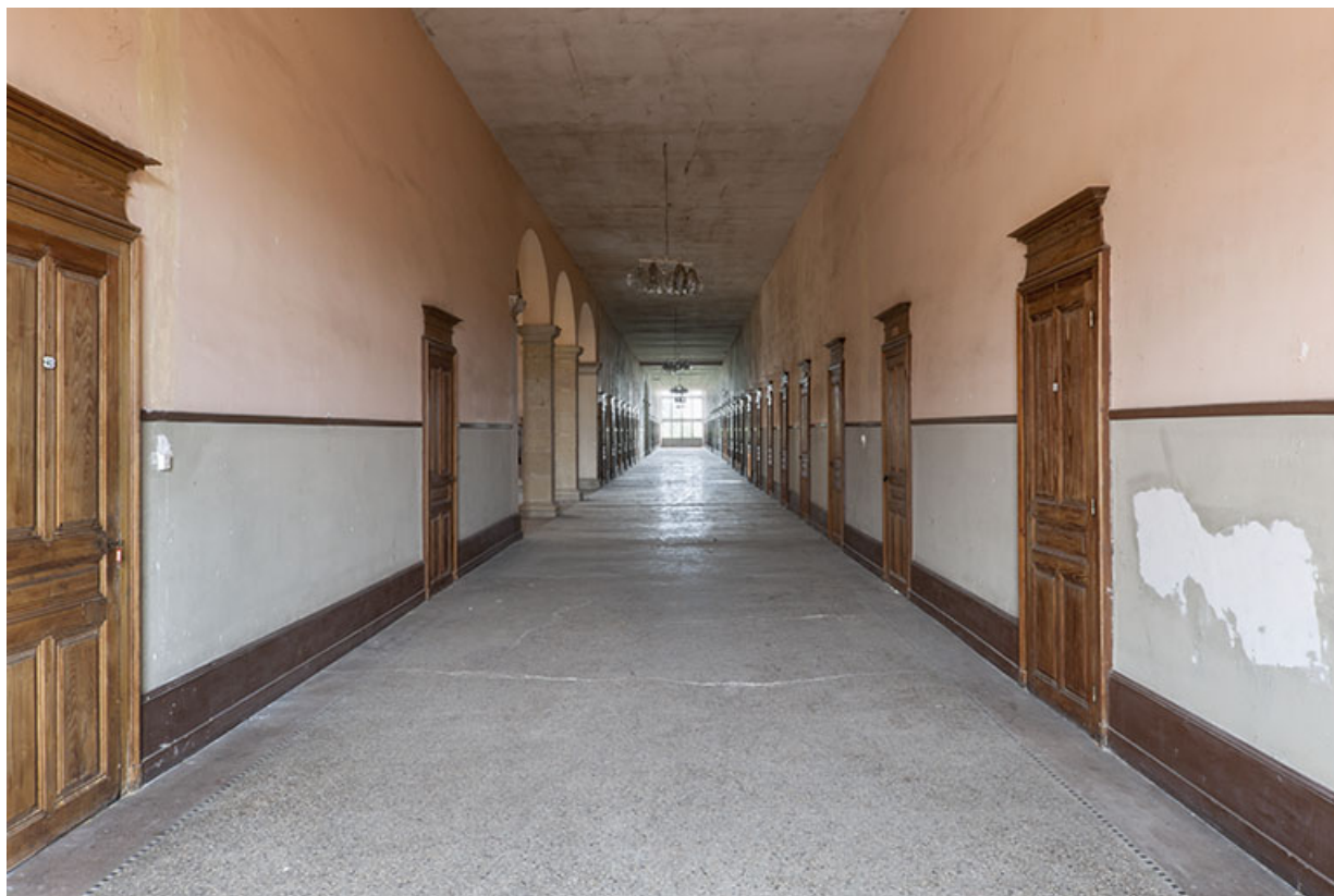
Intérieur : le couloir ouvrant sur les chambres.
