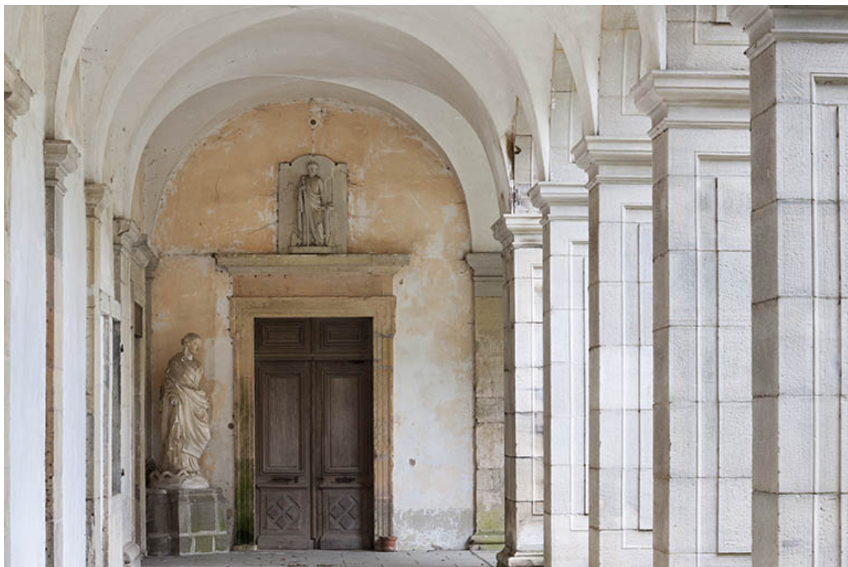
Vue rapprochée de la galerie sud.
