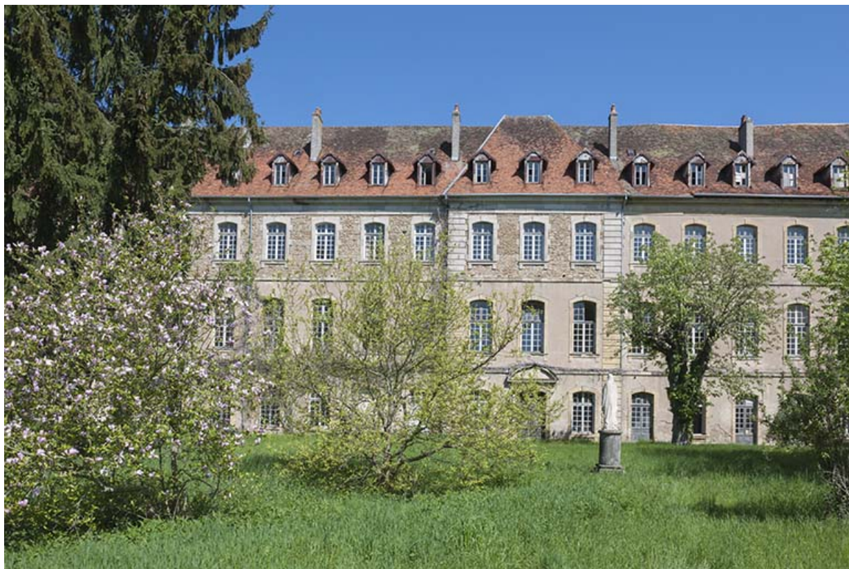
Façade sud vue de face.
