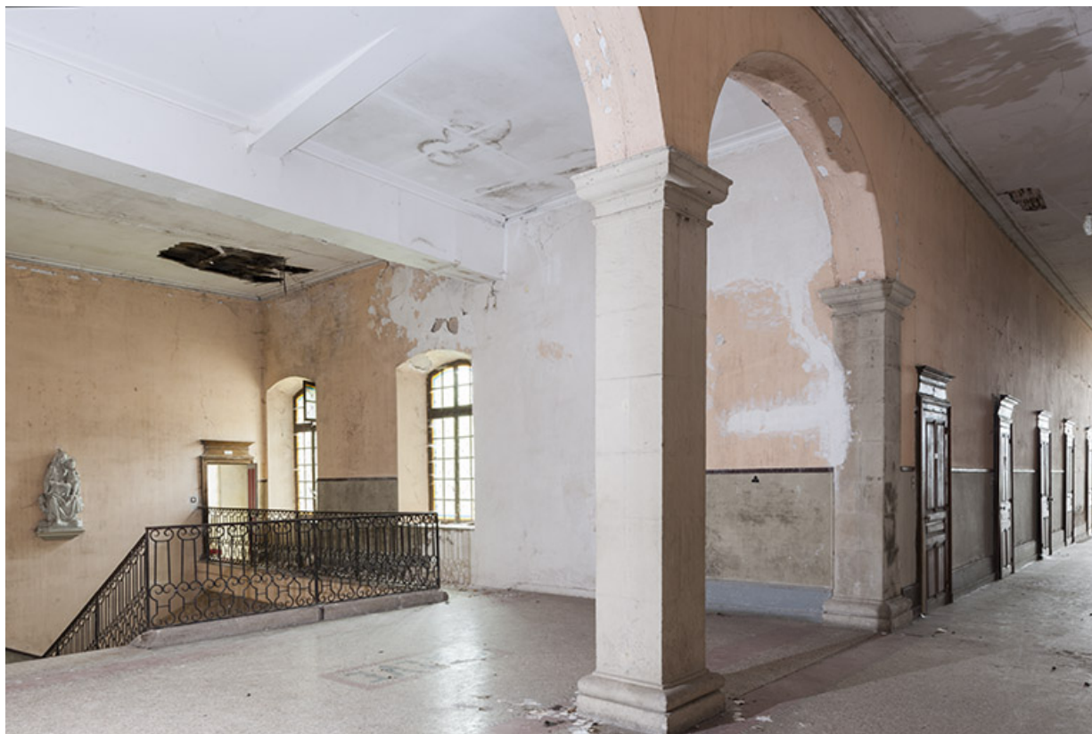
Intérieur : le grand escalier au niveau du couloir.
