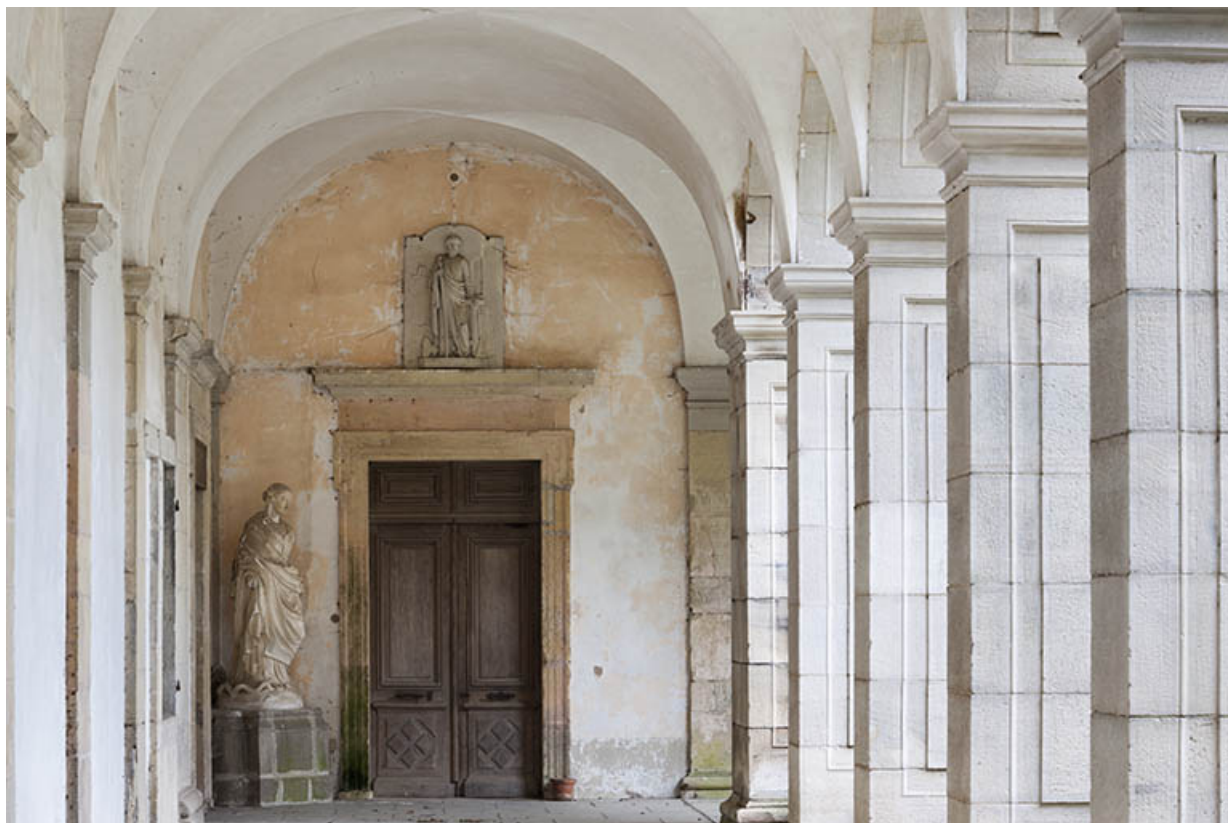
Vue rapprochée de la galerie sud.
