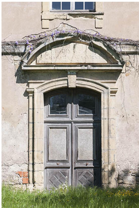
Façade sud, détail porte ouvrant sur le grand escalier. 70, Faverney place de la République
