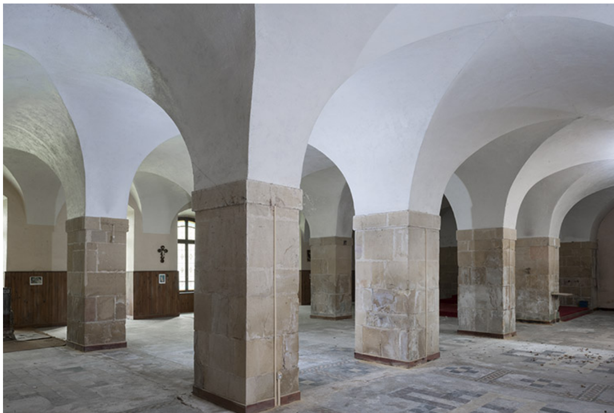
Intérieur : l'étage de soubassement.
