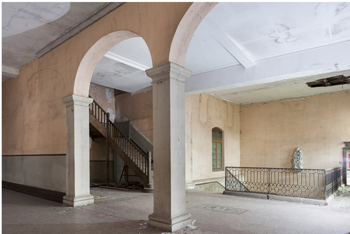
Intérieur : le grand escalier au rez-de-chaussée.
