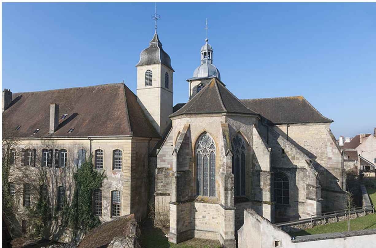
Façade sud et chevet de l'église depuis la rue de l'Official.
