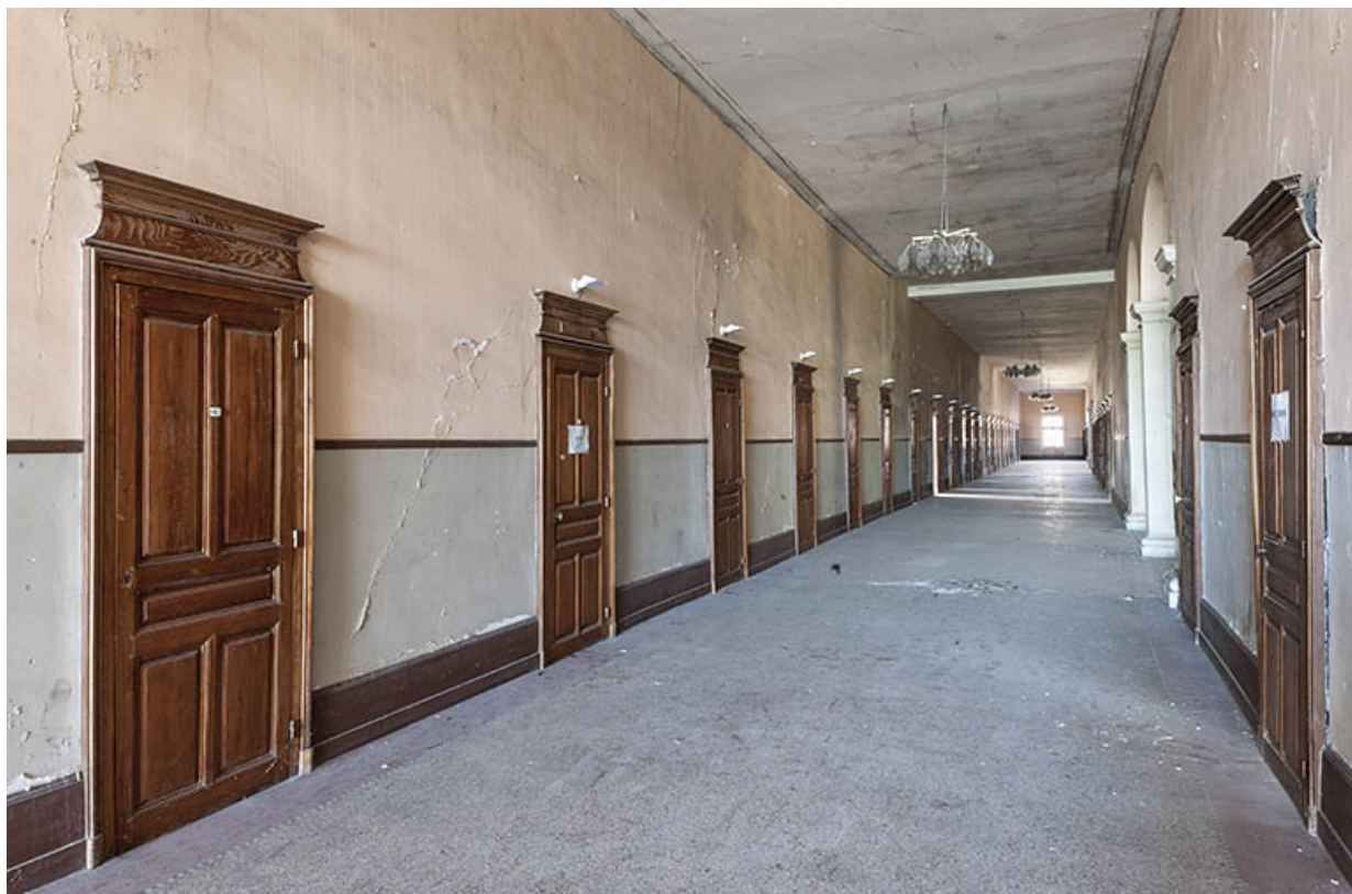
Intérieur : le couloir en direction de l'ouest.
