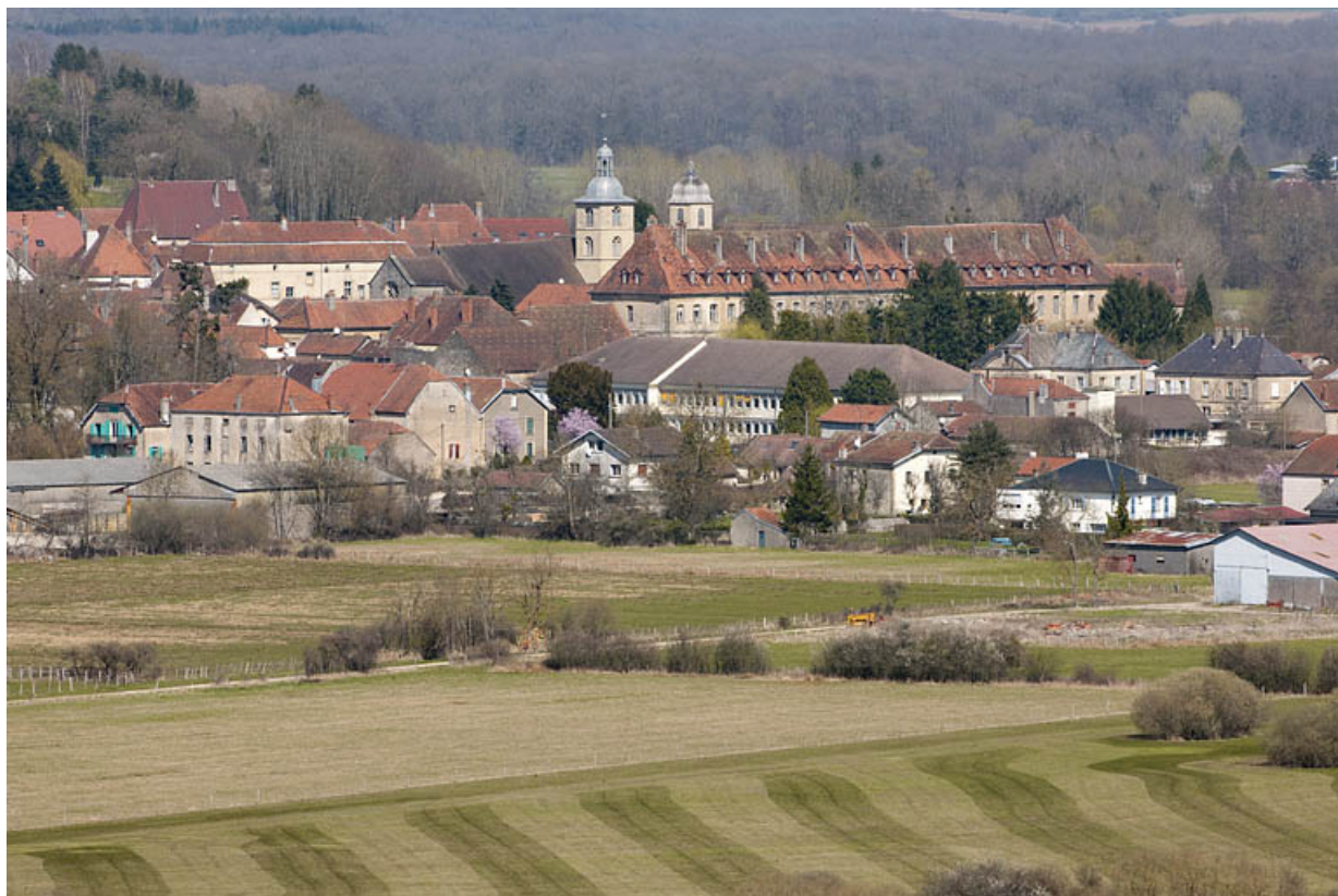
Vue générale depuis le sud-ouest.
