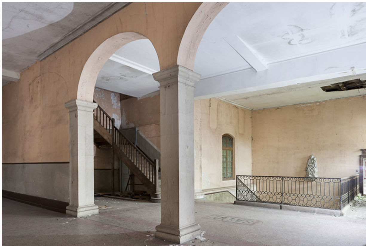
Intérieur : le grand escalier au rez-de-chaussée.
