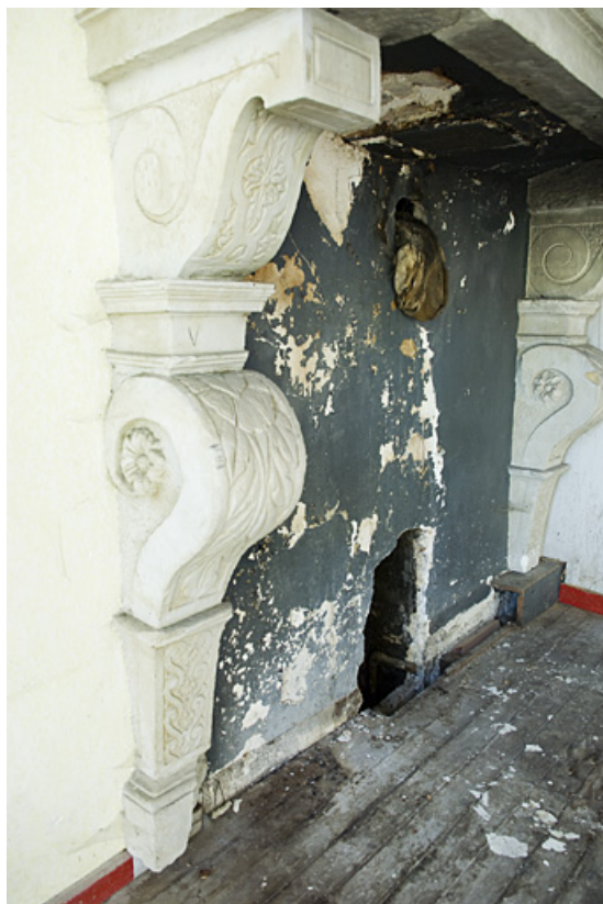
Intérieur : la cheminée du réfectoire, détail d'un jambage.
