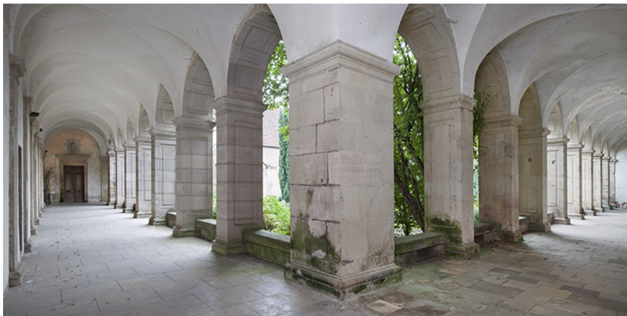
Les deux galeries du cloître depuis l'angle sud-est.
