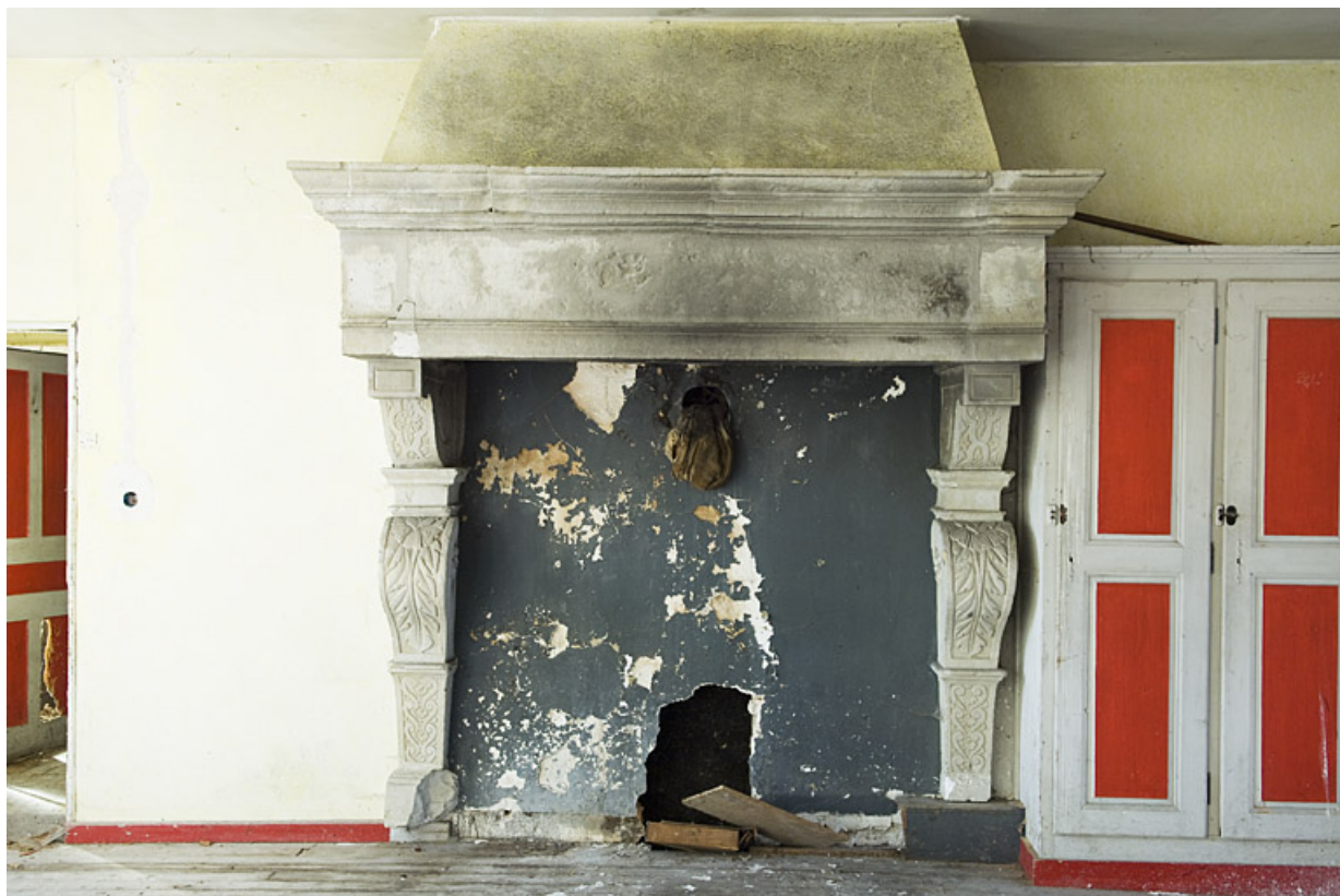
Intérieur : le réfectoire, détail : la cheminée. 70, Favorney place de la République
