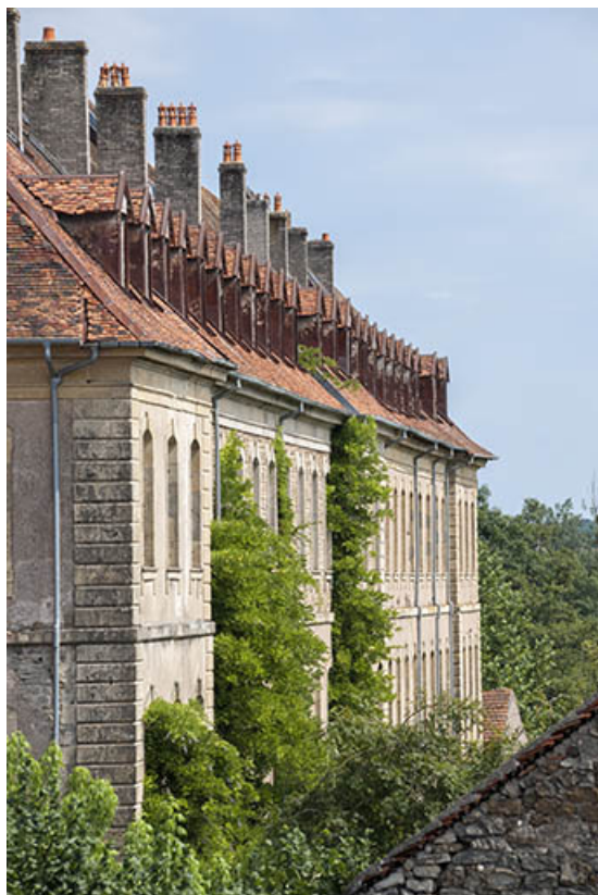
Vue rapprochée de la façade sud.
