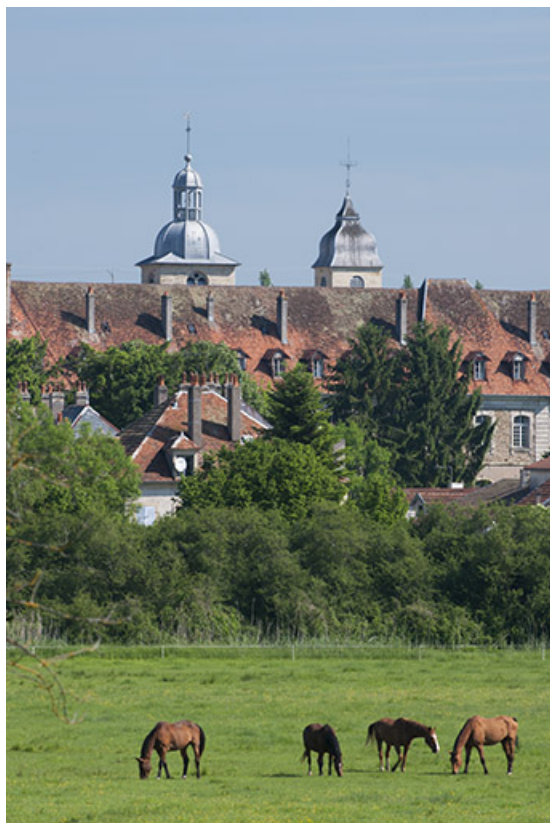
Vue partielle rapprochée depuis le sud.
