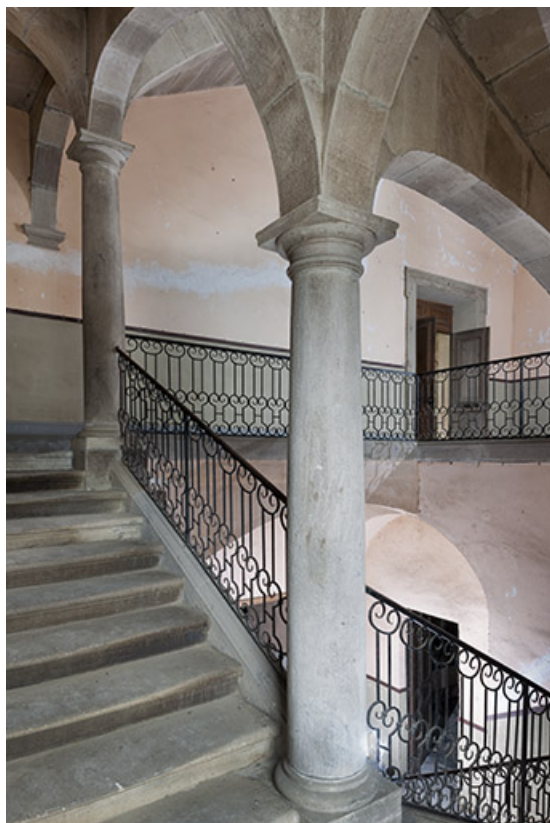
Intérieur : le grand escalier.
