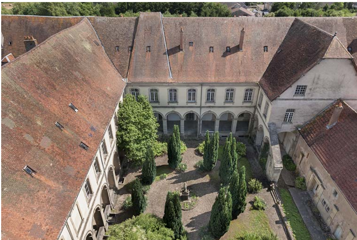
Vue rapprochée du cloître depuis le grand clocher sud-ouest.
