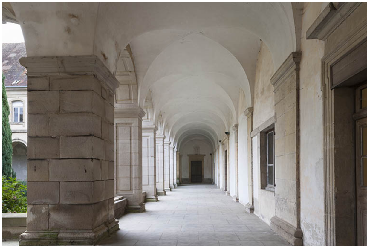
Galerie sud et un aperçu de la galerie est.
