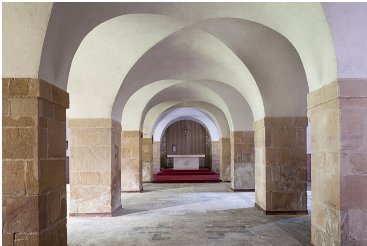
Intérieur : l'étage de soubassement aménagé en chapelle.
