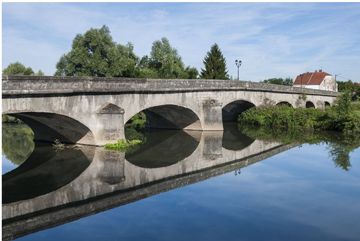
Vue générale rapprochée de trois quarts gauche depuis l'amont. 70, Faverney R.D. 434
