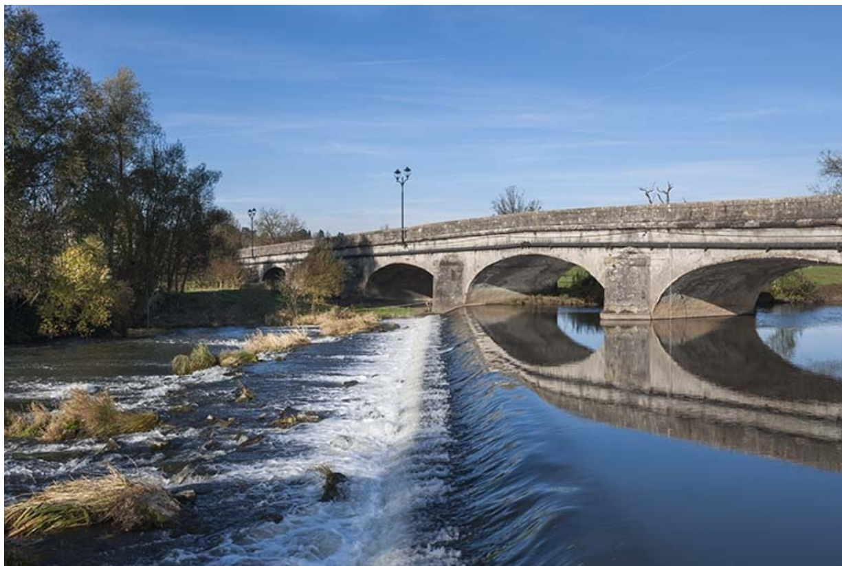
Vue générale depuis l'aval avec le barrage.
