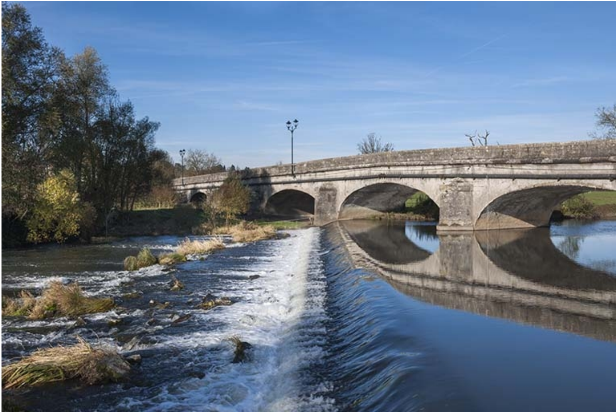
Vue générale depuis l'aval avec le barrage.
