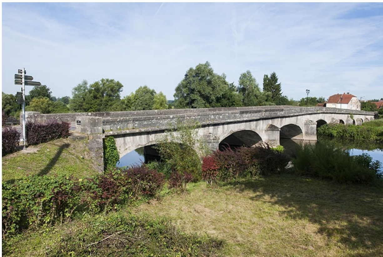
Vue générale de trois quarts gauche depuis l'amont.
