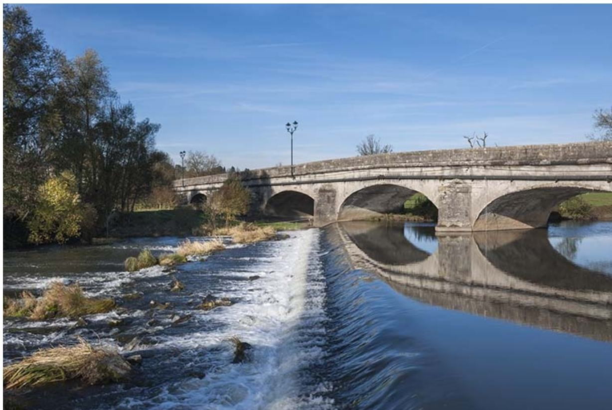
Vue générale depuis l'aval avec le barrage.
