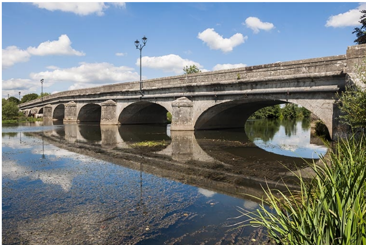
Vue générale rapprochée de trois quarts droite depuis l'aval. 70, Faverney R.D. 434
