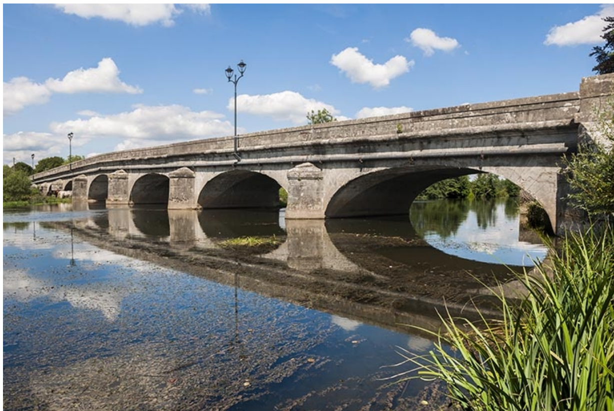
Vue générale rapprochée de trois quarts droite depuis l'aval.
