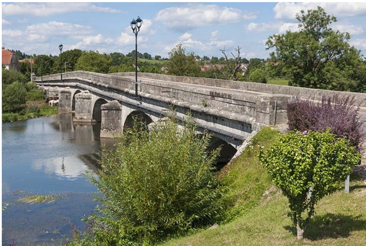
Vue générale de trois quarts gauche depuis l'amont. 70, Faverney R.D. 434
