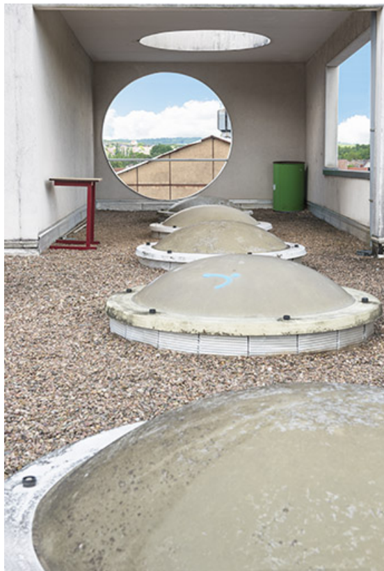
Sur la terrasse de l'externat semi-circulaire. 62, Héricourt rue Pierre Mendès France
