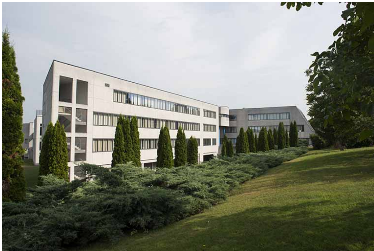
Angle sud, façade est, entrée postérieure.
