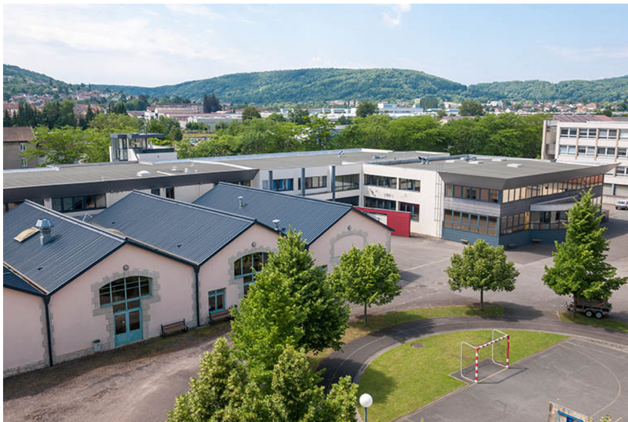
Sud-ouest de la cour et façades nord intérieure des ateliers.
