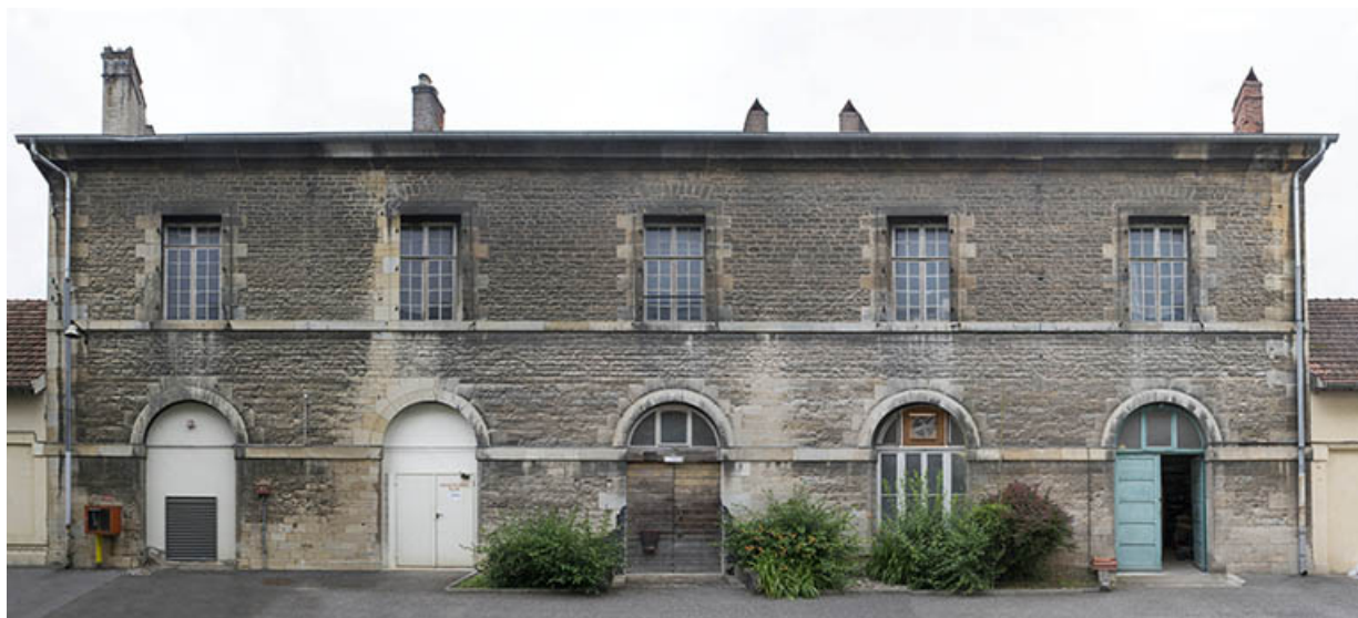
Façade antérieure de l'atelier des agents.
