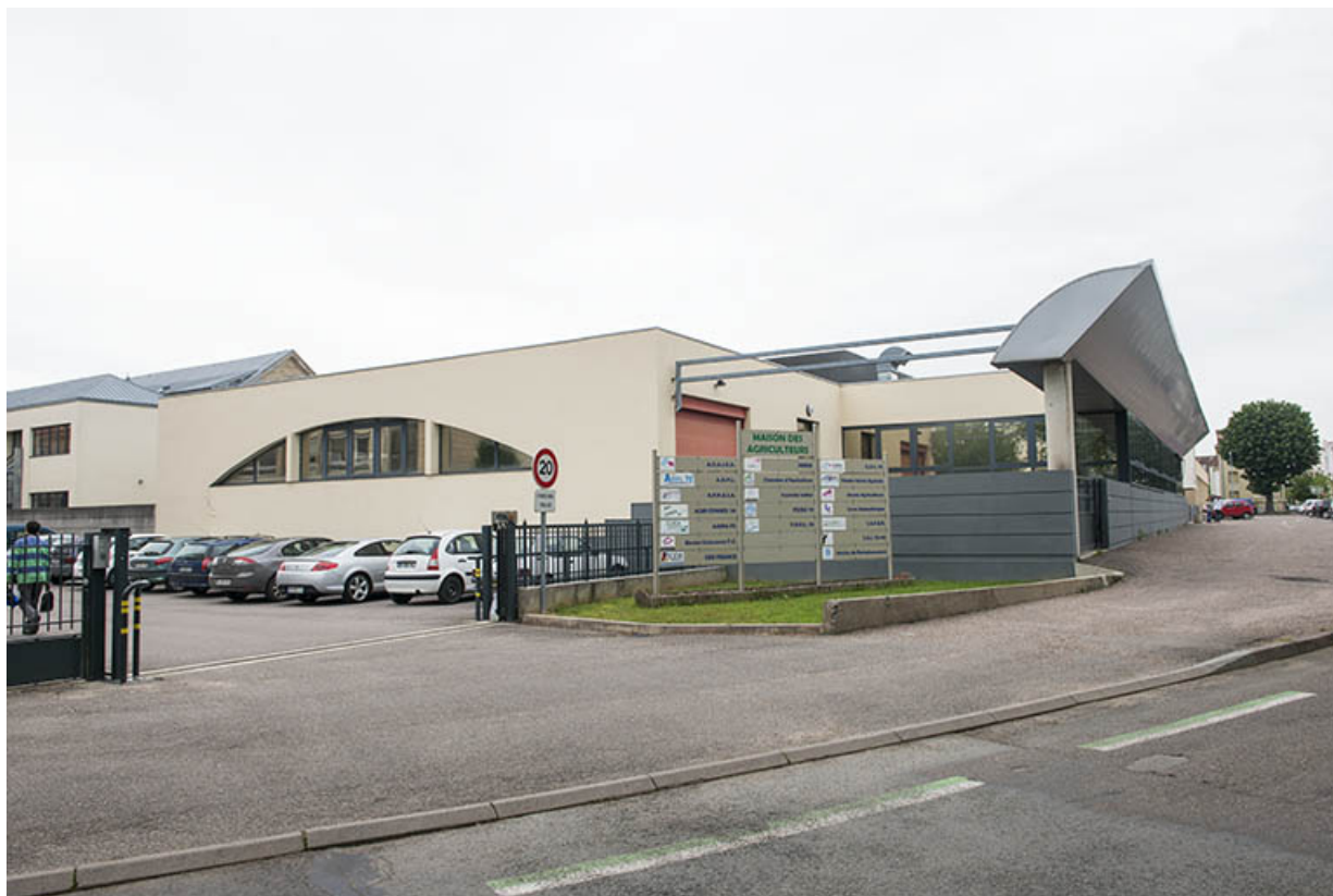
Angle sud-ouest, façade d'entrée sur le quai Barbier.
