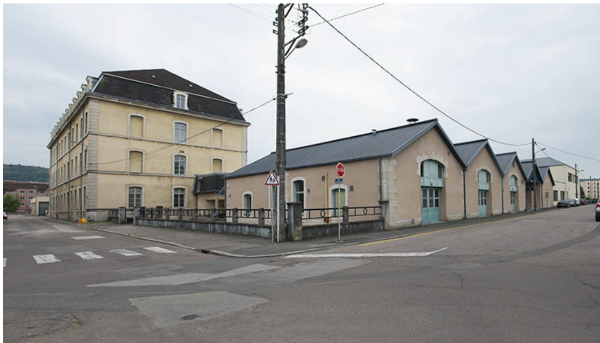
Angle nord-est sur rue, pignon est de l'administration-internat.
