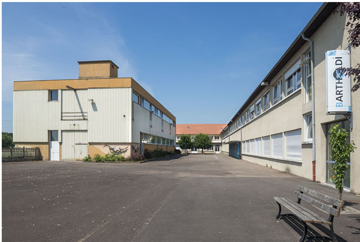
Vue de l'entrée depuis l'est.
