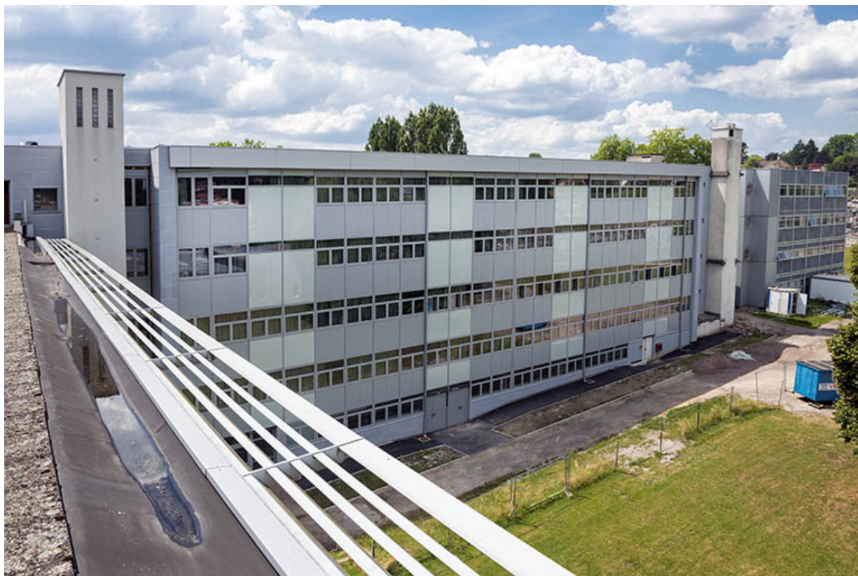
Vue des terrasses de l'internat-externat, la façade orientale de l'externat. 70, Lure, 1 rue Georges Colomb
