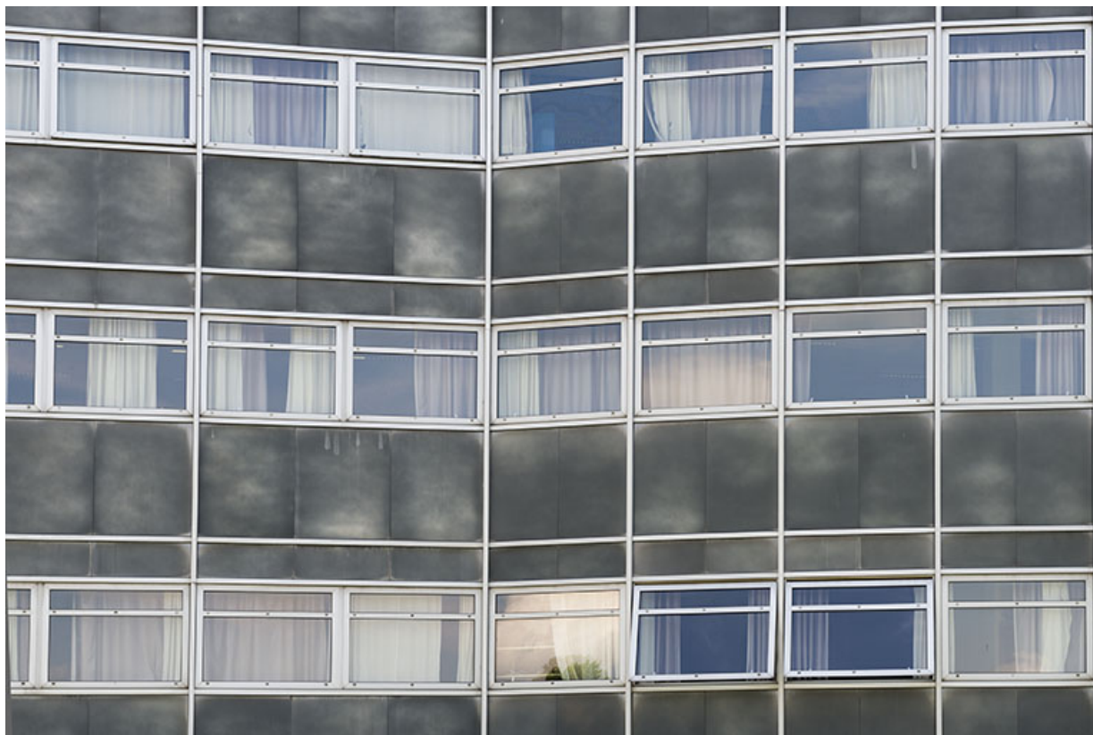
Détail de la façade ouest de l'externat nord-ouest.
