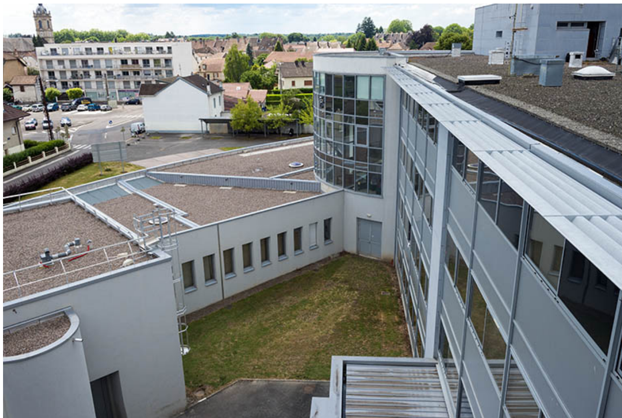
Depuis la terrasse des logements, vue sur l'articulation entre l'est de la rotonde centrale, l'internat-externat et l'administration. 70, Lure, 1 rue Georges Colomb
