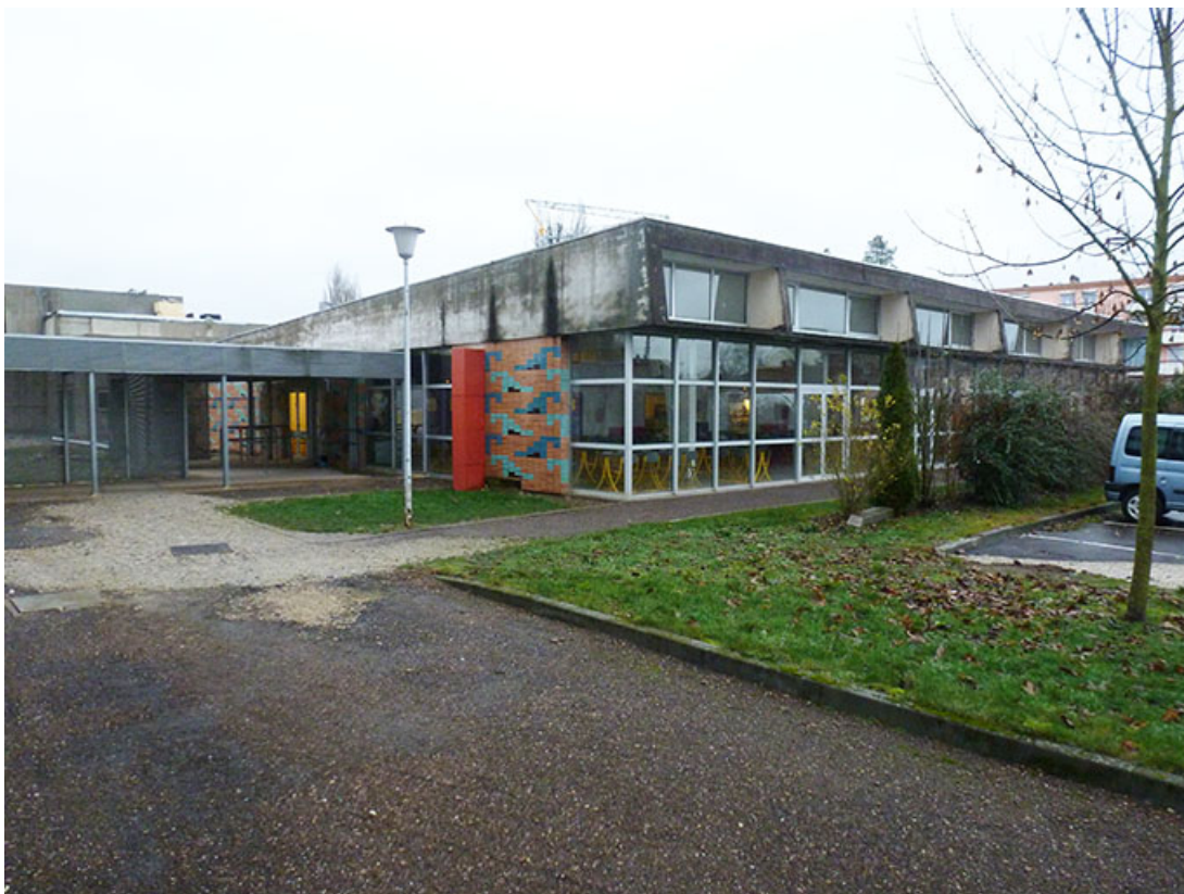
Angle sud-ouest de la cantine (en 2012)
