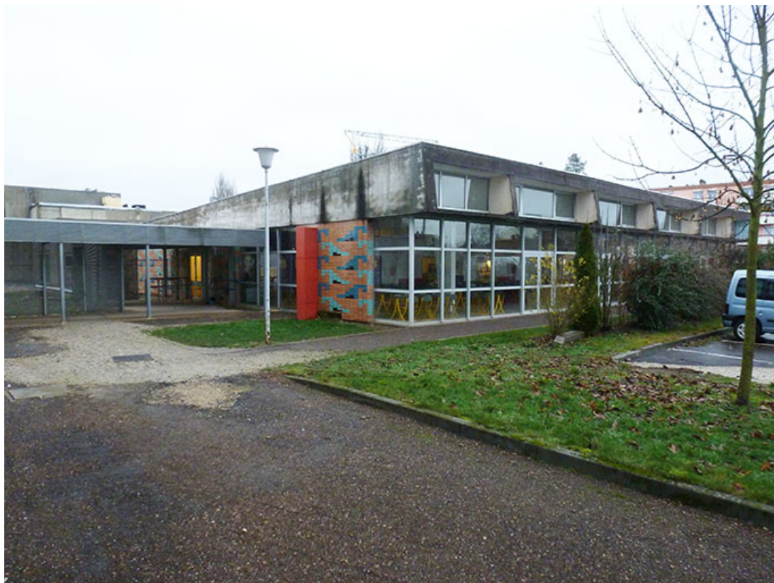
Angle sud-ouest de la cantine (en 2012)
