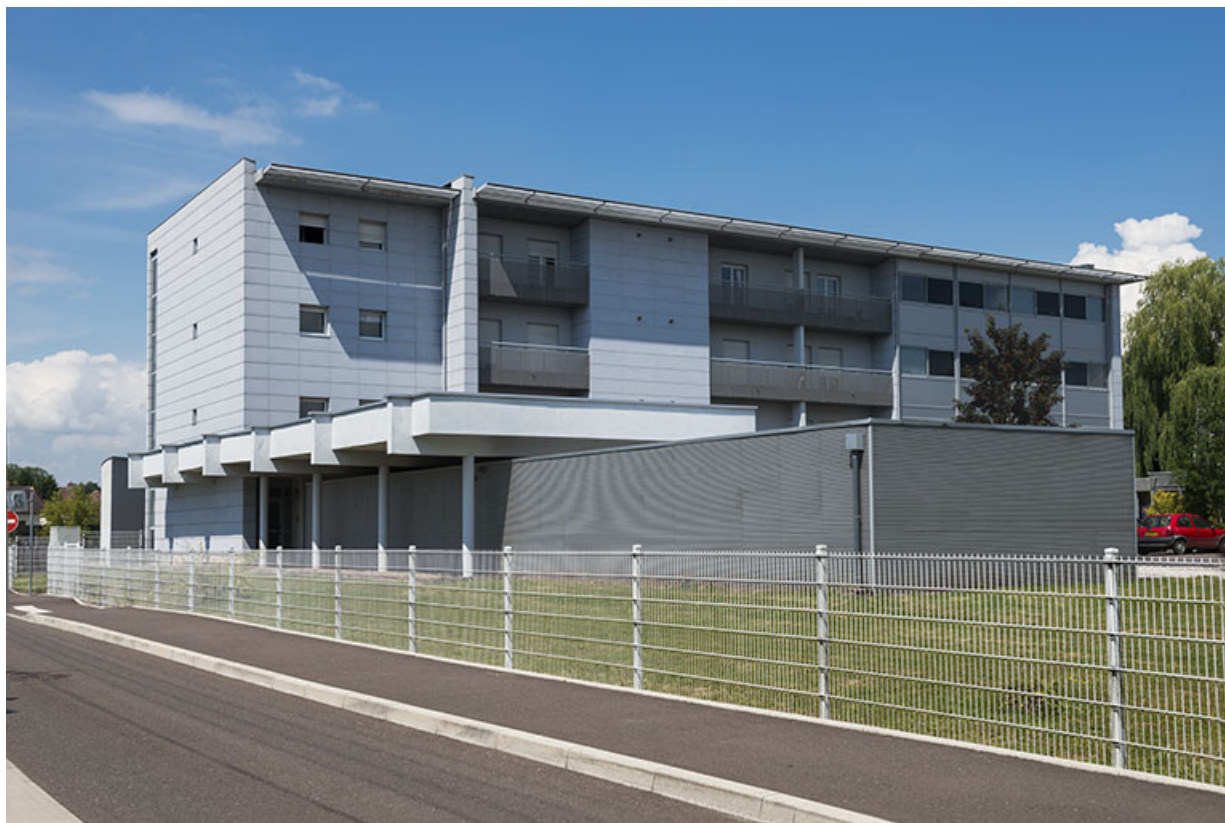
Depuis le sud-est, rue Colomb, vue sur le pignon nord-est des resserres et la façade des logements. 70, Lure, 1 rue Georges Colomb
