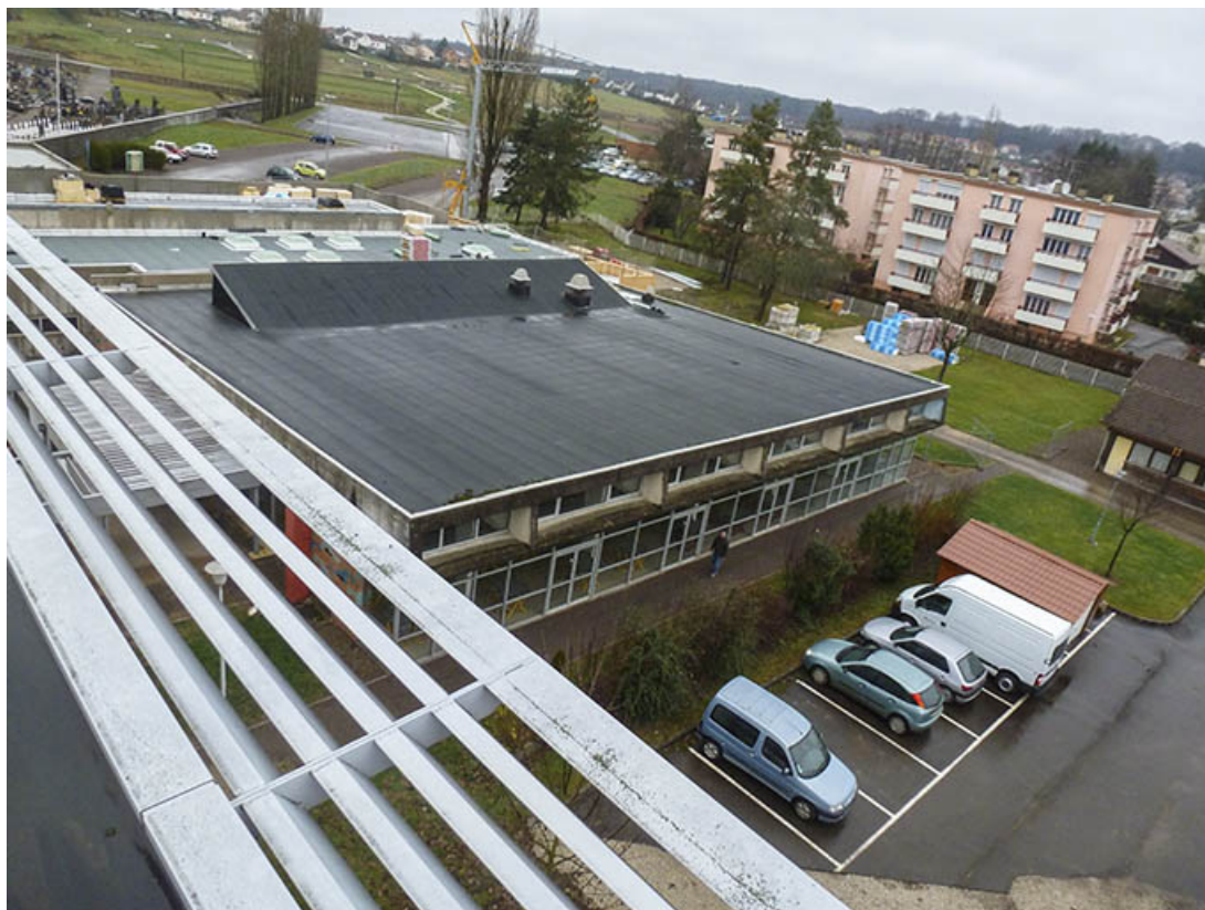
Depuis les toitures, vue sur la cantine (en 2012). 70, Lure, 1 rue Georges Colomb
