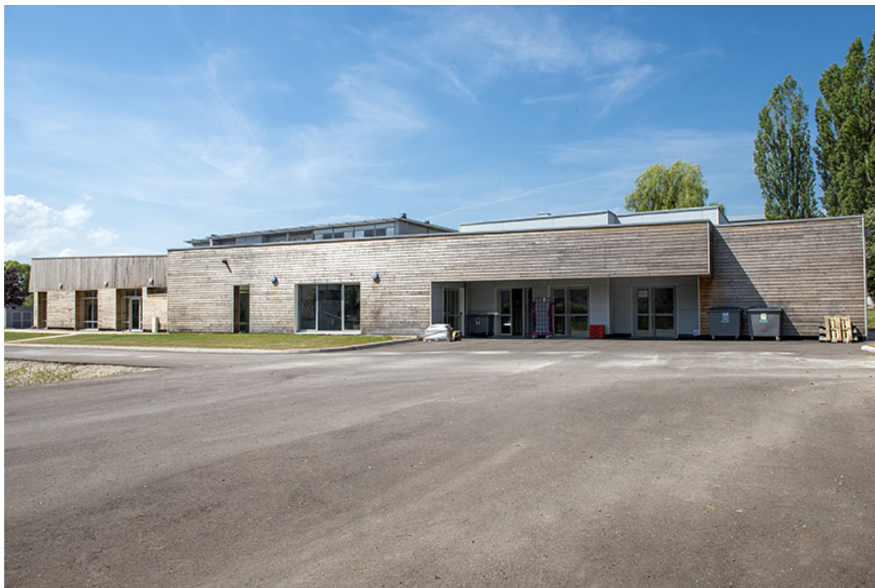
Façade nord-est de la cantine.
