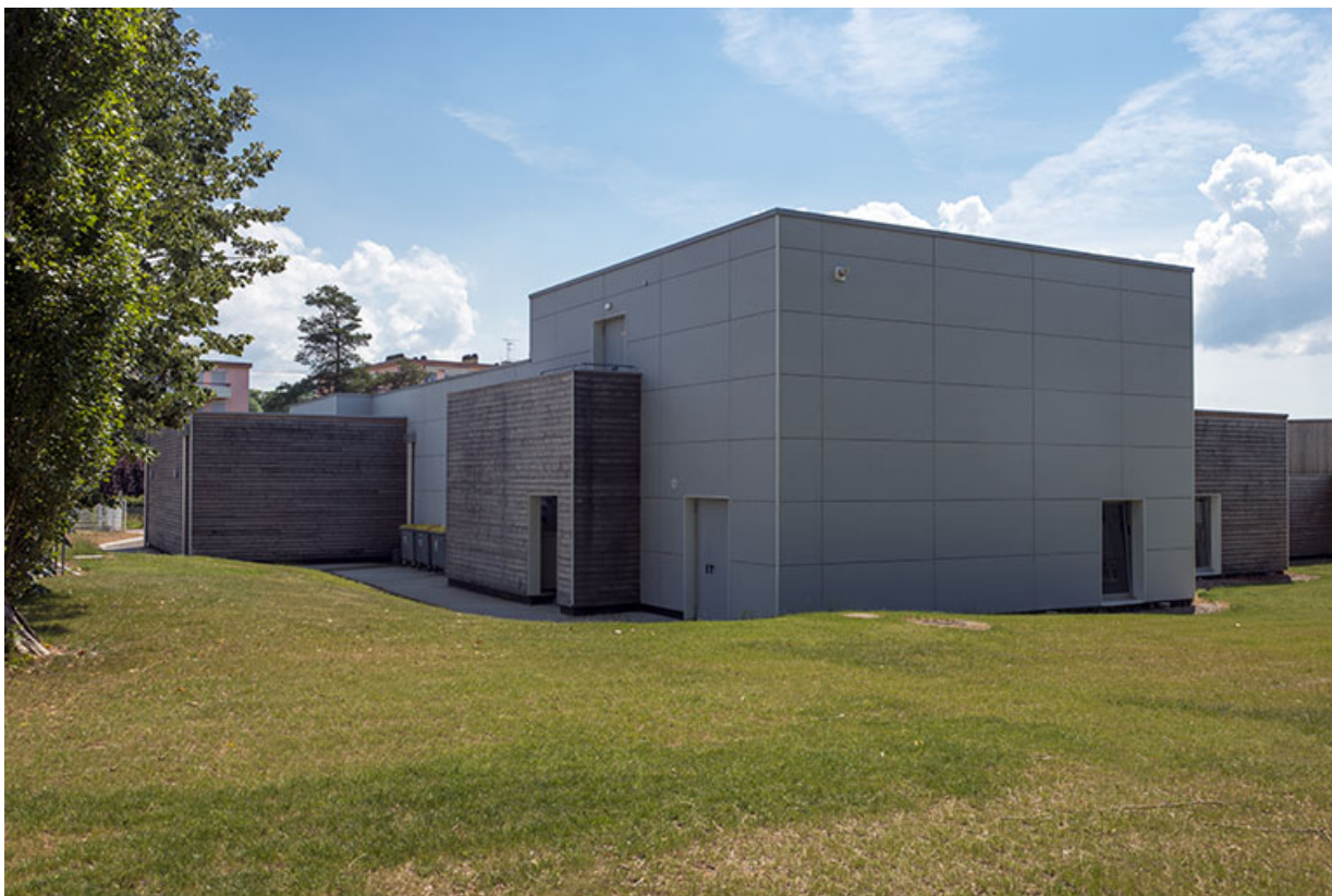
Angle nord-ouest et façades postérieures nord de la cantine.
