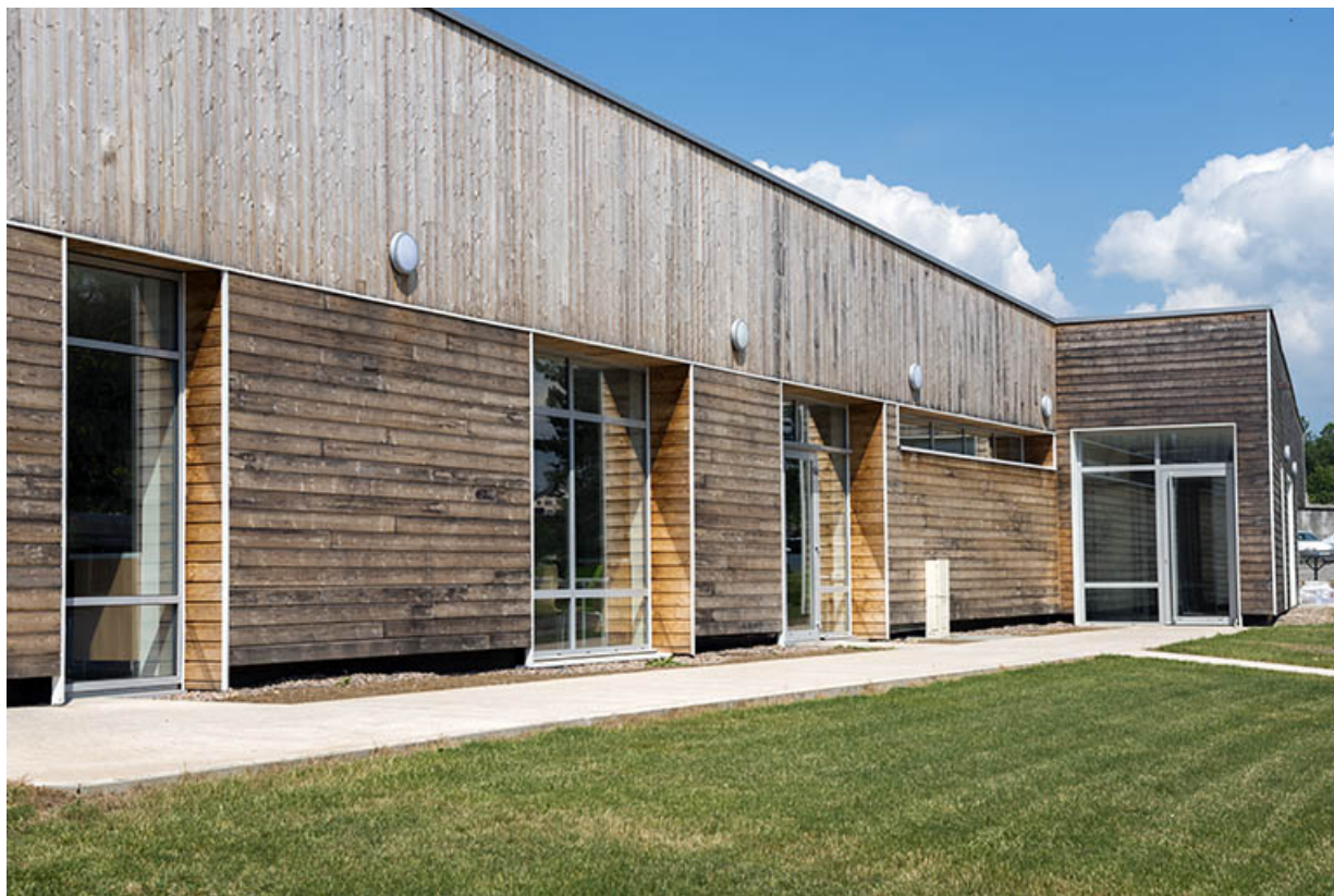
Détail de la façade est de la cantine.
