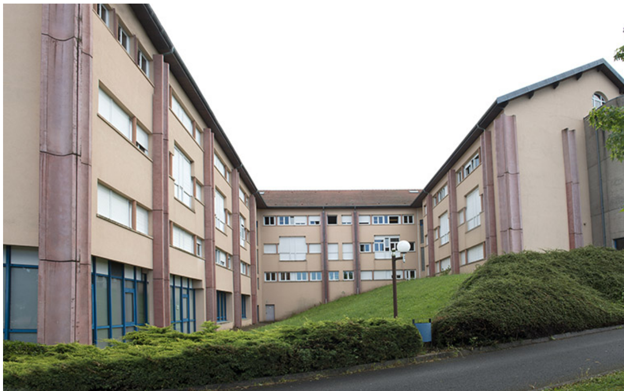
Détail de la façade sud-ouest de l'externat.
