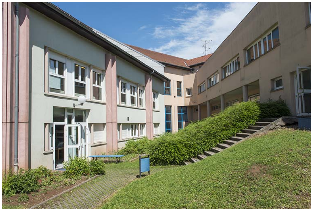
Façade postérieure est du centre de documentation et d'information et façade ouest du bâtiment d'enseignement technologique hôtelier.
