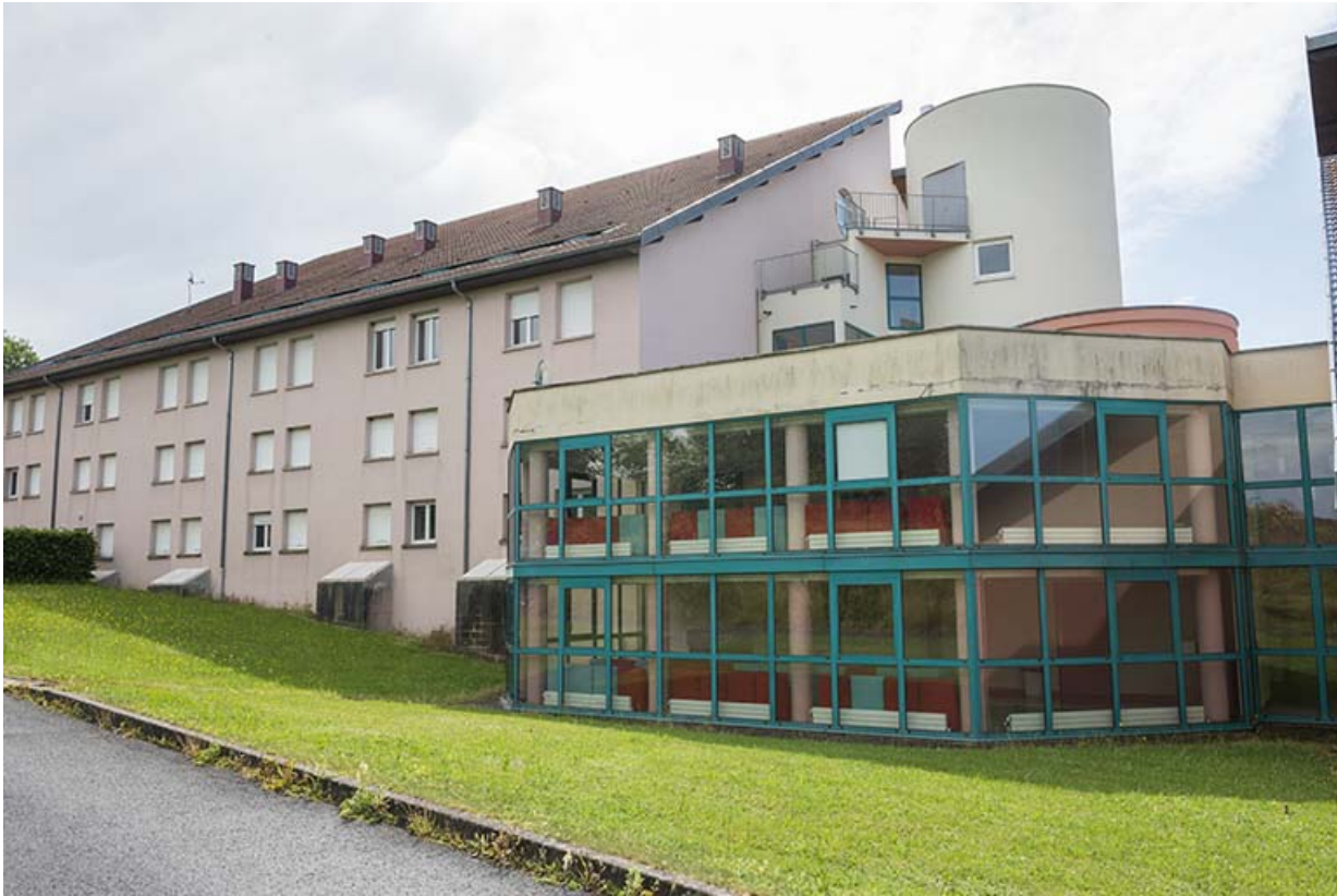
Façades postérieures nord de l'internat nord-est.
