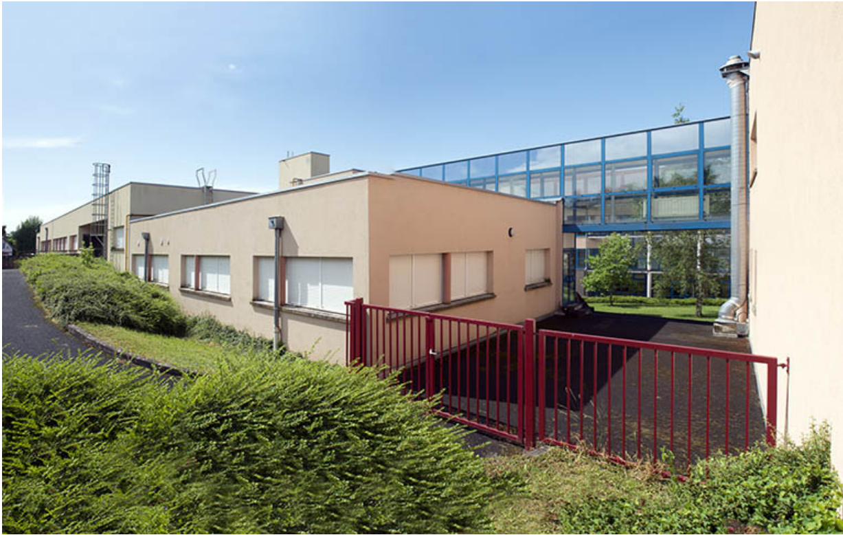
Angle nord et façade postérieure est des bâtiments d'enseignement technologique hôtelier. 70, Luxeuil-les-Bains, 33 ter rue Grammont
