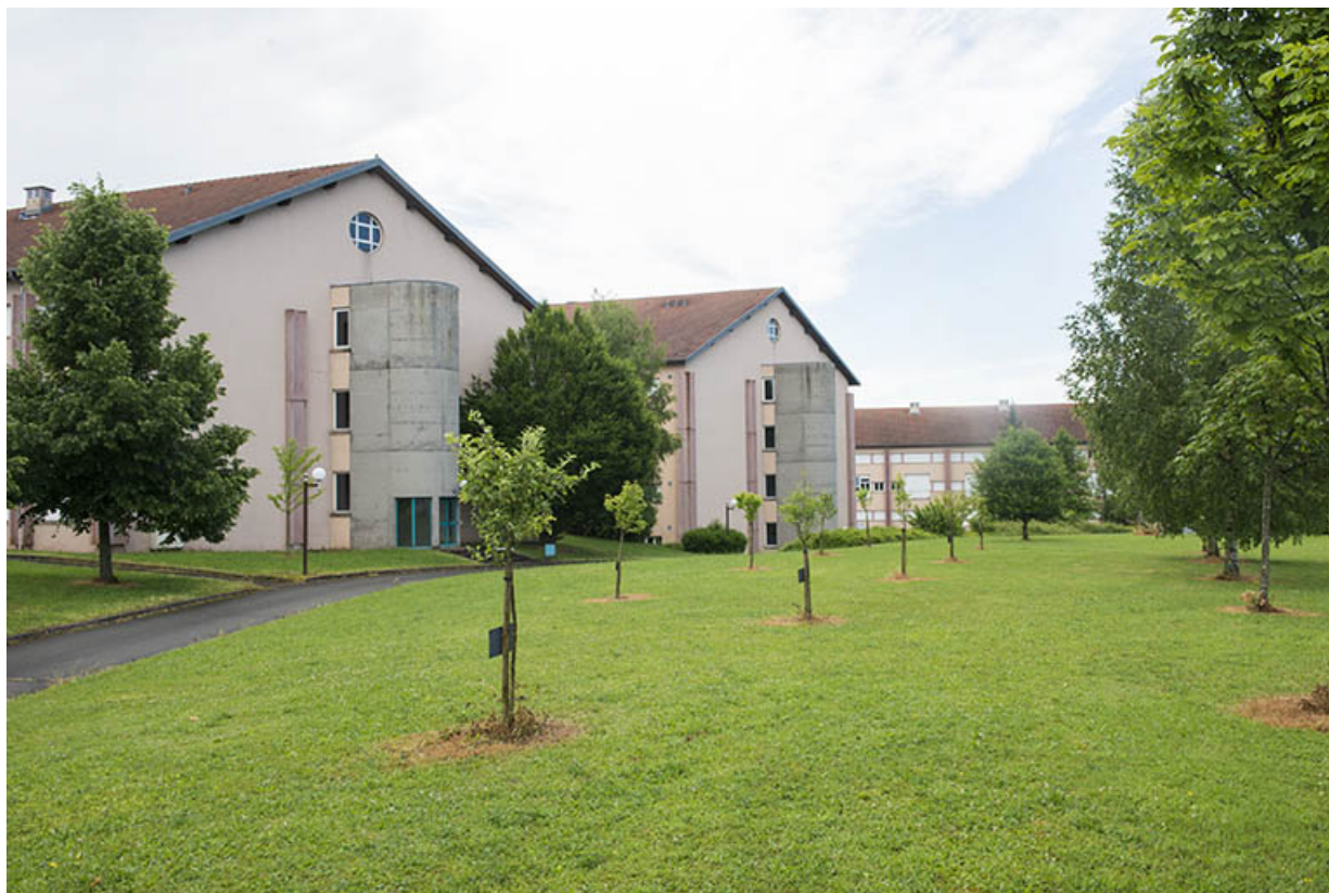
Les pignons sud-ouest de l'externat d'enseignement scientifique avec leurs cages d'escaliers en béton. 70, Luxeuil-les-Bains, 33 ter rue Grammont
