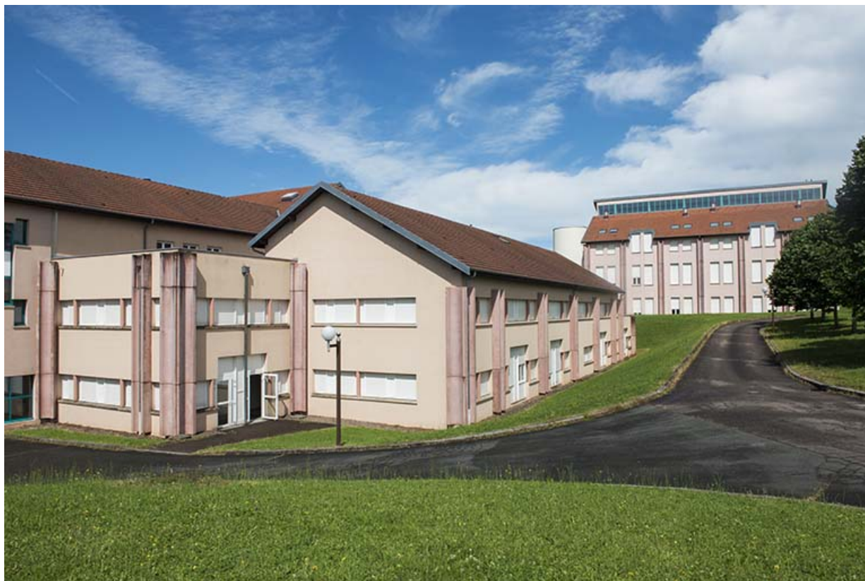
Angle sud-est du bâtiment d'enseignement scientifique et façade antérieure de l'internat.
