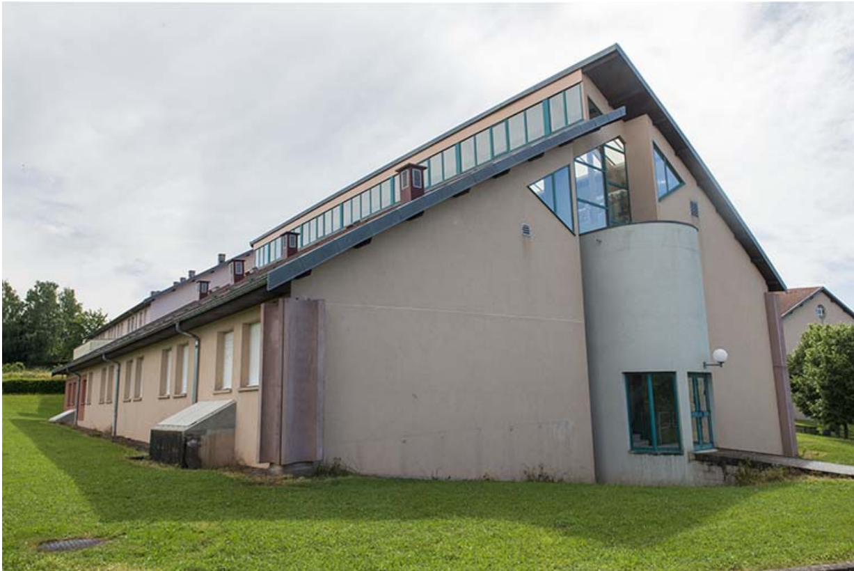
Pignon ouest de l'internat sud-ouest.
