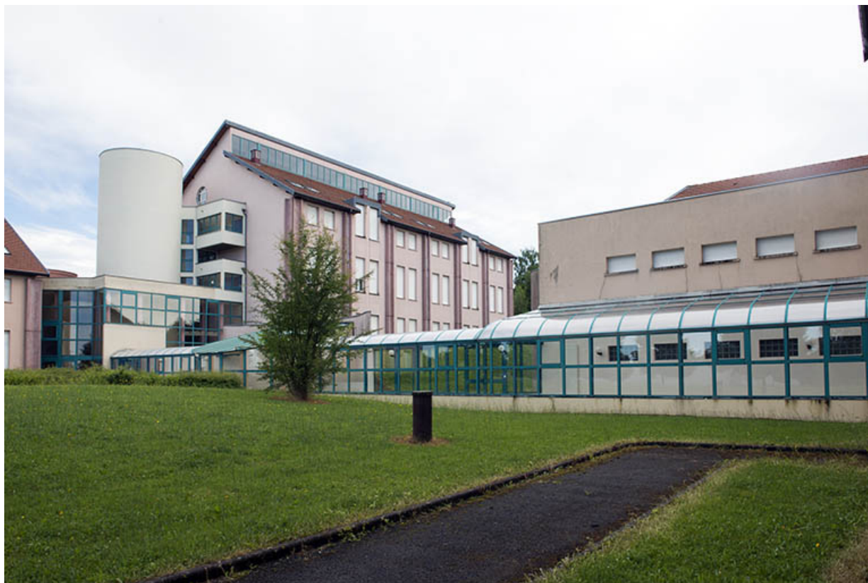
Façade antérieure sud de l'internat nord-est et passages couverts les desservant.
