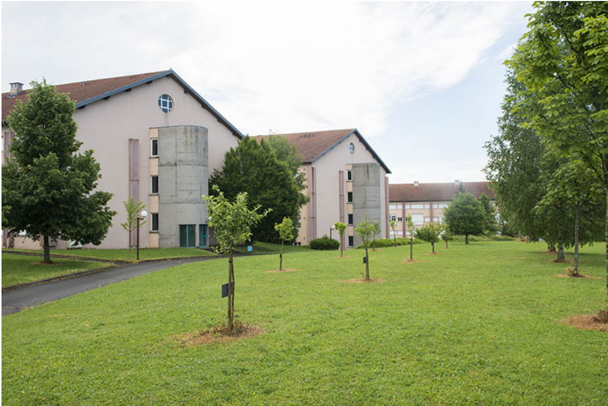
Les pignons sud-ouest de l'externat d'enseignement scientifique avec leurs cages d'escaliers en béton. 70, Luxeuil-les-Bains, 33 ter rue Grammont
