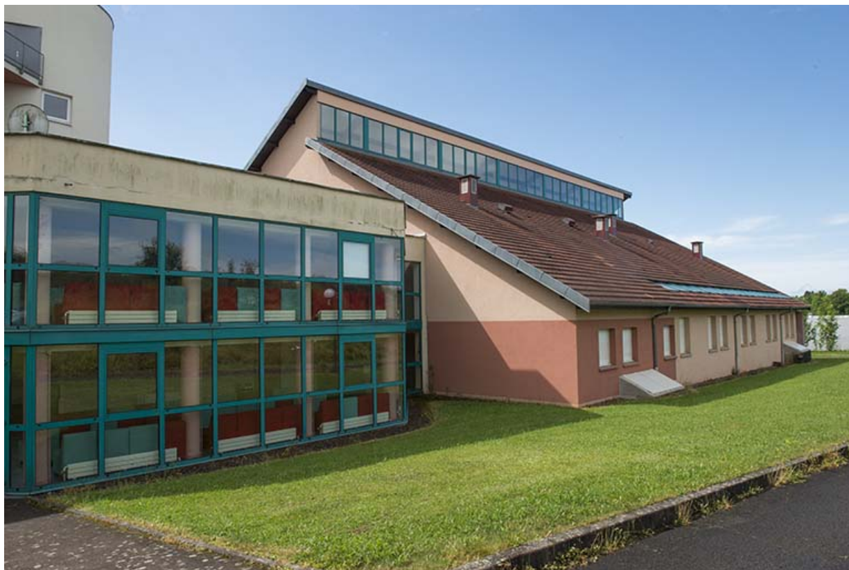
Façades postérieures nord de l'internat sud-ouest.
