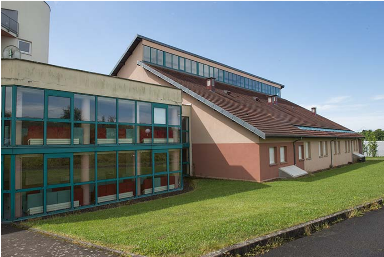
Façades postérieures nord de l'internat sud-ouest.
