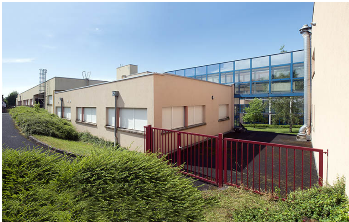
Angle nord et façade postérieure est des bâtiments d'enseignement technologique hôtelier. 70, Luxeuil-les-Bains, 33 ter rue Grammont
