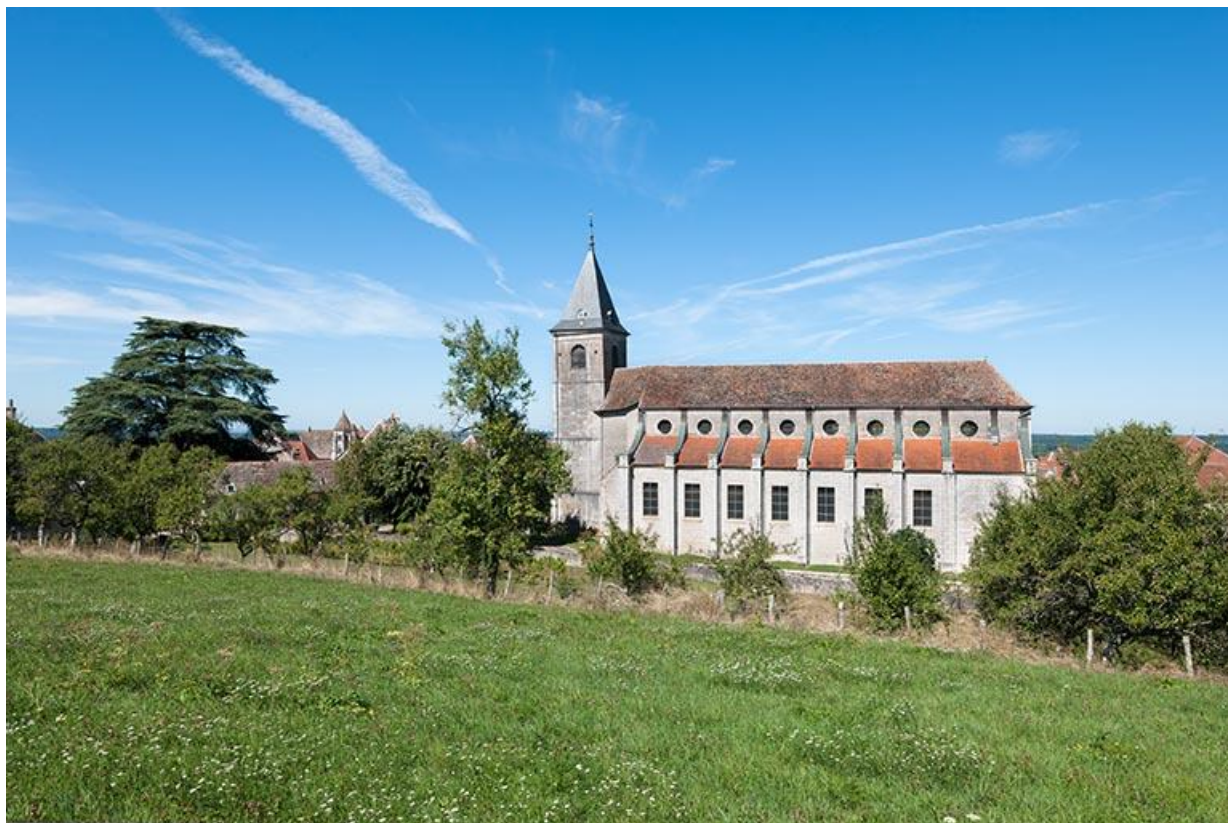
Vue générale sud de l'église
