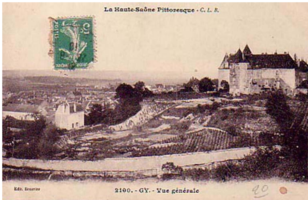
Vue générale ouest
