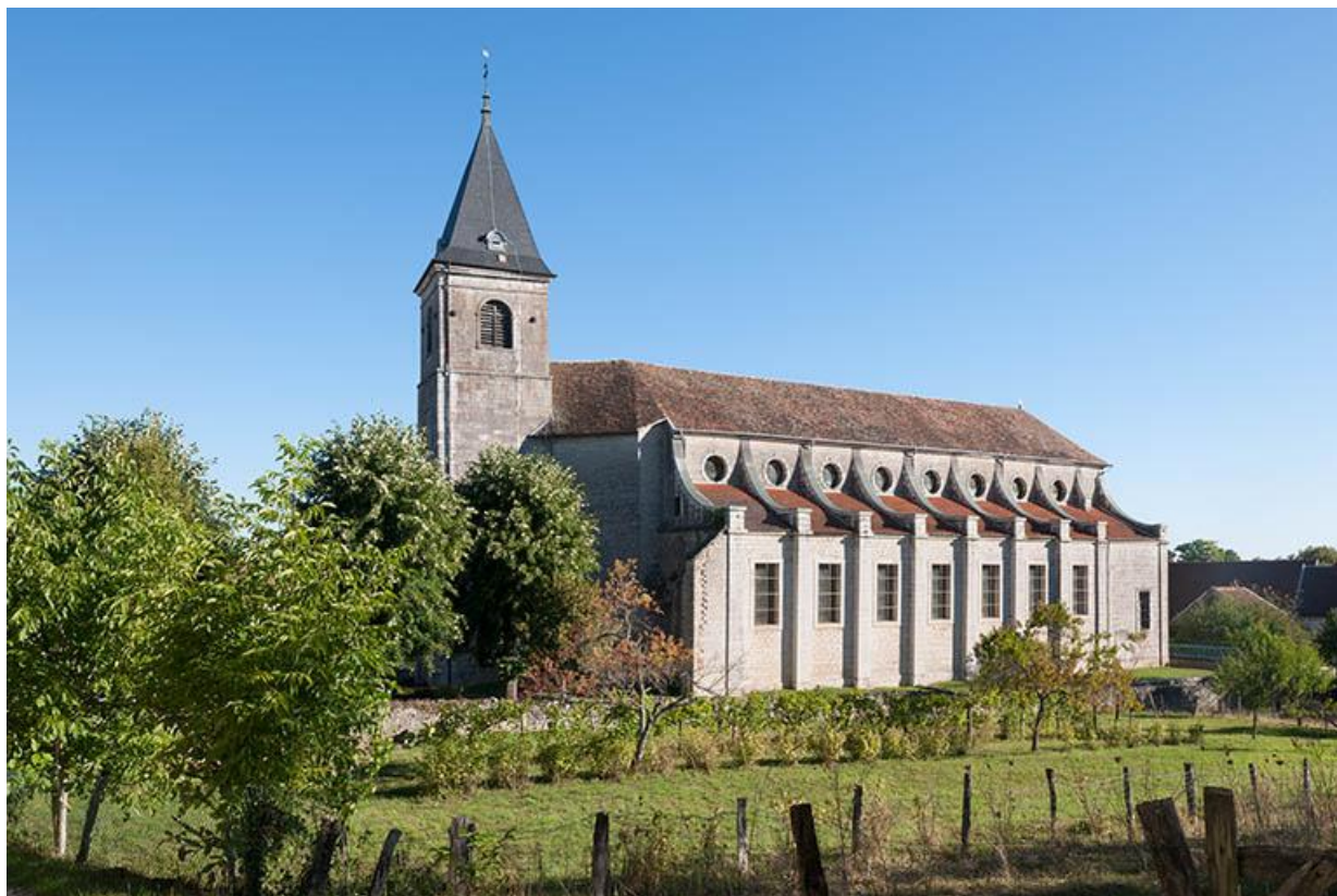
Vue sud-ouest de l'église
