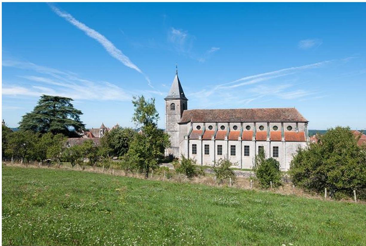
Vue générale sud de l'église
