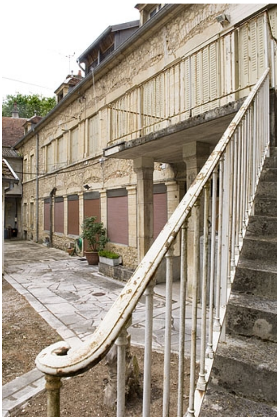
Façade antérieure du logement (atelier de fabrication primitif ?). 70, Gray, 28 rue Victor Hugo
