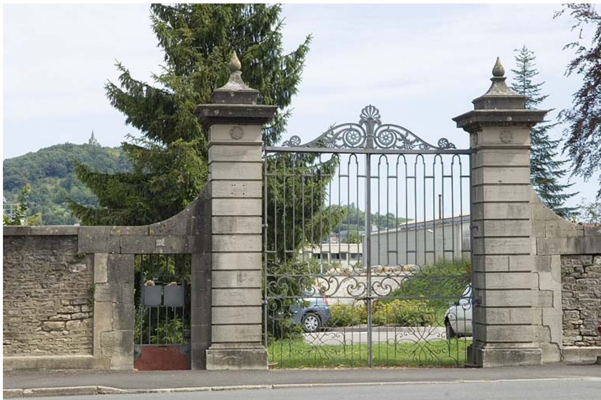
Grille d'entrée de l'ancien logement patronal.
