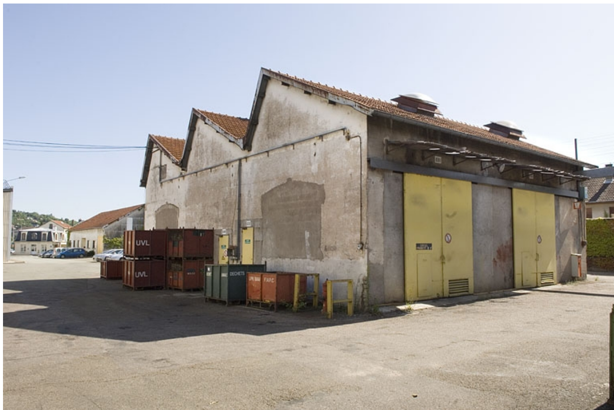
Salle des machines et chaufferie (usine Dollé). 70, Vesoul, 24 rue d' Echenoz
