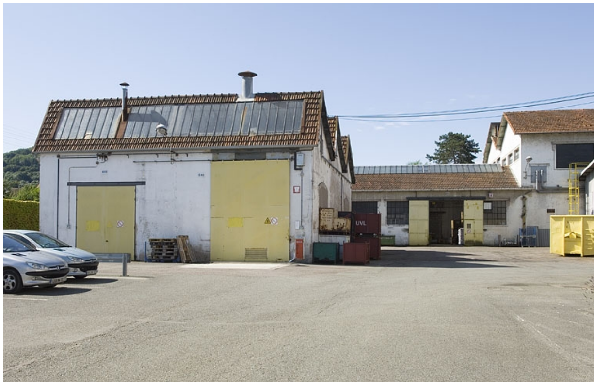
Salle des machines et chaufferie, et atelier de fonderie (usine Dollé).
