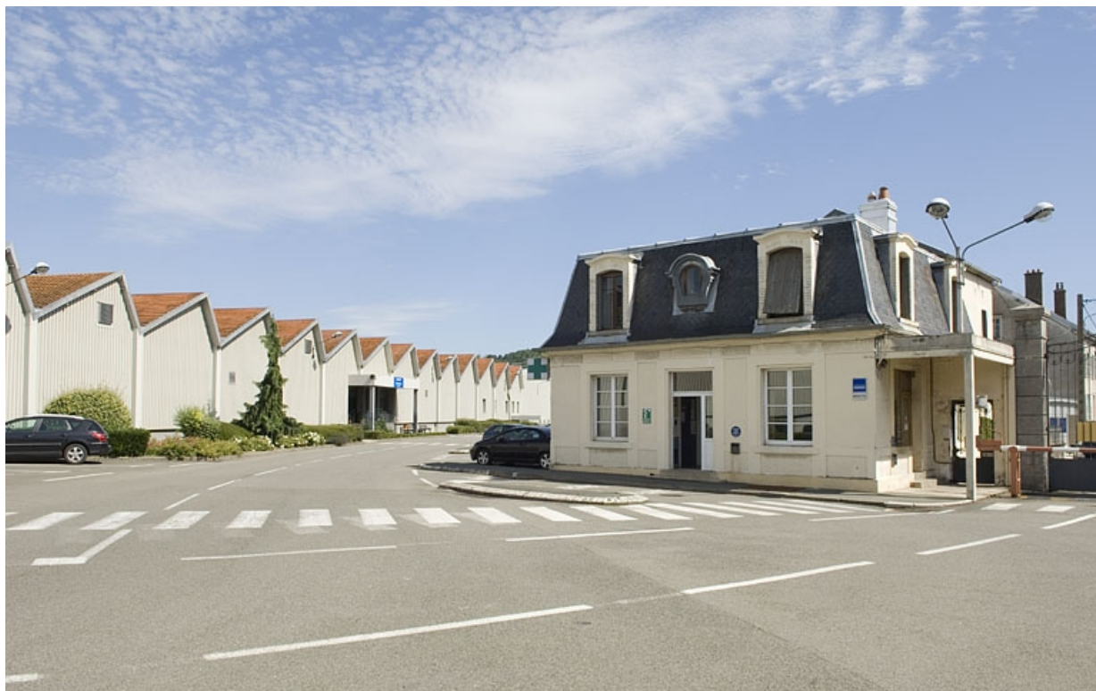
Atelier de fabrication et conciergerie (actuellement infirmerie).
