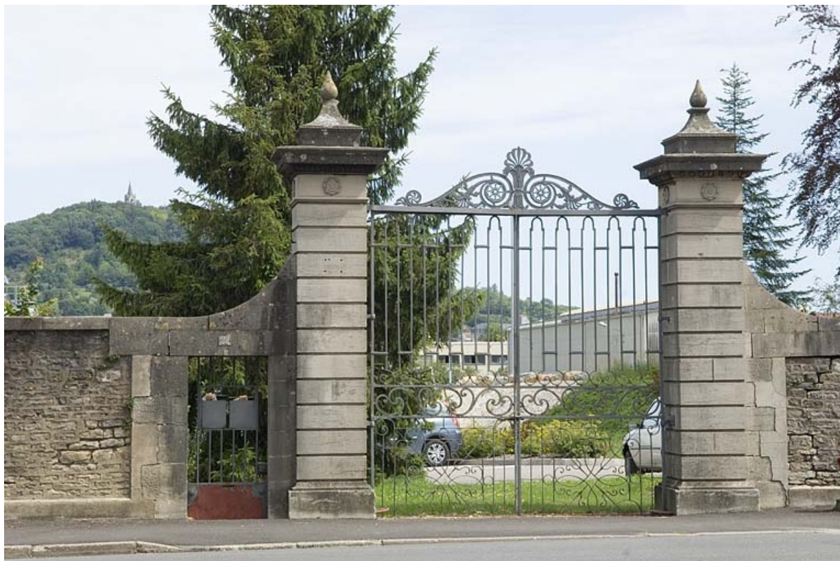
Grille d'entrée de l'ancien logement patronal.
