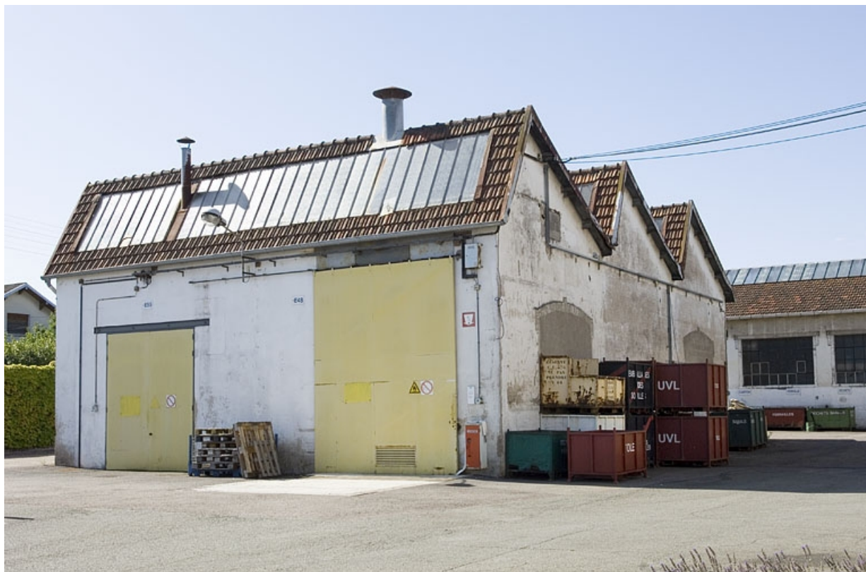
Salle des machines et chaufferie, depuis le nord (usine Dollé).
