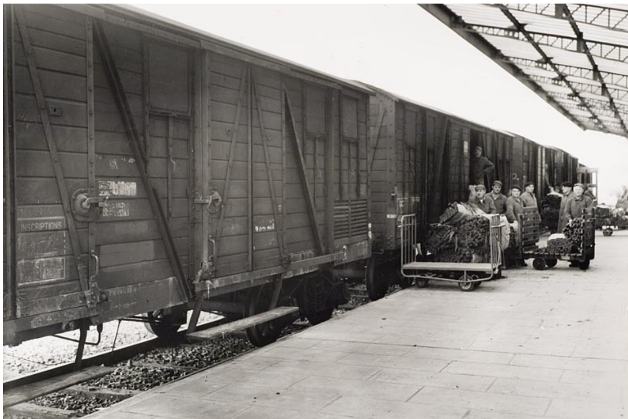
Quai de l'embranchement ferroviaire. Déchargement d'une rame de wagons d'une récolte provenant d'un centre d'achat extérieur. 70, Vesoul, 53 rue Jean Jaurès
