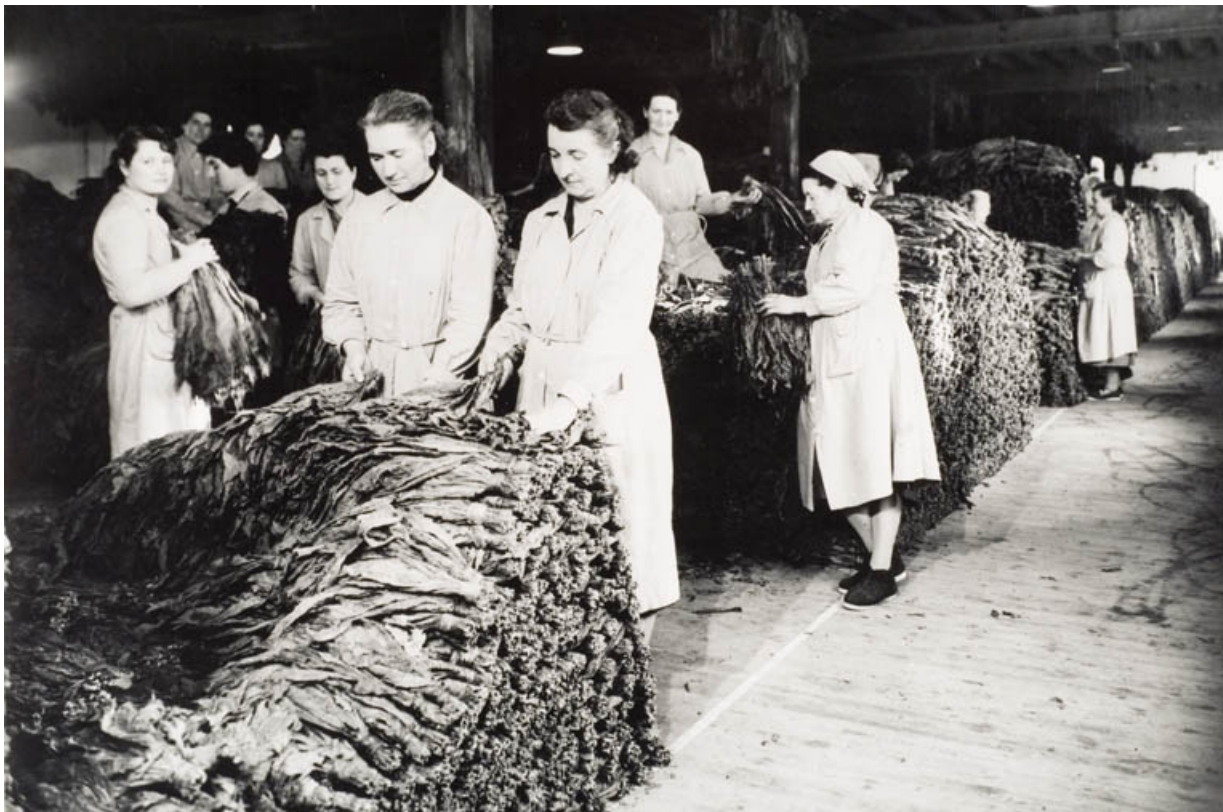
Bâtiment d'exploitation C. Masses de fermentation entièrement constituées. Travaux de retournement avec secouage par le personnel féminin.
