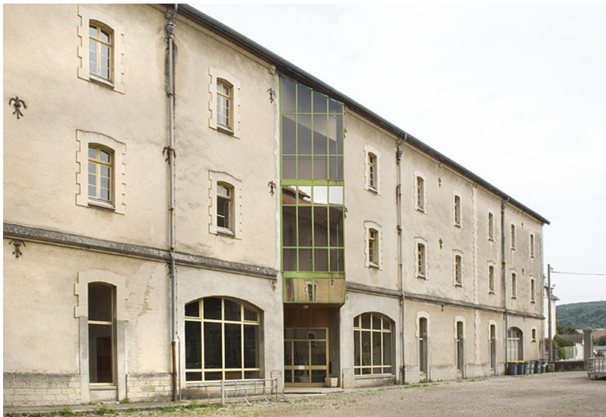
Vue depuis la cour. Élévation de l'aile est.
