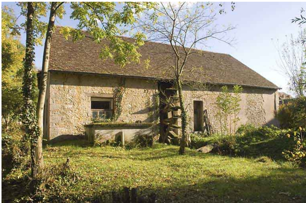
Façade postérieure du moulin.
