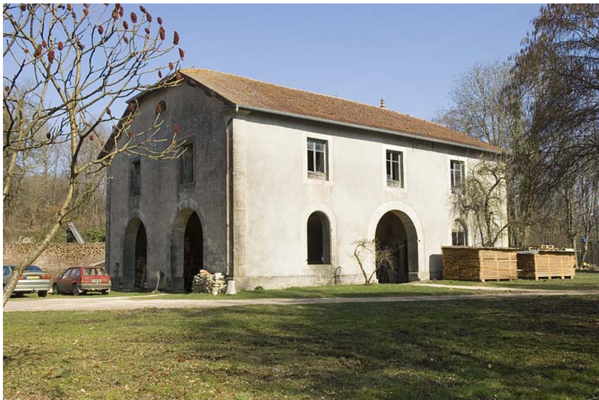
Bâtiment du haut fourneau depuis le sud.
