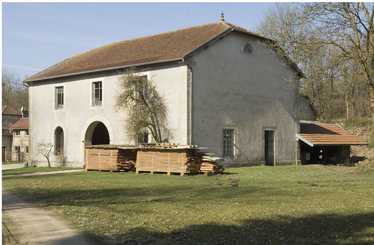
Bâtiment du haut fourneau depuis le sud-est.
