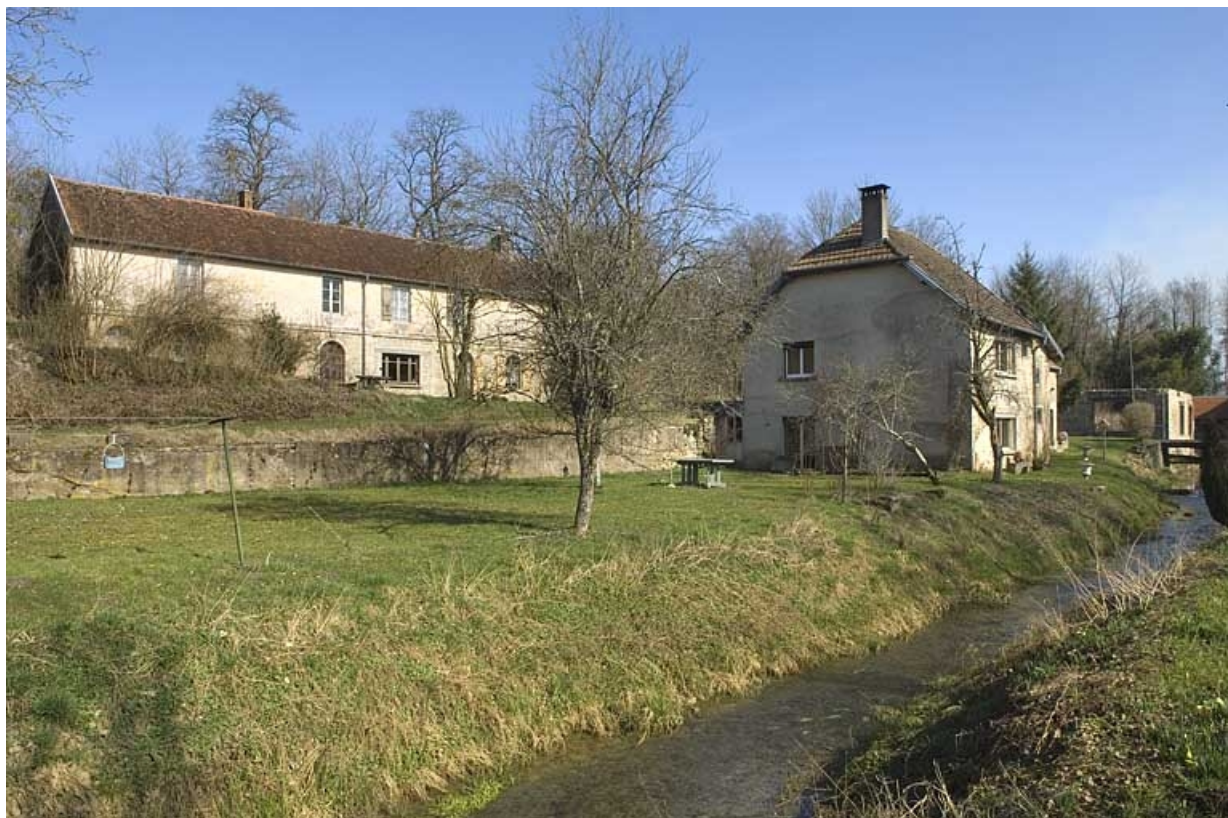
Vue d'ensemble des logements depuis le sud-ouest.
