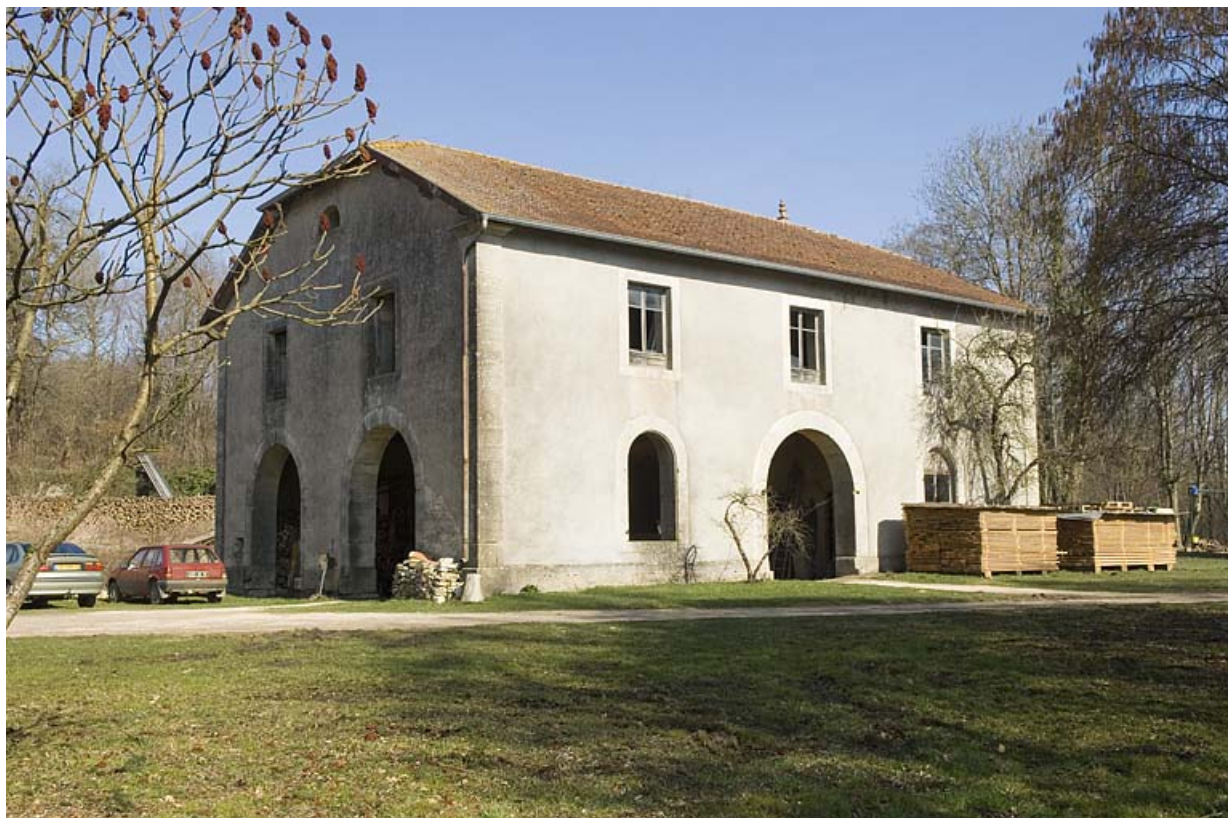
Bâtiment du haut fourneau depuis le sud.
