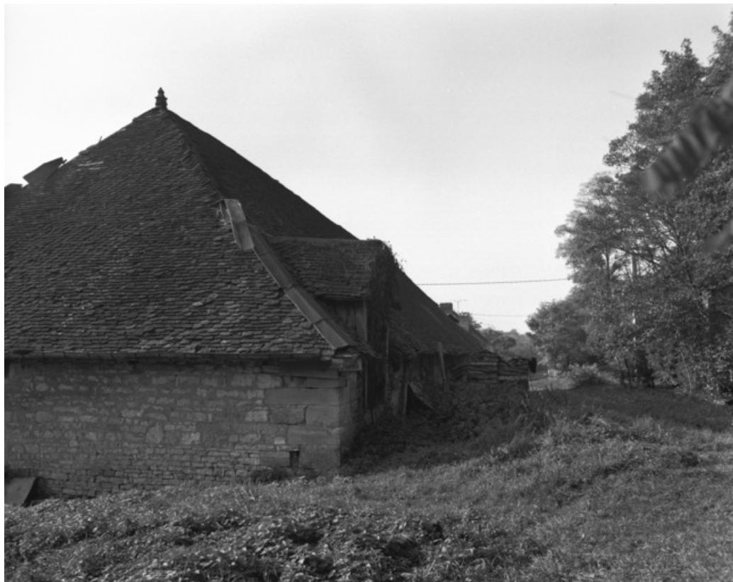
Halle à charbon vue depuis le nord-est en 1989.
