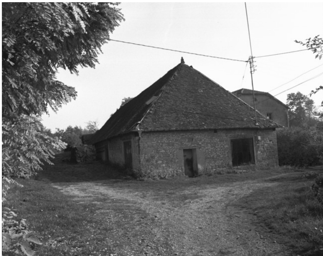
Vue de trois quarts de la halle à charbon en 1989.
