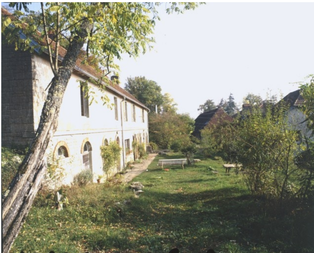
Logement ouvrier, halle à charbon et logement en 1989.
