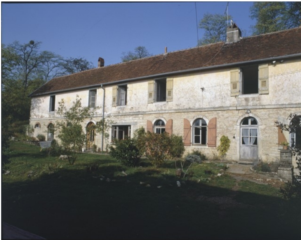
Logement ouvrier en 1989. Vue de trois quarts droit.
