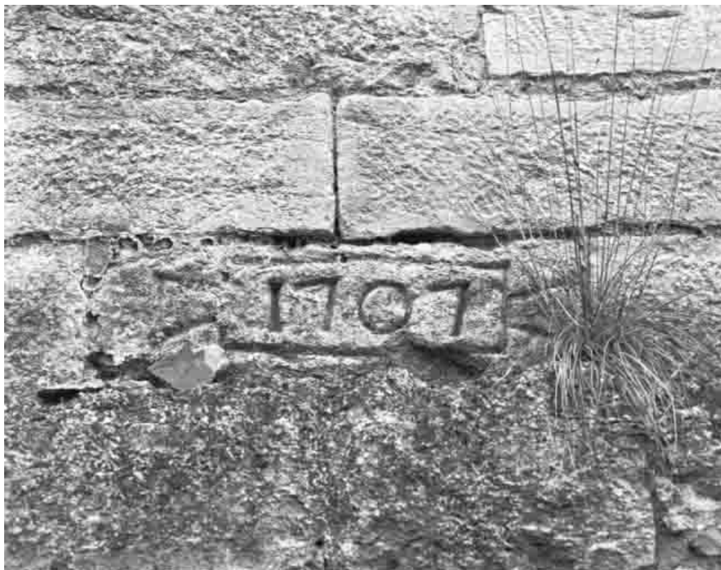
Façade nord du haut fourneau. Pierre avec cartouche millésimé en 1989.
