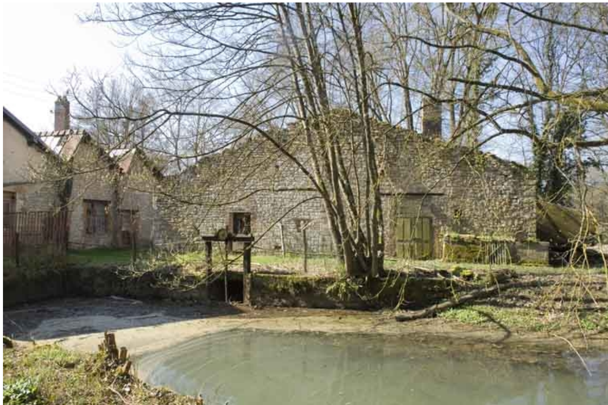
Bief d'aménée et pignon de l'entrepôt industriel (?).
