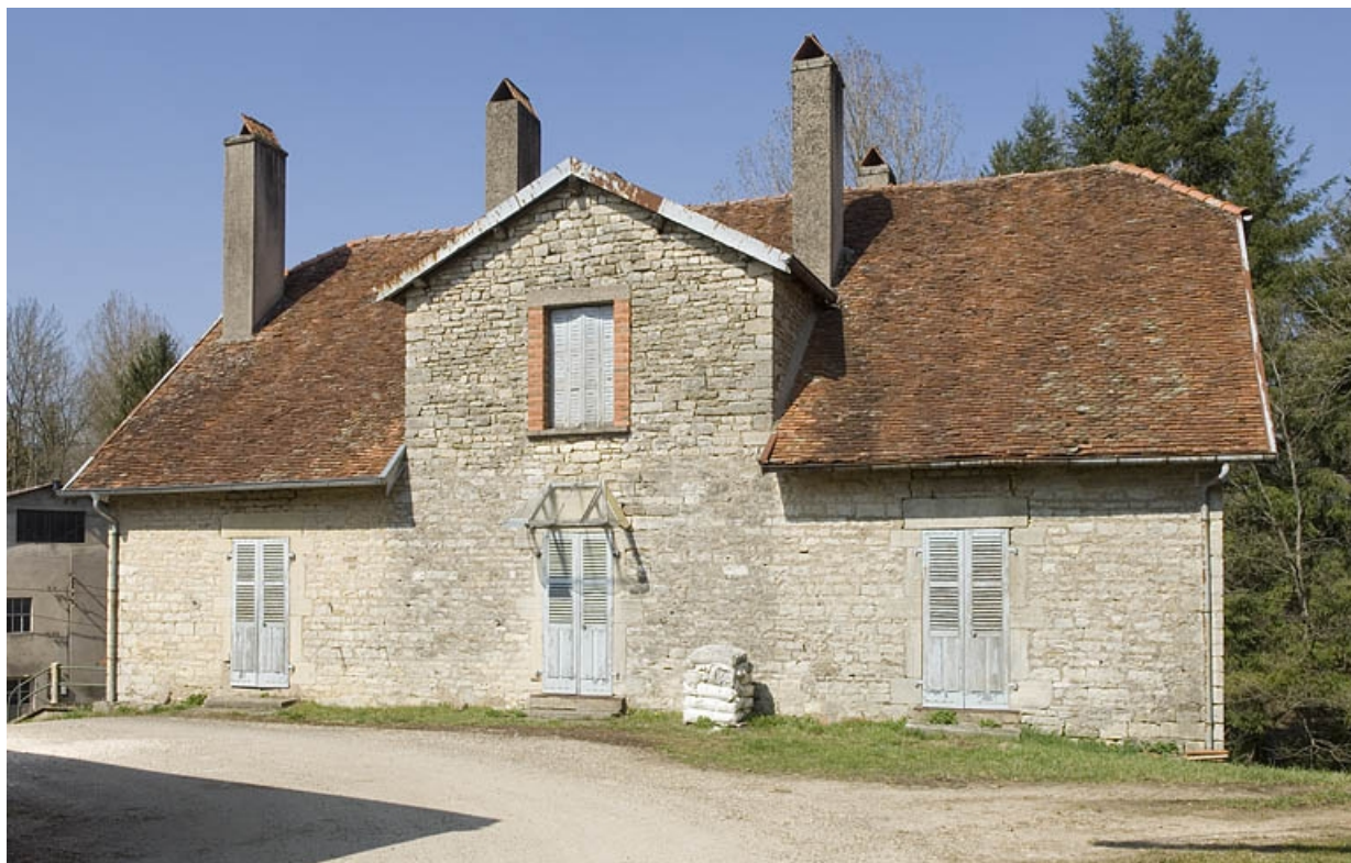
Façade sud du logement ouvrier.
