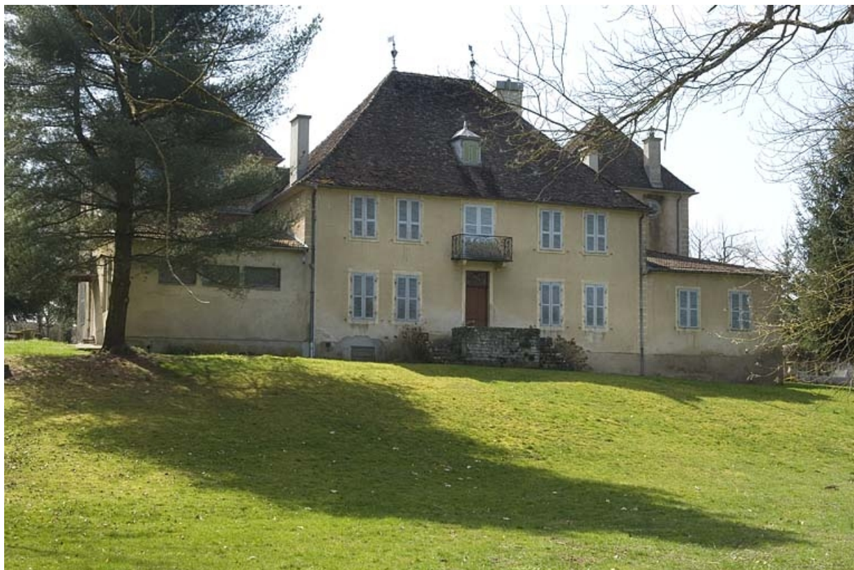
Façade postérieure du logement patronal.
