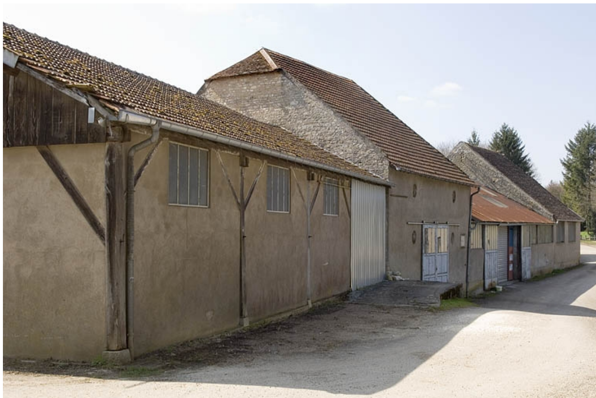
Façade nord de l'ancienne halle à charbon.
