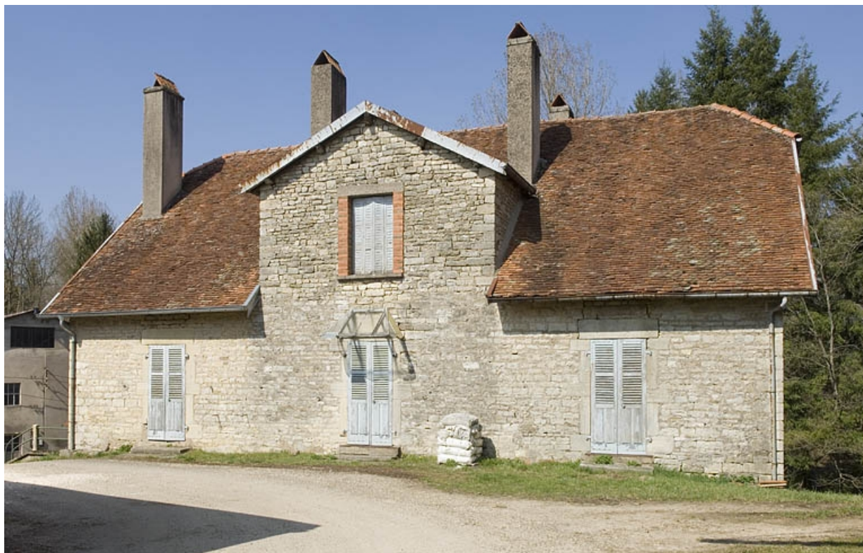
Façade sud du logement ouvrier.
