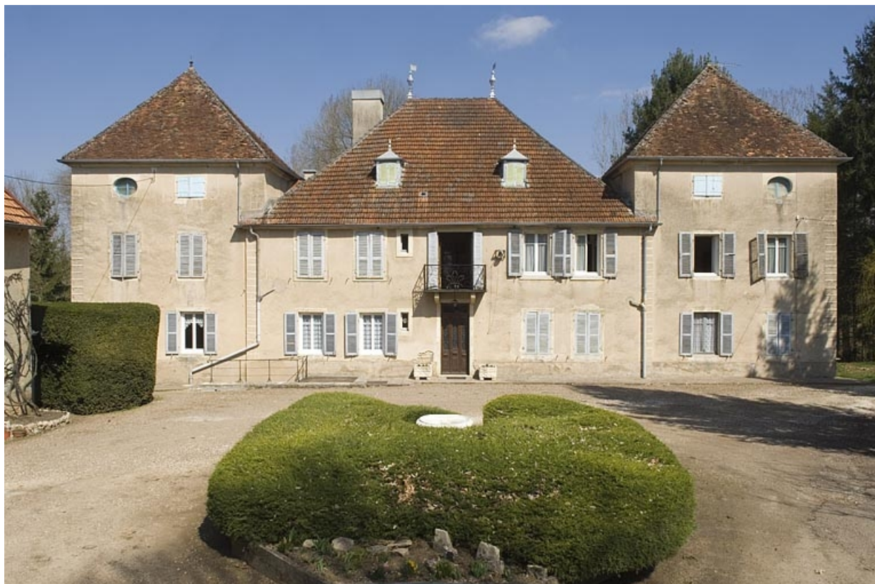
Façade antérieure du logement patronal.
