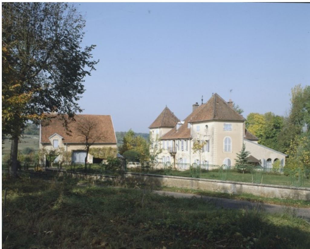
Vue d'ensemble depuis l'est du logement patronal en 1989.
