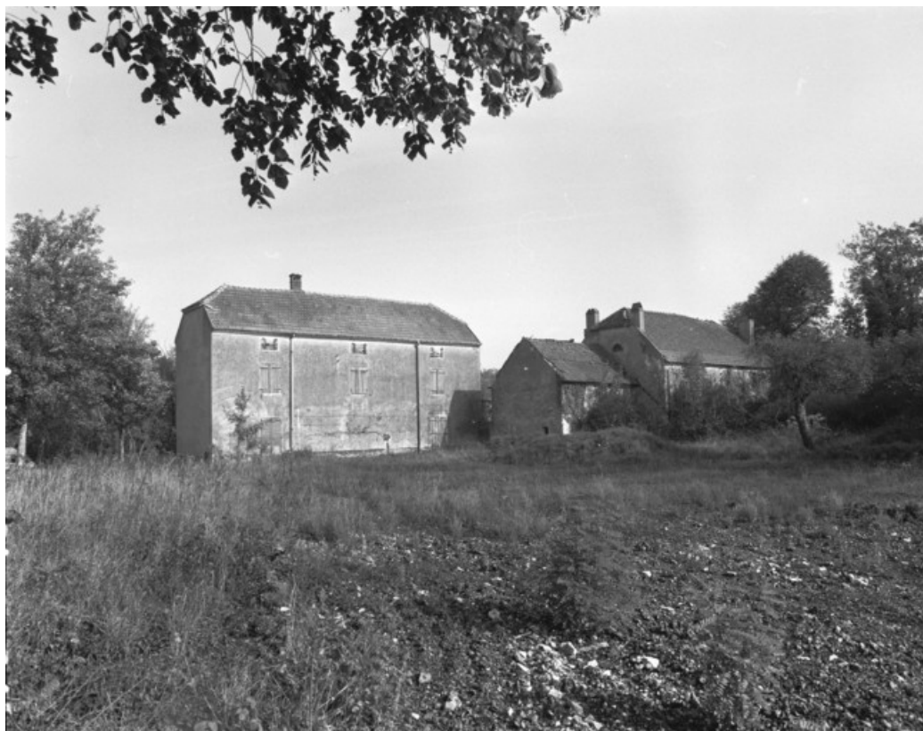
Logements ouvriers vus de trois quarts arrière en 1989.
