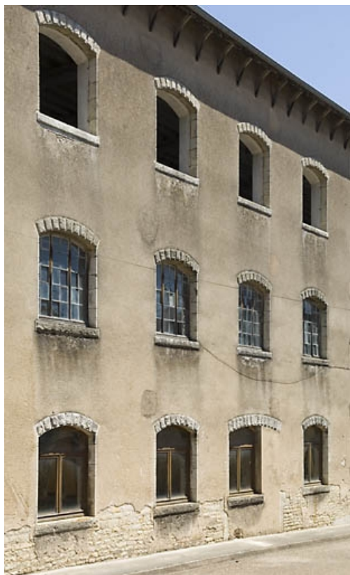
Travées de la façade sud de l'atelier de fabrication.
