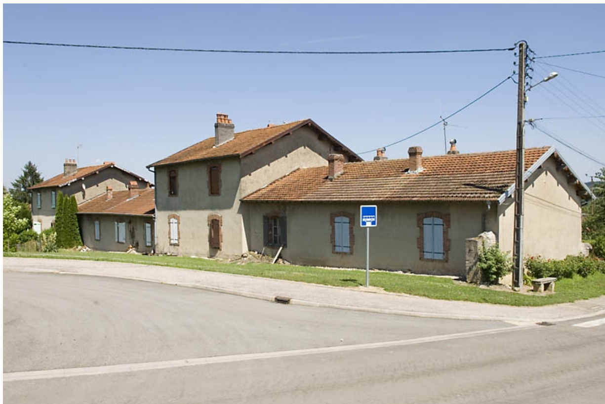
Logements ouvriers contigus. Vue depuis le sud.
