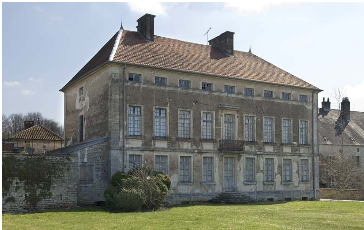
Logement patronal (31 rue Carnot). Façade postérieure vue de trois quarts.
