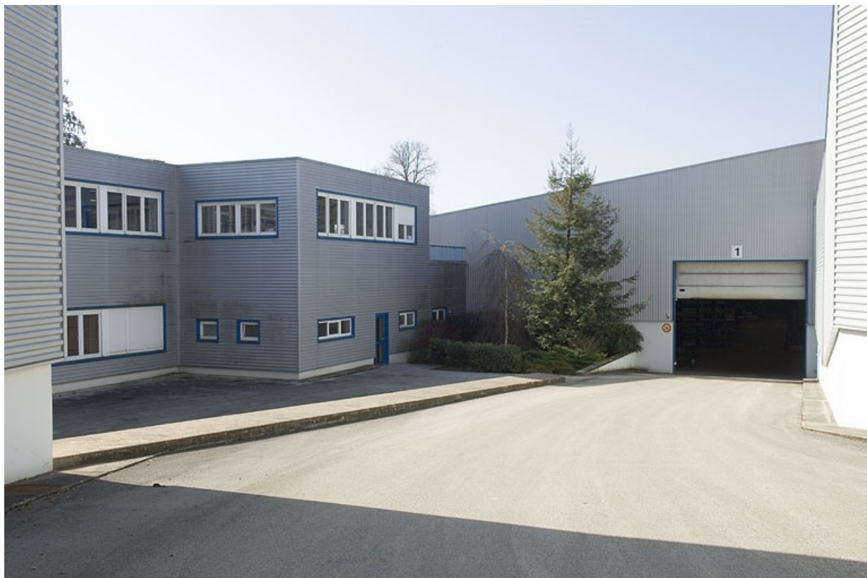
Bâtiments au sud de la route de Champlitte. Bureau d'études et entrée de l'atelier.
