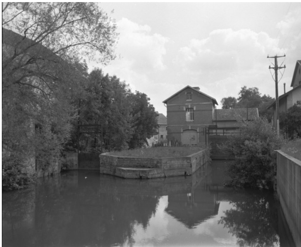
Le bâtiment de la turbine depuis le bief, en amont. Vue en 1989.
