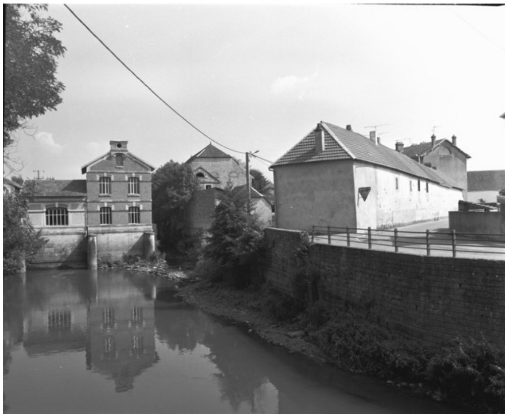
Vue d'ensemble depuis la rue en 1989.
