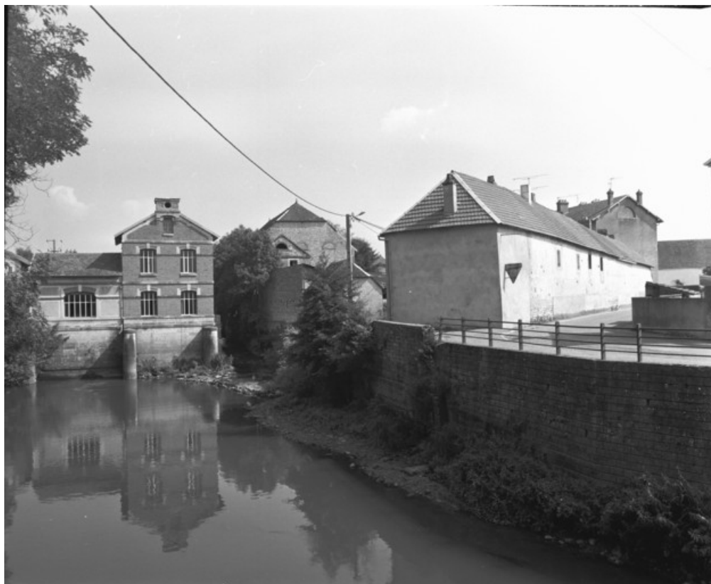
Vue d'ensemble depuis la rue en 1989. 70, Seveux, 1 Grande-Rue
