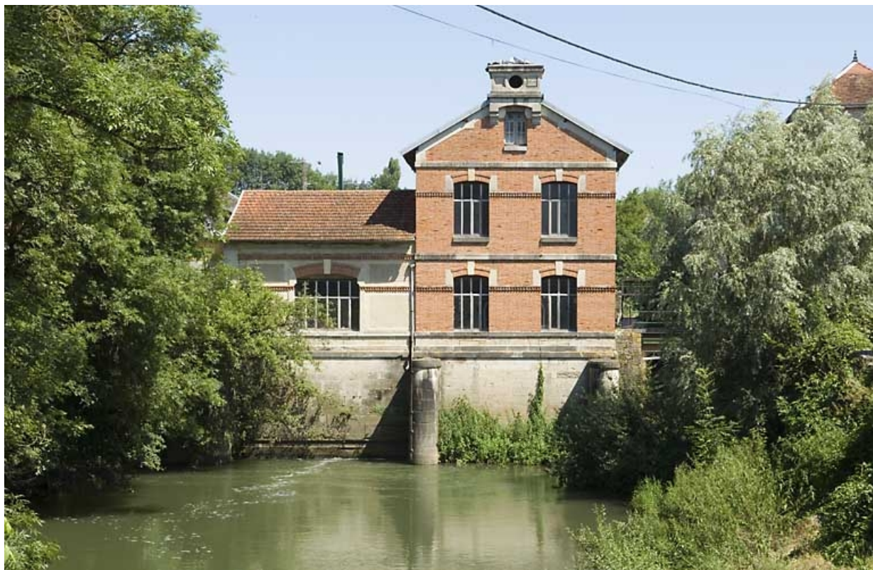
Vue rapprochée du bâtiment d'eau.
