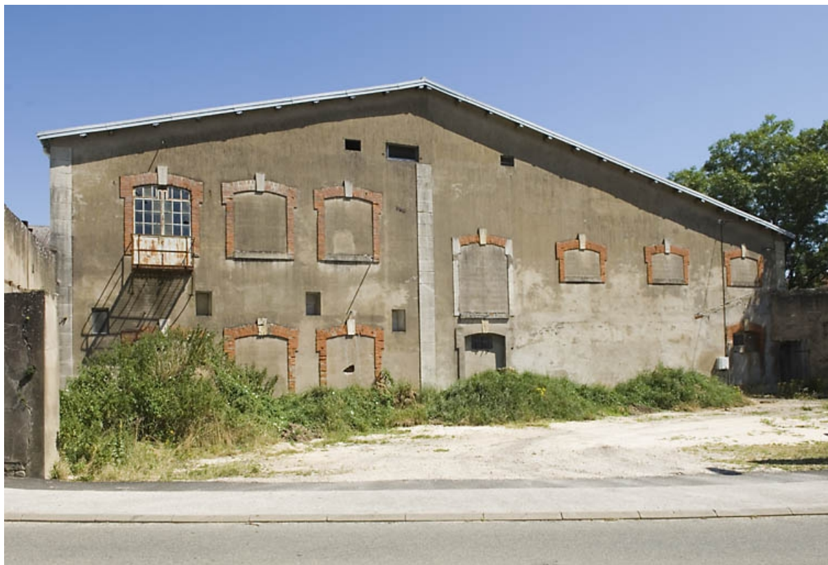
Façade sud d'ateliers de la papeterie.
