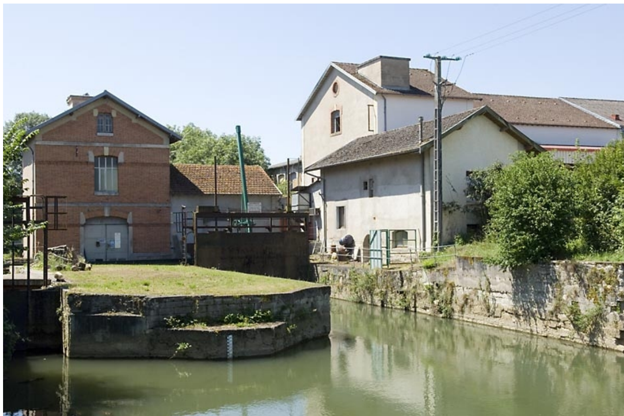
Bâtiment d'eau et atelier de fabrication depuis l'amont du canal.
