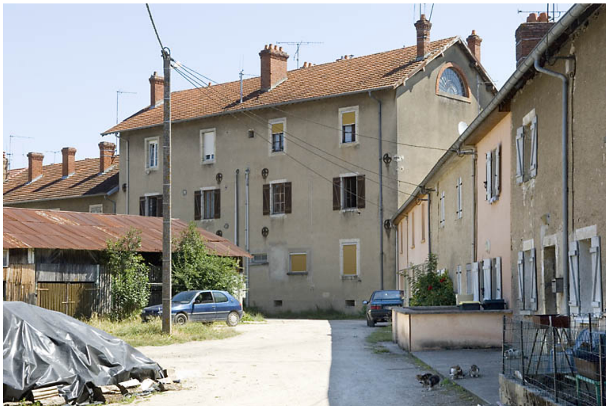
Façade ouest du logement ouvrier sur cour. 70, Seveux, 1 Grande-Rue
