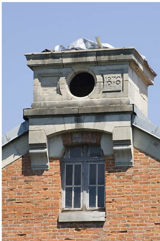
Couronnement de façade sud du bâtiment d'eau.
