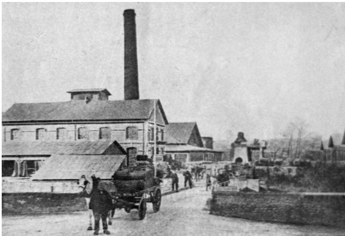
Usine de Seveux (Haute-Saône).
