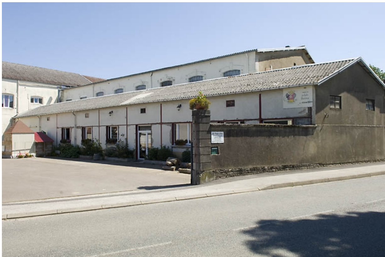
Atelier de fabrication depuis la Grande-Rue.
