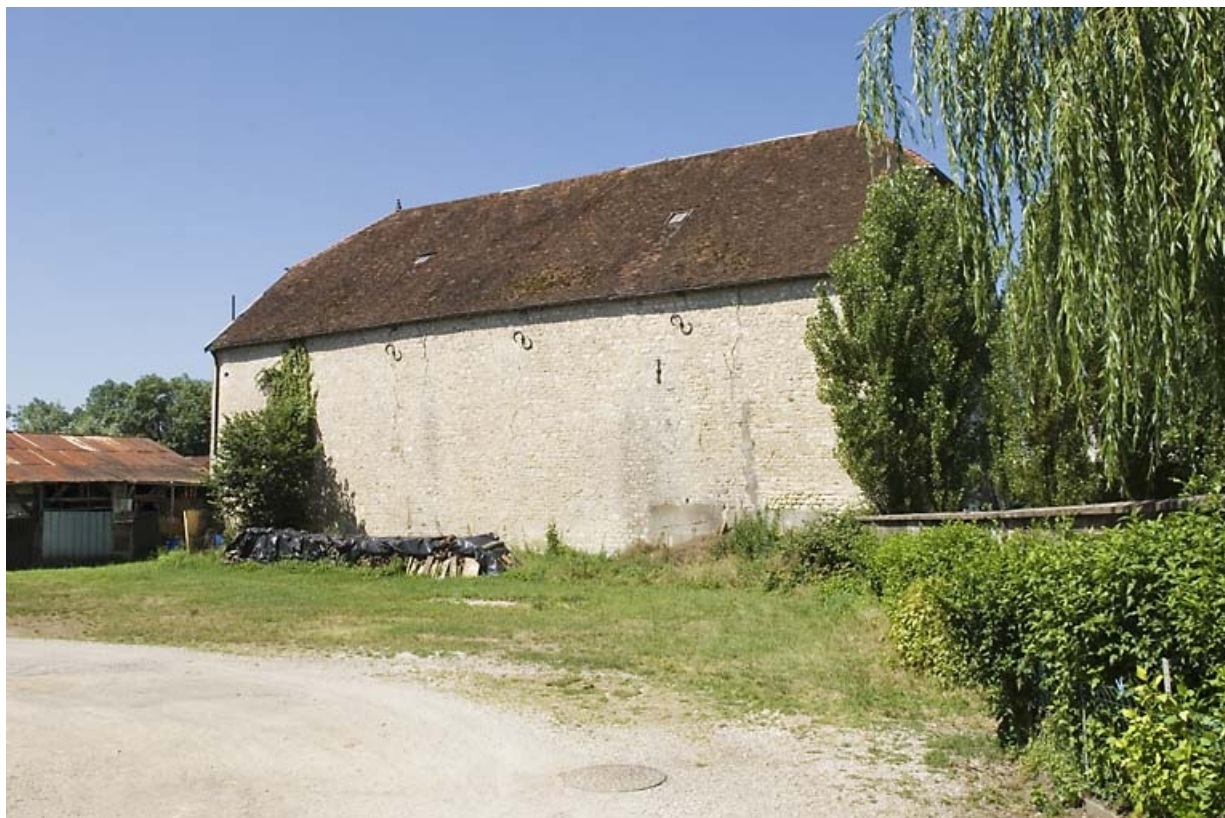
Façade est du haut fourneau.
