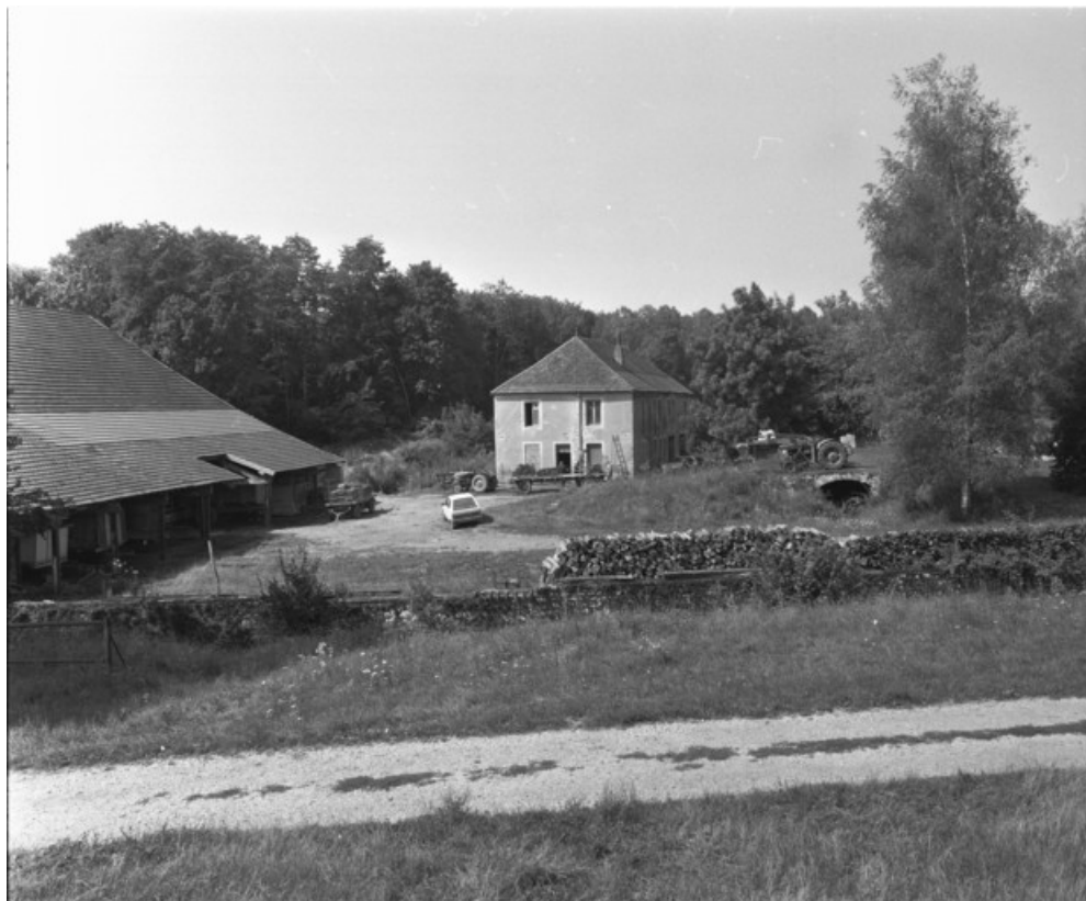
La halle à charbon et un logement ouvrier en 1989.
