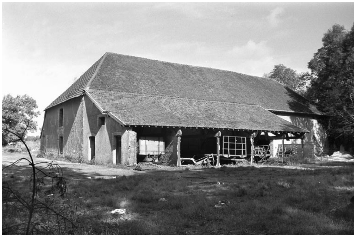
La halle à charbon vue de trois quarts arrière en 1987.
