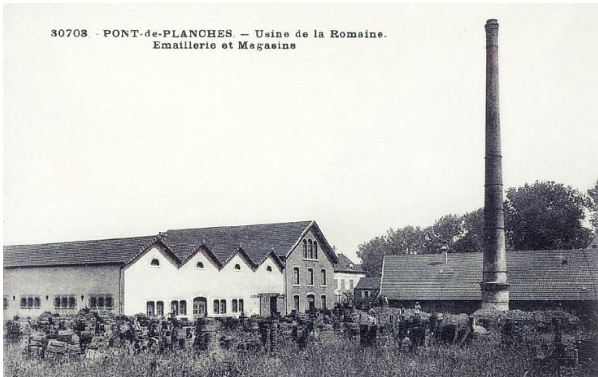
Pont-de-Planches. - Usine de la Romaine. Emaillerie et Magasins.
