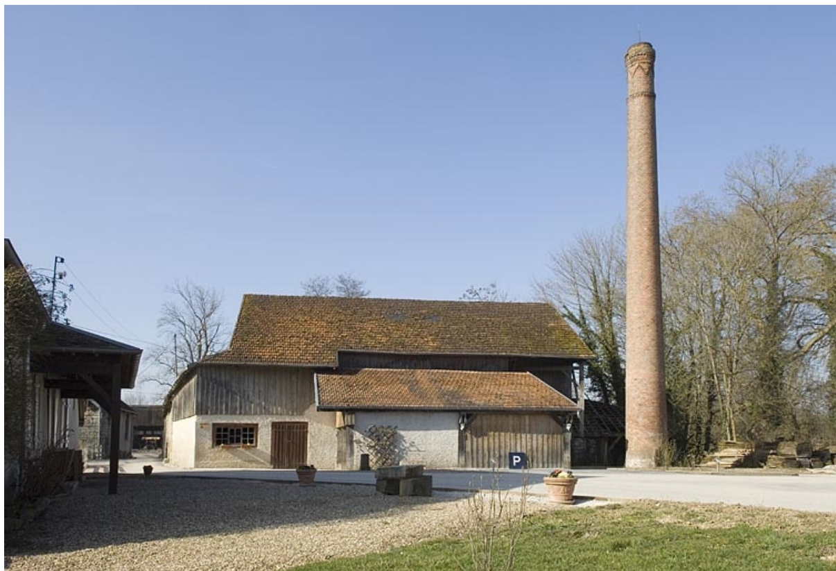
Magasin industriel et cheminée depuis le nord-est.
