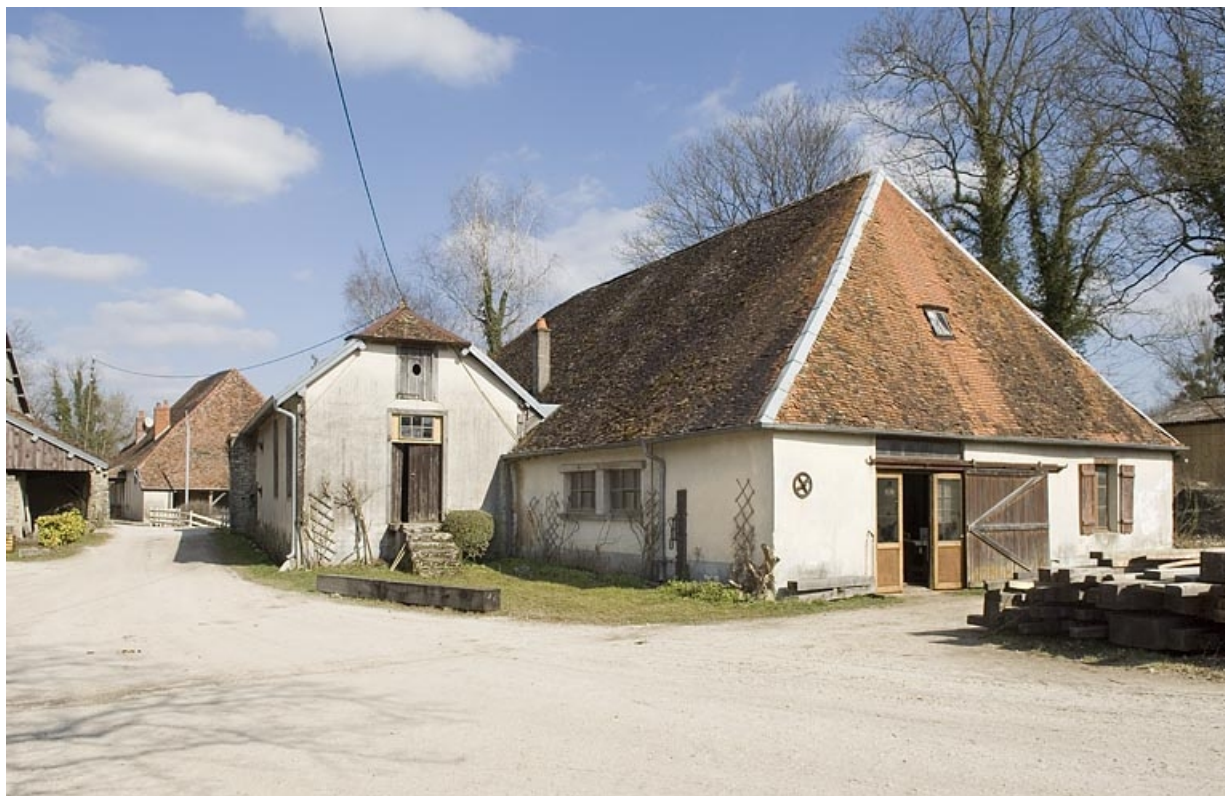
Vue d'ensemble des halles à charbon depuis le sud.
