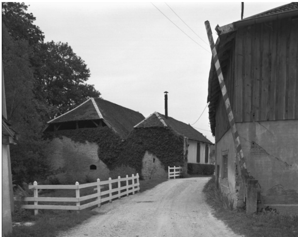
Halle à charbon sud depuis l'entrée en 1989.
