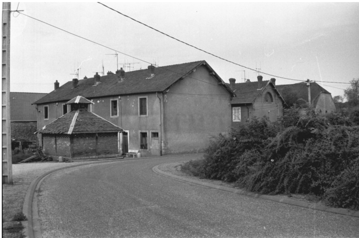
Logement ouvrier à gauche de la rue : façade postérieure de trois-quarts droit, et lieux d'aisance : vue éloignée. 70, Greucourt, lieudit : Estravaux
