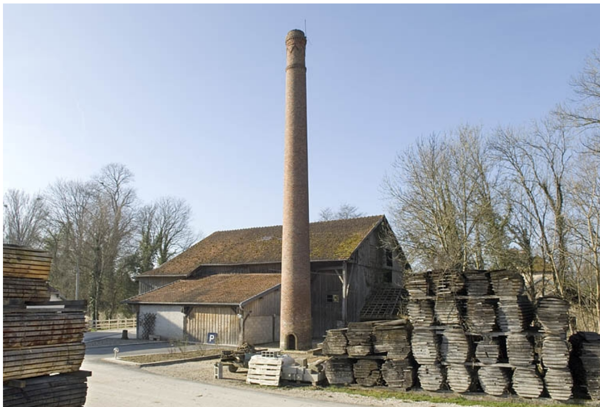
Vue d'ensemble de l'entrée depuis le nord-ouest.
