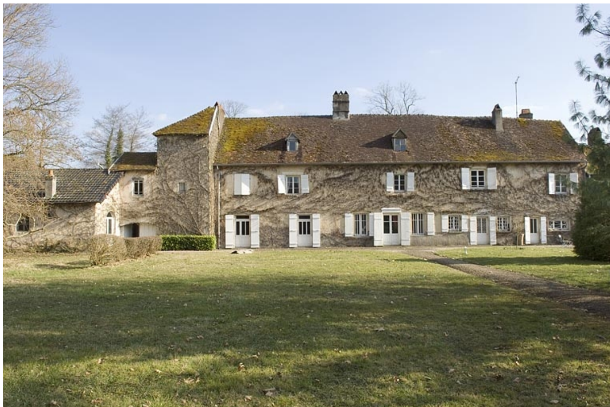
Façade postérieure du logis ouest.
