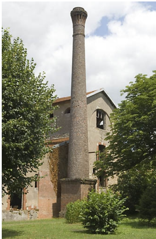
Cheminée et mur-pignon du haut fourneau depuis le sud-ouest.
