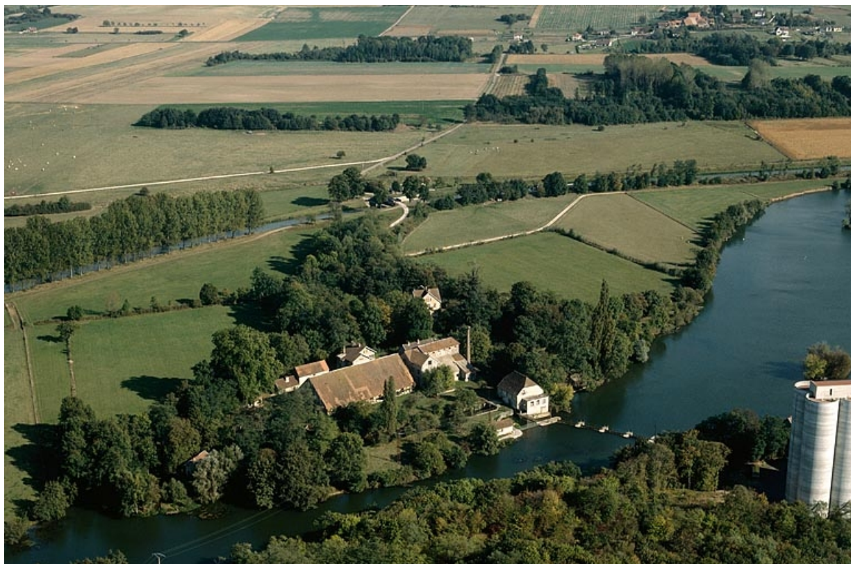
Vue aérienne depuis le nord-ouest en 1989.
