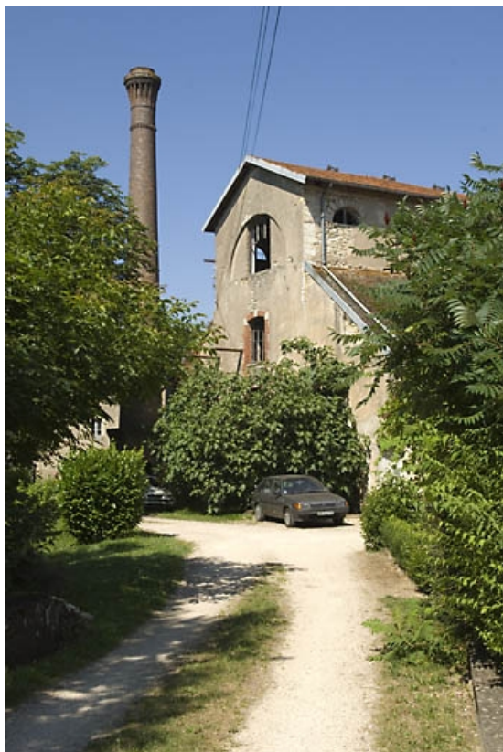
Vue du haut fourneau depuis l'entrée.
