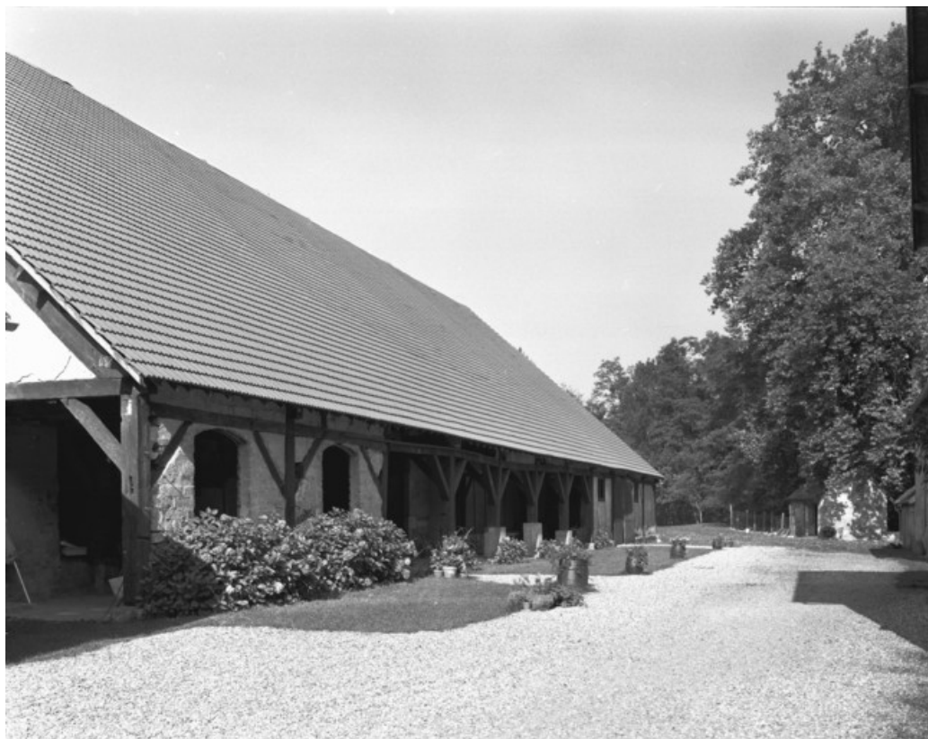
Halle à charbon vue de trois quarts en 1989.
