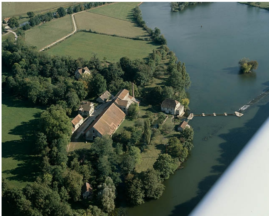
Vue aérienne plongeante depuis le nord en 1989.
