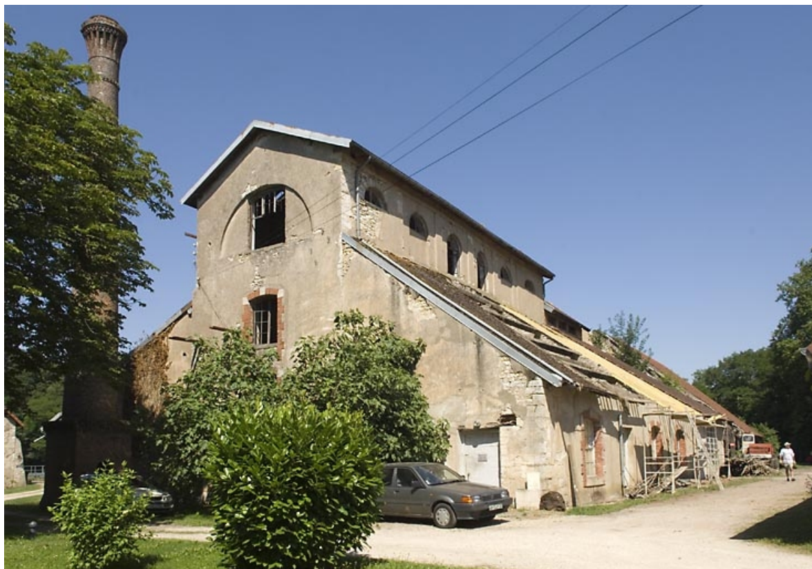
Le haut fourneau vu depuis le sud-est.
