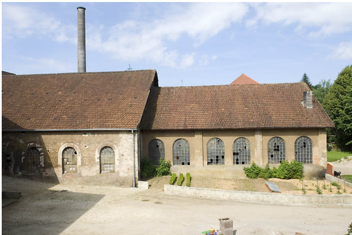
Façade est de l'atelier de fonderie.
