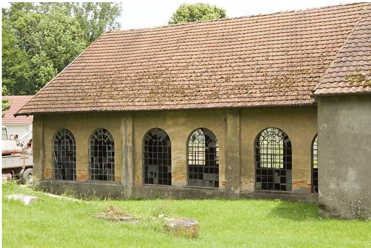
Façade ouest de l'atelier de fonderie.
