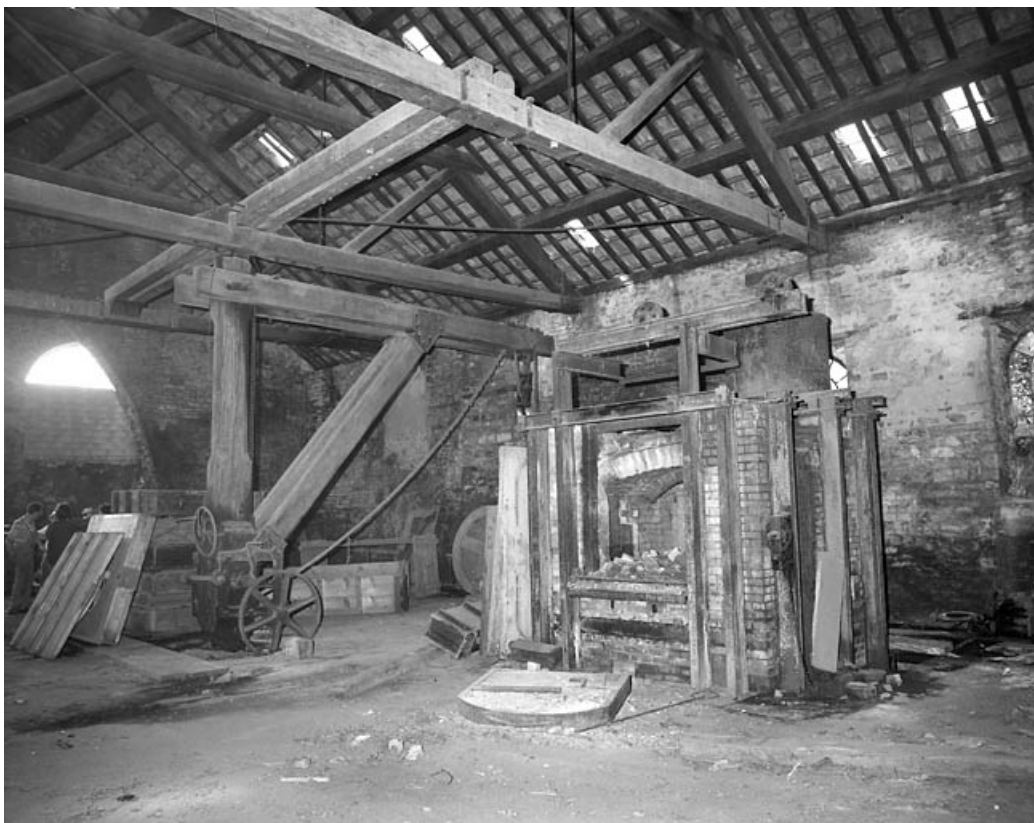
Vue d'ensemble de l'atelier de fabrication en 1981.
