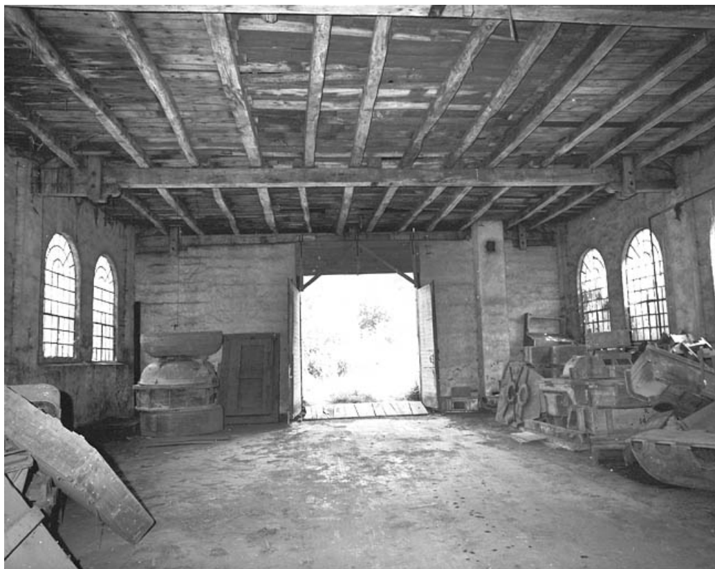
Partie sud de l'atelier de fabrication en 1981.
