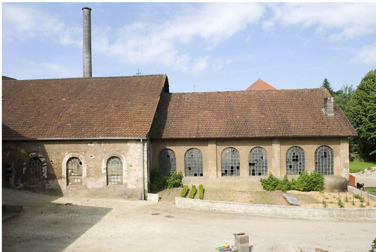
Façade est de l'atelier de fonderie.
