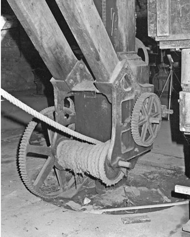
Grue à potence. Détail de la base.
