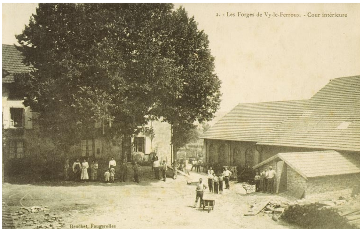
Les Forges de Vy-le-Ferroux. Cour intérieure. 70, Vy-le-Ferroux, 7 rue de Raze
