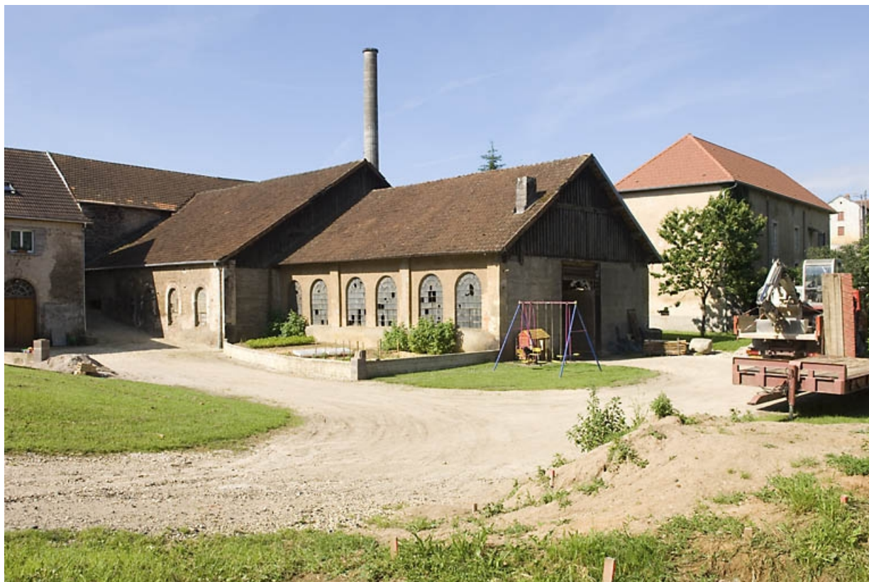
Atelier de fonderie et logement patronal depuis le nord-est.
