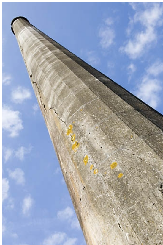
Cheminée vue en contre-plongée (2).
