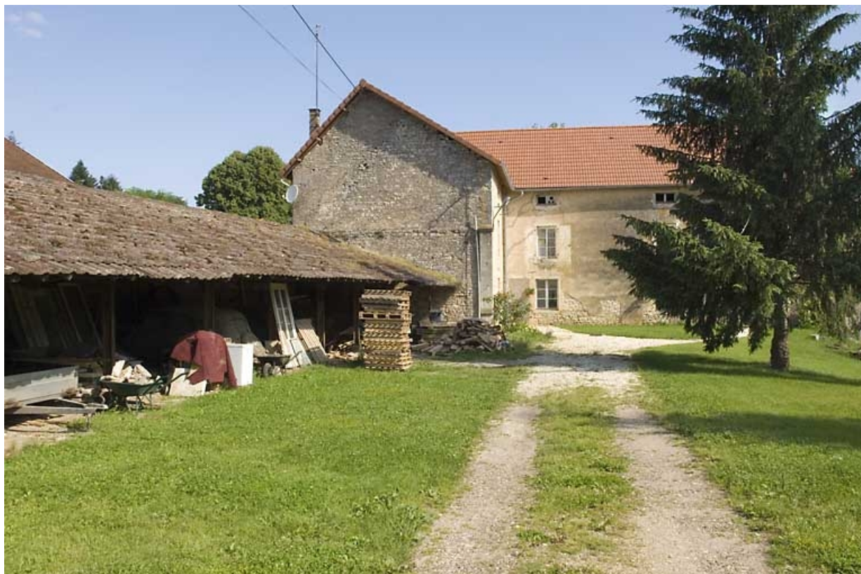
Appentis et logement patronal depuis l'entrée.
