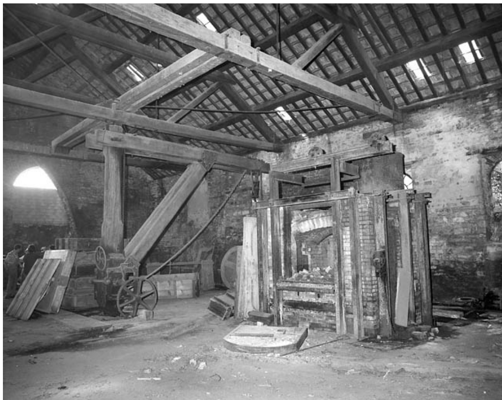
Vue d'ensemble de l'atelier de fabrication en 1981.
