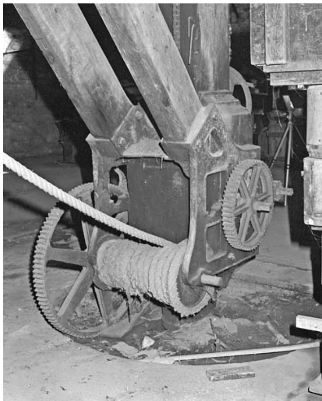
Grue à potence. Détail de la base.
