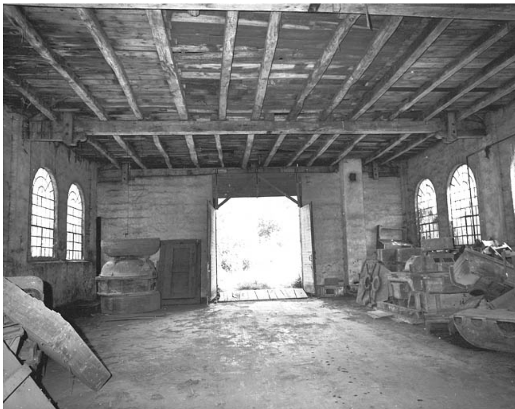
Partie sud de l'atelier de fabrication en 1981.
