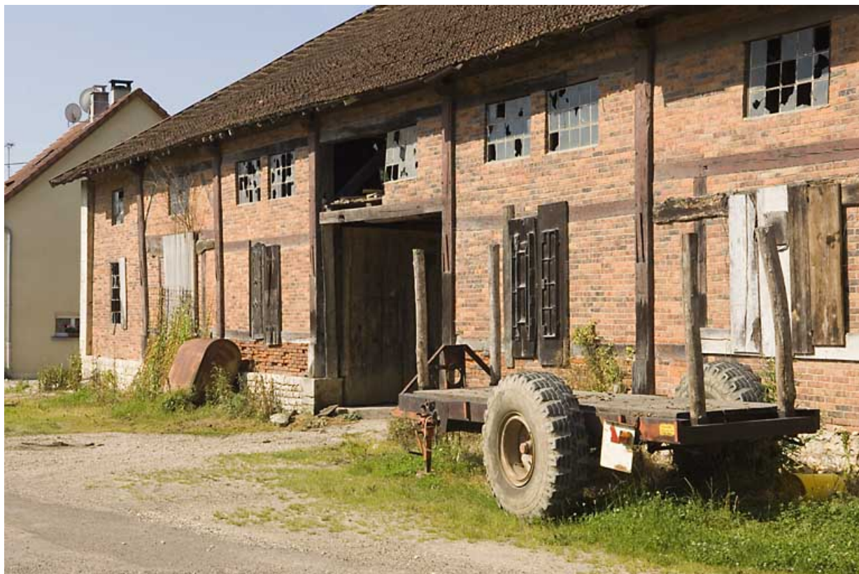
Détail de la façade est du magasin industriel.
