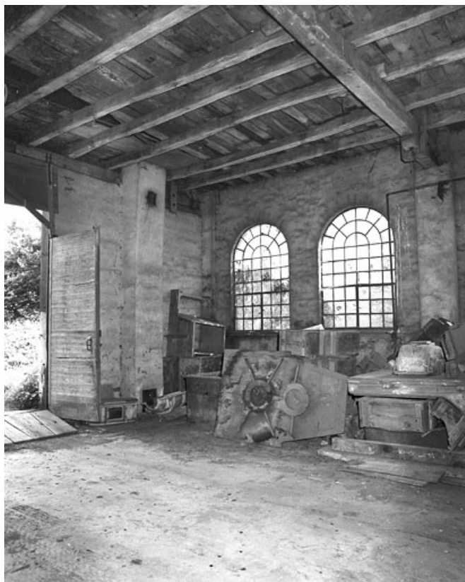
Angle nord de l'atelier de fabrication en 1981.
