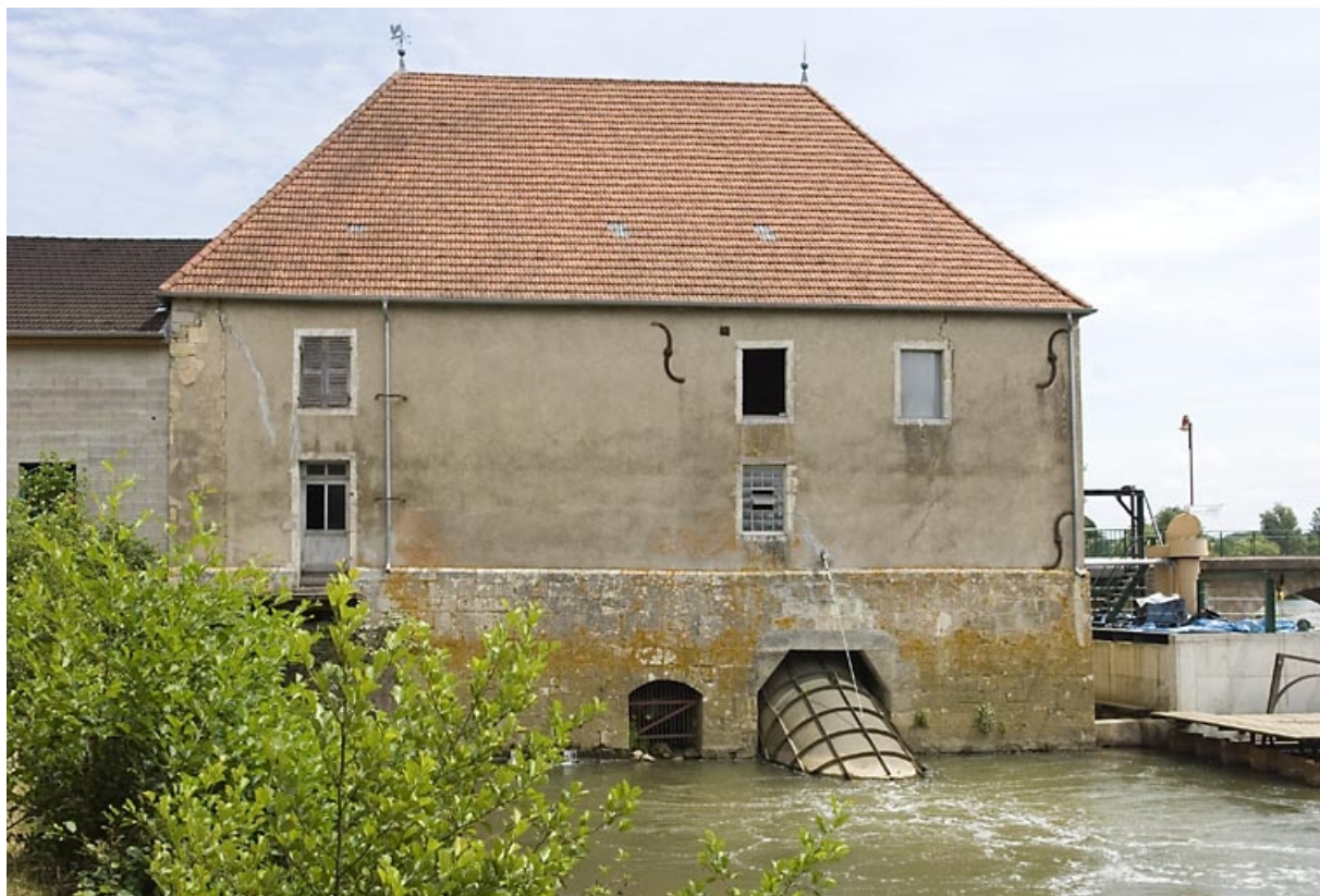
Façade postérieure du moulin.
