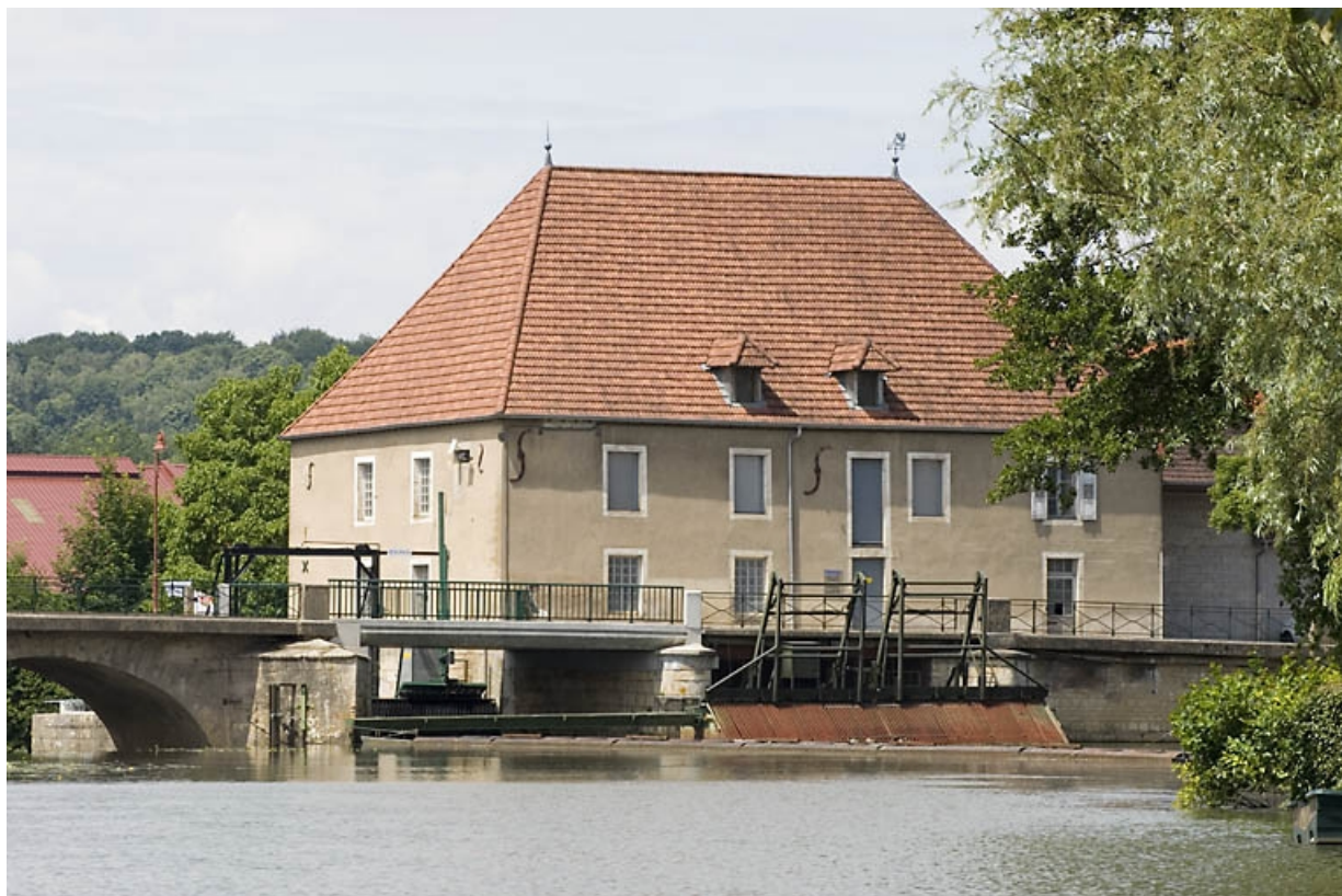
Vue d'ensemble en amont de la Saône.
