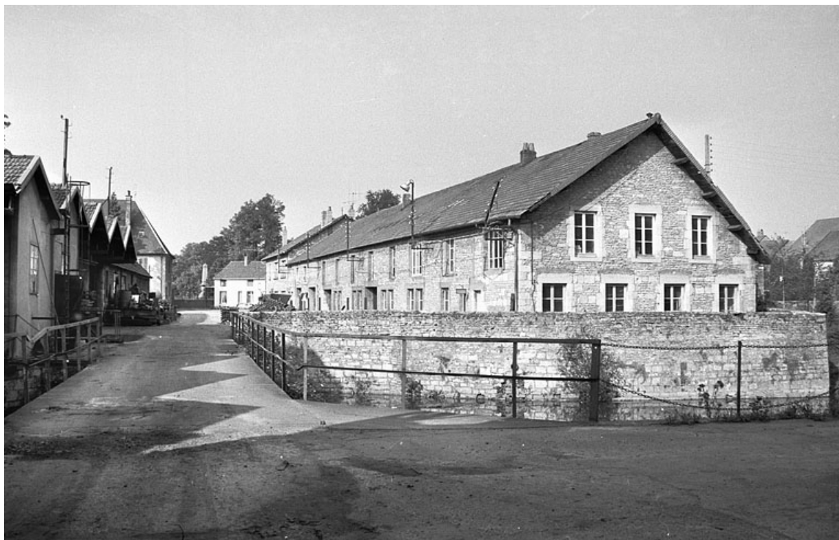
Halle à charbon reconvertie en logements ouvriers. Vue de trois quarts en 1987.
