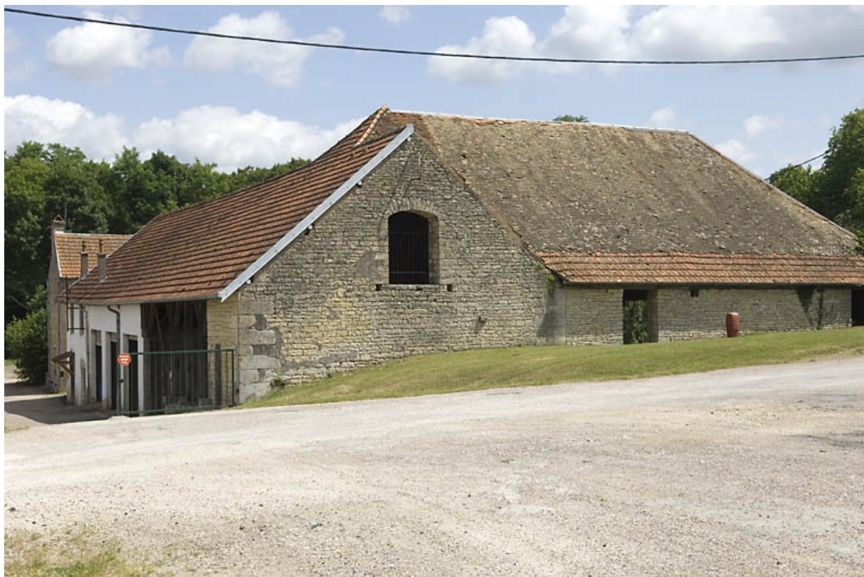
Halle à charbon depuis le sud-est.
