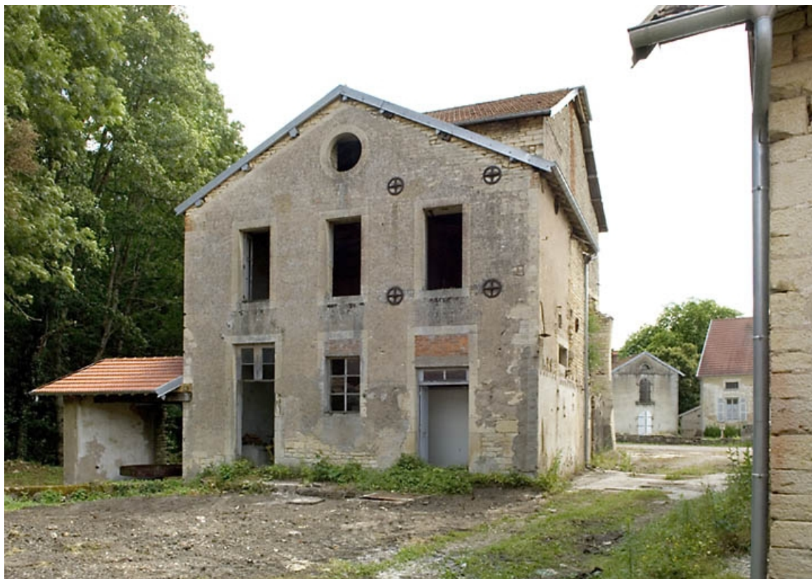
Façade ouest du haut fourneau.
