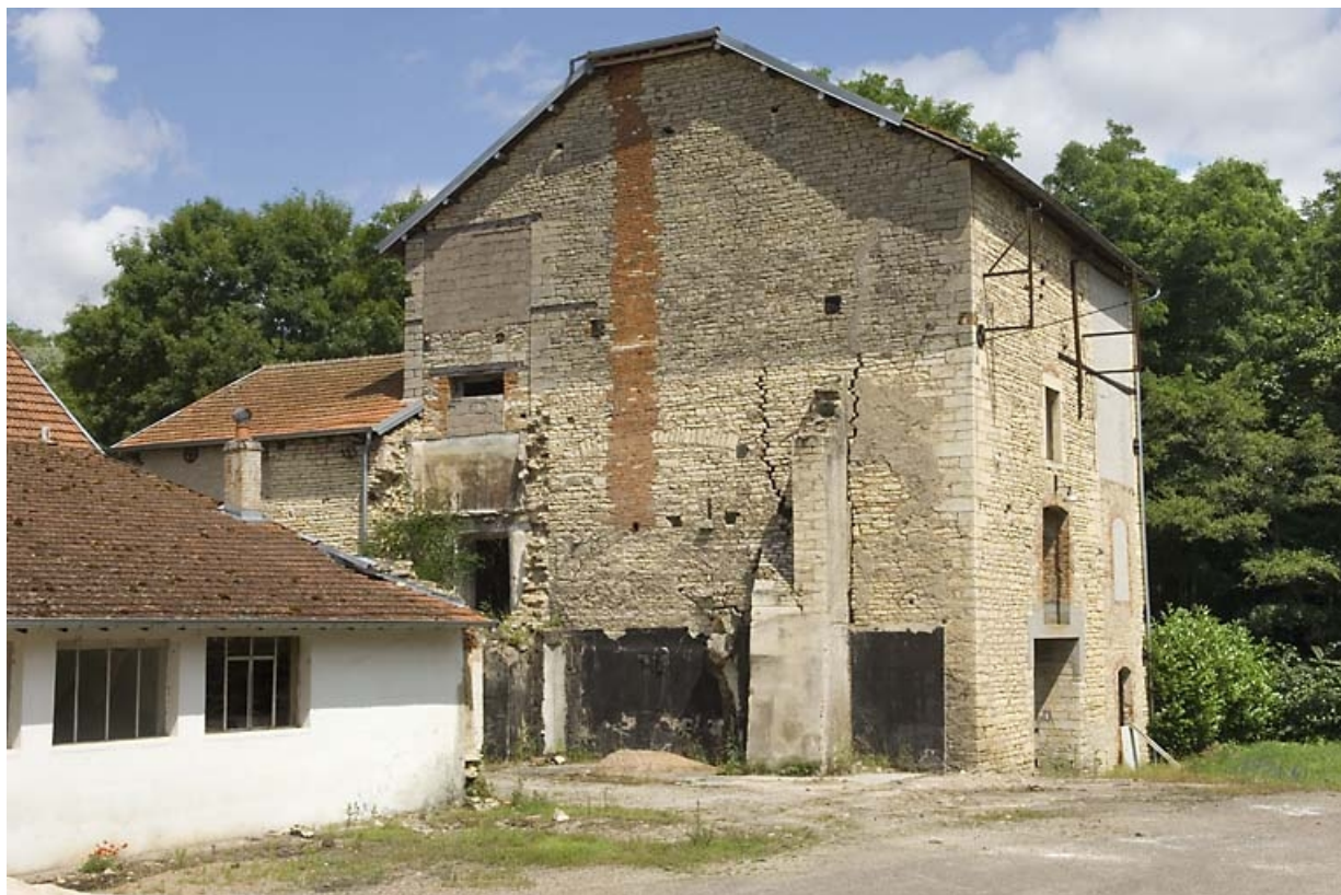
Le haut fourneau vu depuis le sud.
