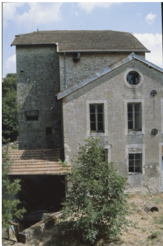
Façade postérieure du haut fourneau en 1989.
