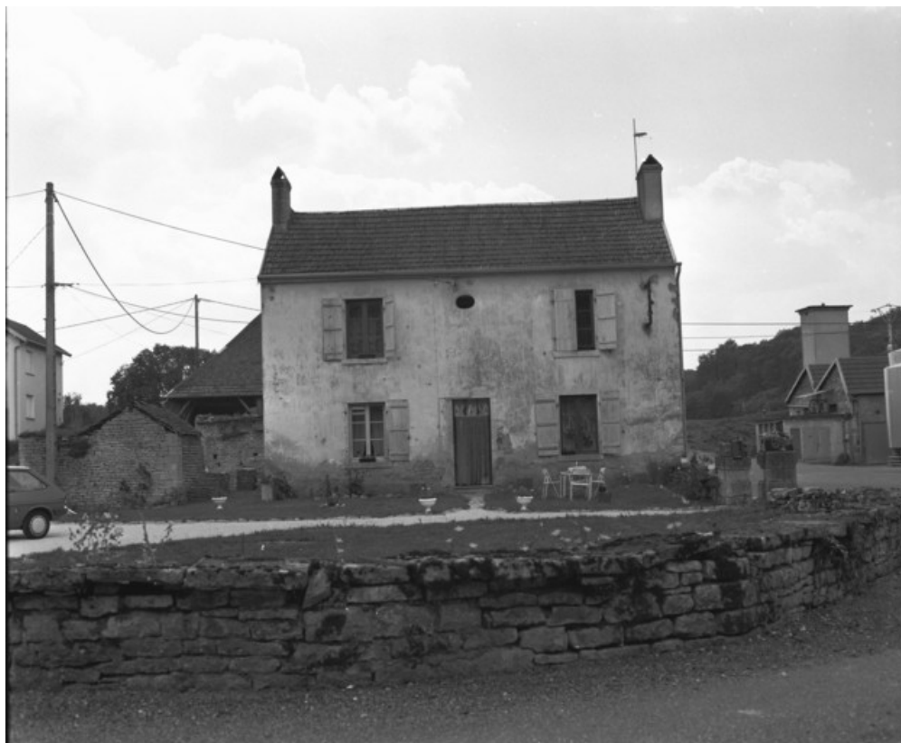
Logement. Vue de face en 1989.
