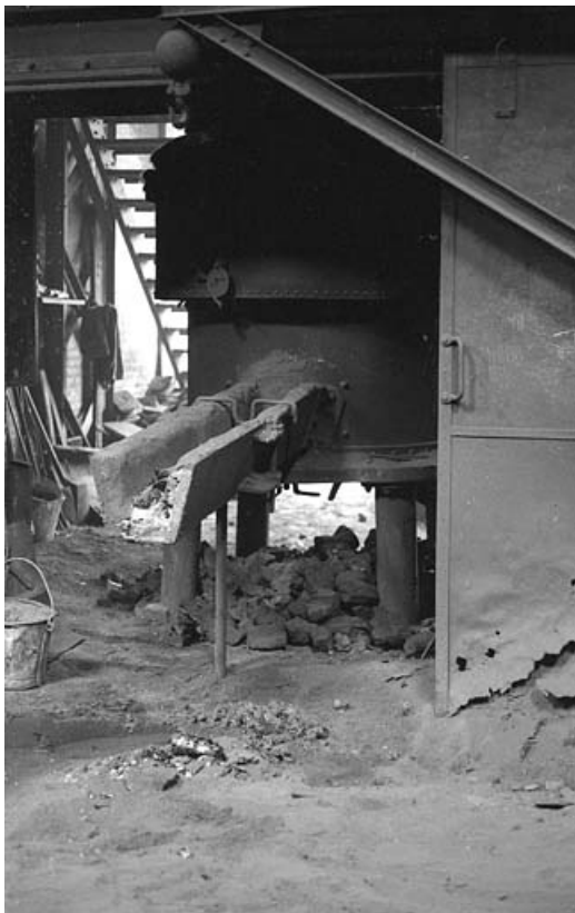
Base du grand cubilot et sa rigole de coulée. 70, Arc-lès-Gray, 5 rue de Verdun
