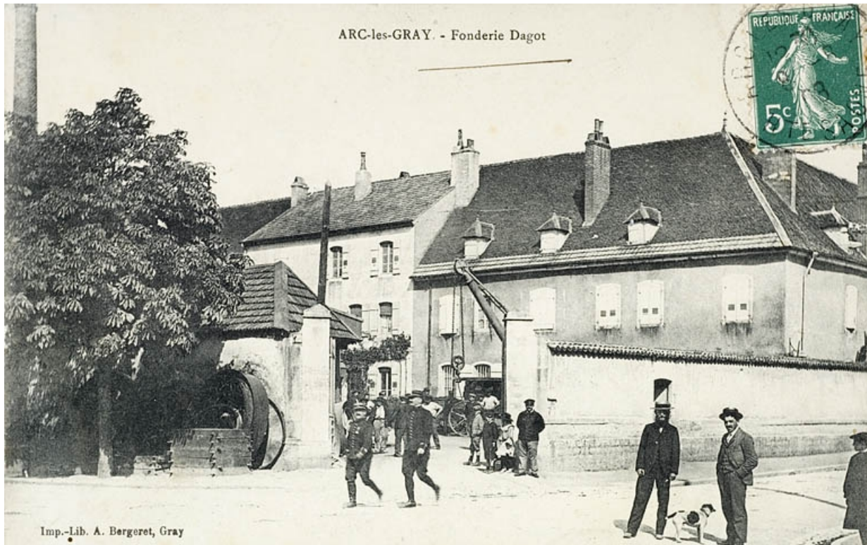
Arc-lès-Gray. - Fonderie Dagot. 70, Arc-lès-Gray, 5 rue de Verdun
