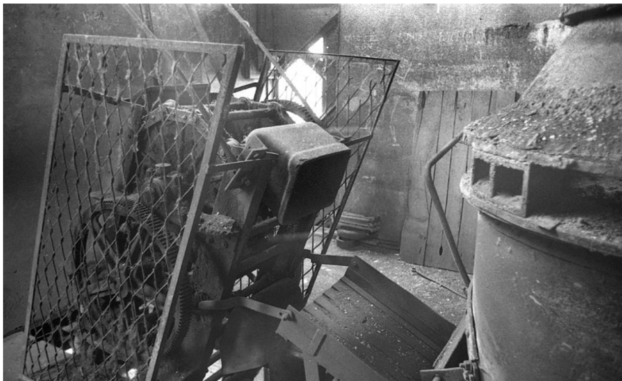
Partie supérieure du chargeur à godets et du grand cubilot (5 tonnes). 70, Arc-lès-Gray, 5 rue de Verdun
