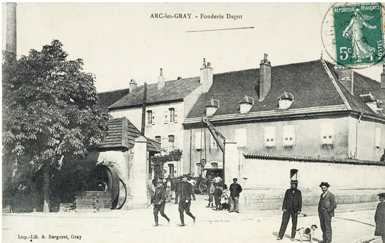
Arc-lès-Gray. - Fonderie Dagot. 70, Arc-lès-Gray, 5 rue de Verdun
