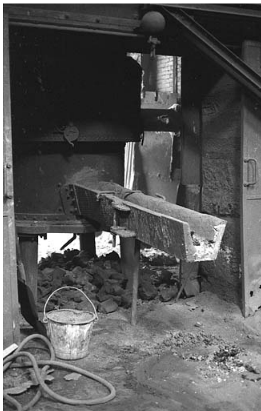
Grand cubilot. Rigole de coulée.
