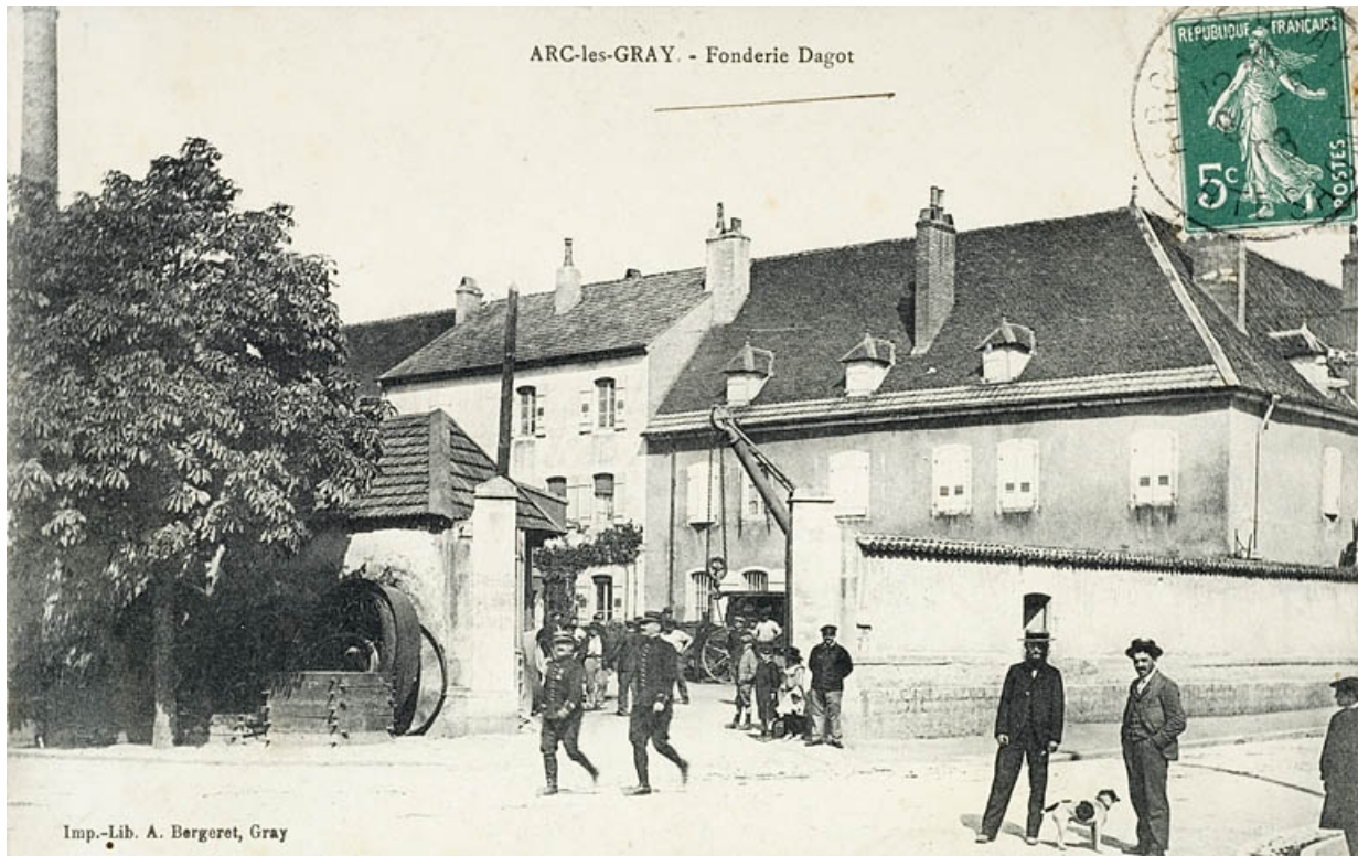
Arc-lès-Gray. - Fonderie Dagot. 70, Arc-lès-Gray, 5 rue de Verdun
