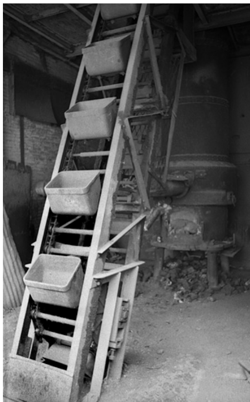
Chargeur à godets du grand cubilot (5 tonnes). 70, Arc-lès-Gray, 5 rue de Verdun
