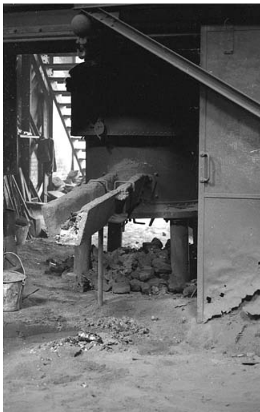
Base du grand cubilot et sa rigole de coulée.
