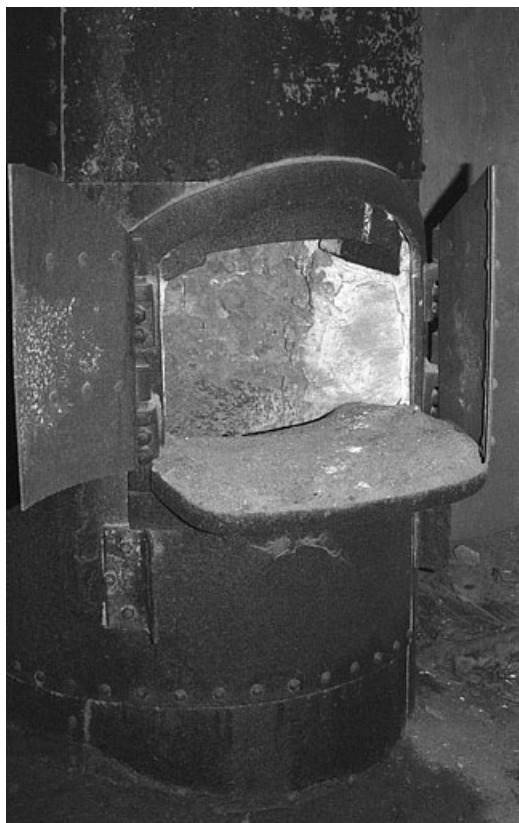
Gueulard du petit cubilot (chargement manuel). 70, Arc-lès-Gray, 5 rue de Verdun
