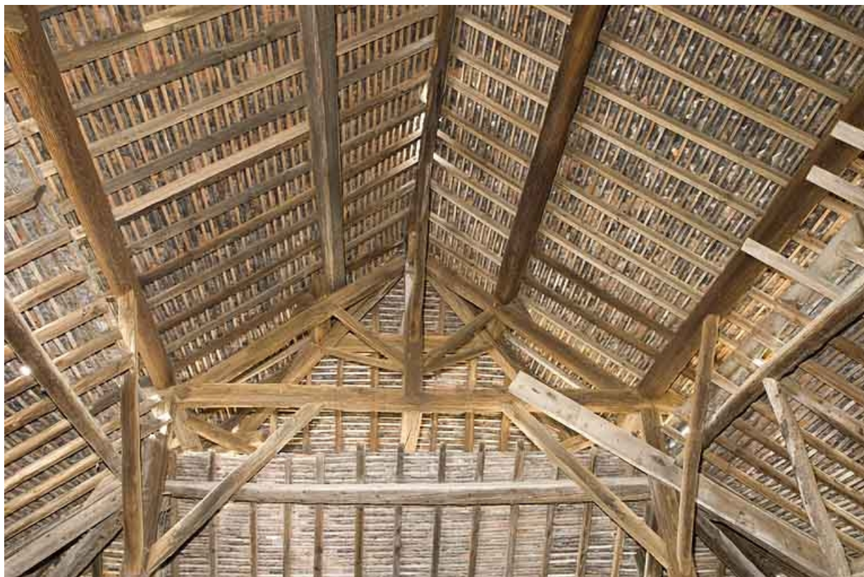
Bâtiment du four. Charpente de la croupe est. Vue de face.
