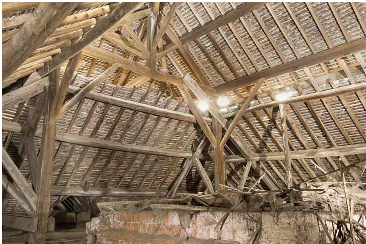
Bâtiment du four. Charpente de la croupe est. Vue de trois quarts.
