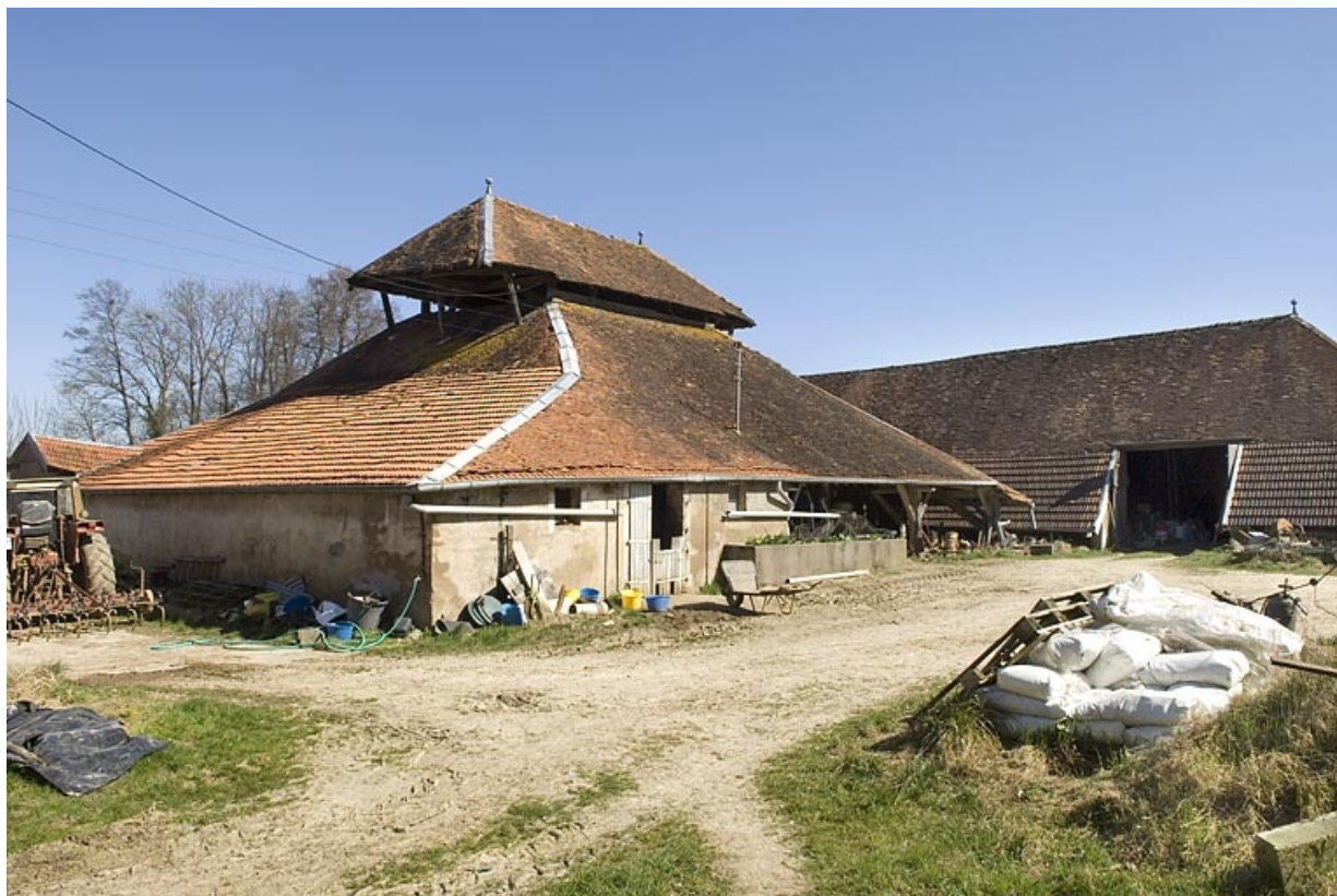
Bâtiment du four et séchoir vus de trois quarts.
