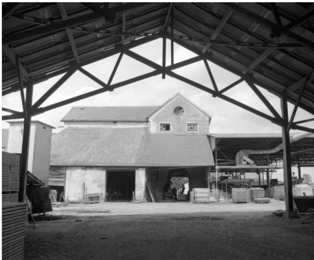
Façade postérieure du bâtiment du haut fourneau en 1990.
