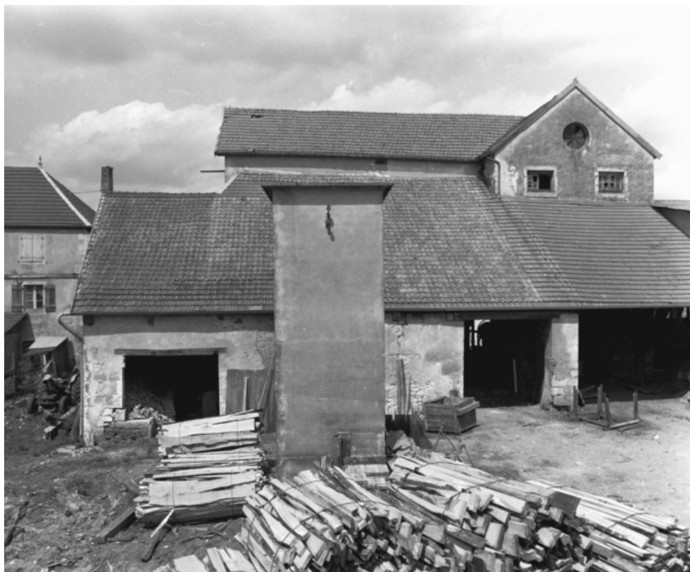
Appentis dressés contre la façade est du haut fourneau en 1989.
