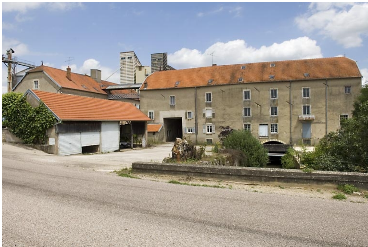
Vue d'ensemble depuis la route, à l'ouest. 70, Esmoulins R.D. 39, lieudit : le Moulin
