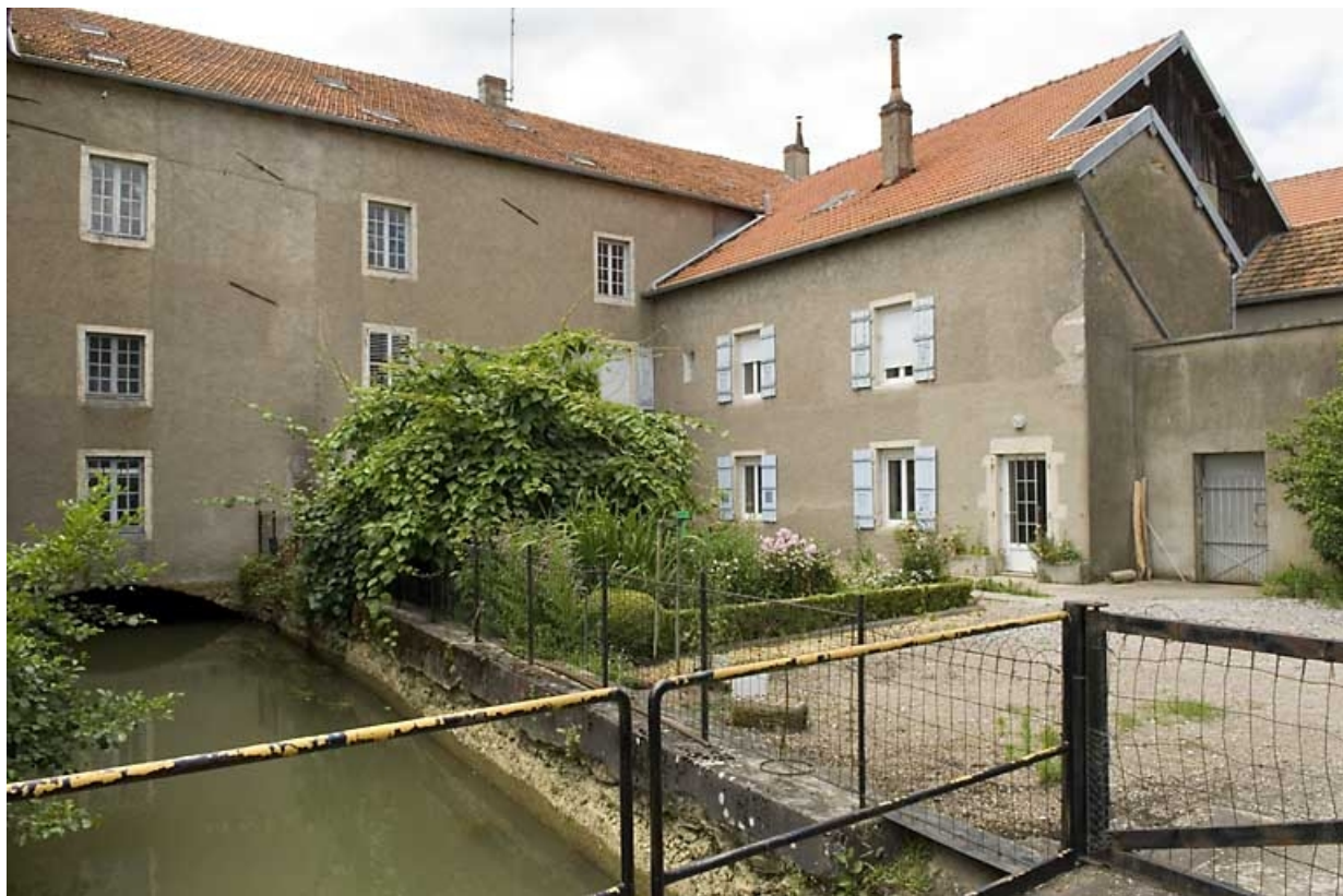
Façade postérieure et canal d'amenée.
