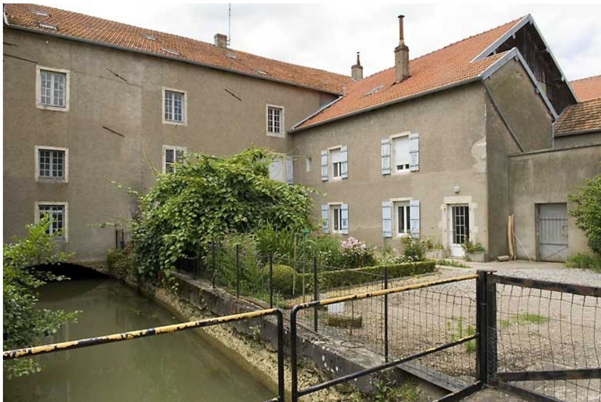
Façade postérieure et canal d'aménée.
