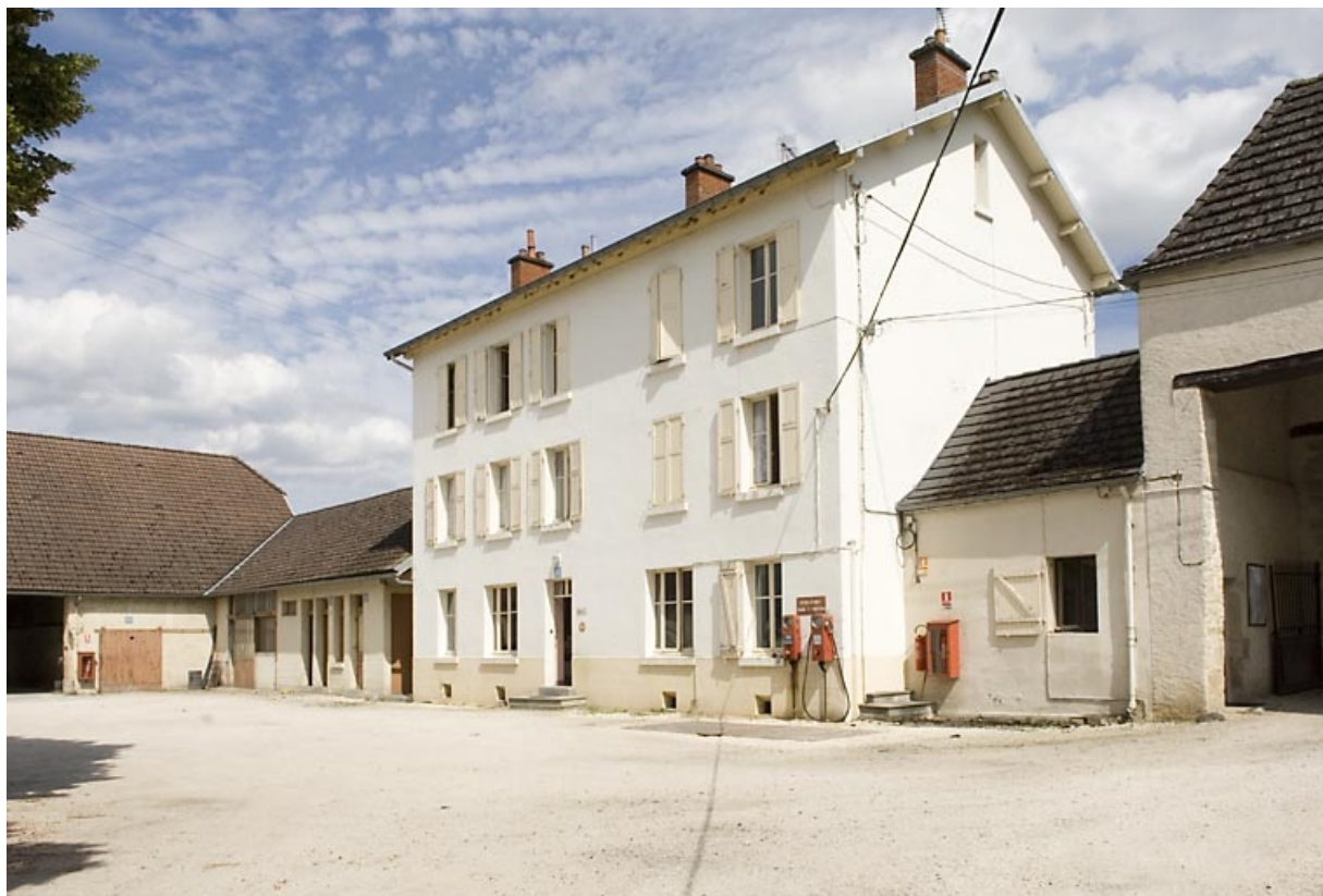
Bureau et logement. Vue de trois quarts droite.
