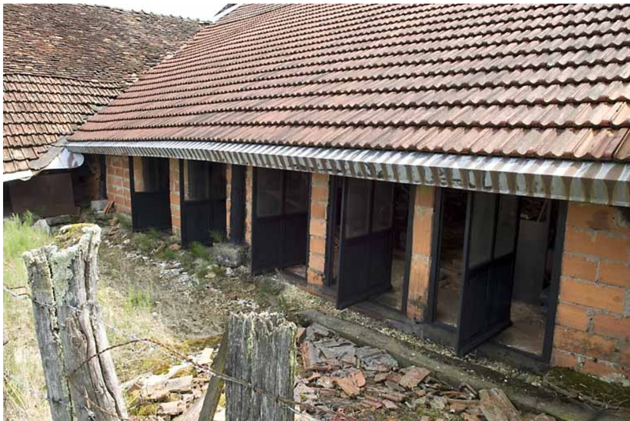
Façade ouest de l'atelier de fabrication. Panneaux orientables.
