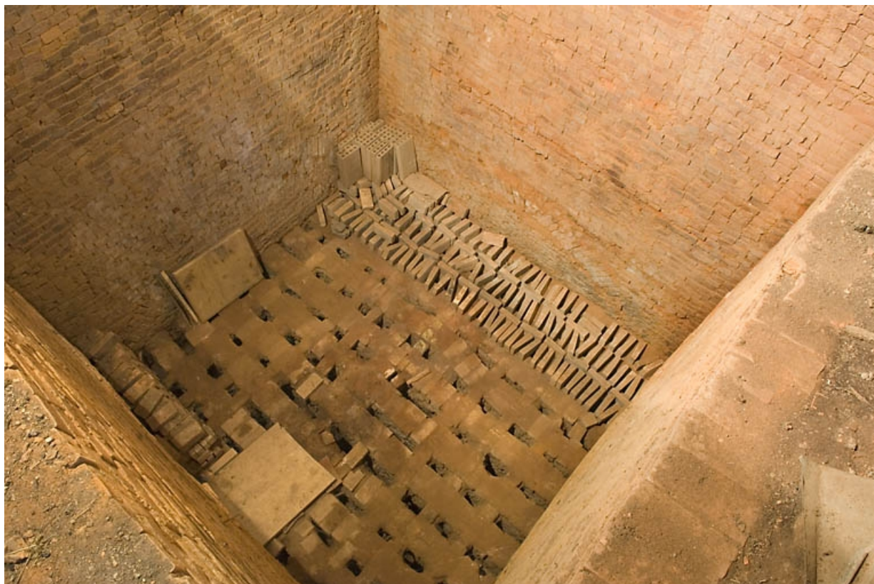
La sole vue depuis la partie supérieure du four.
