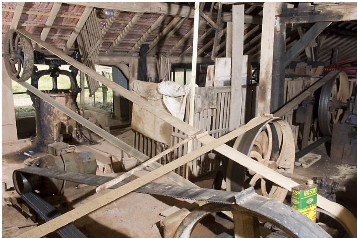
Système de transmission par courroies aux machines de production.
