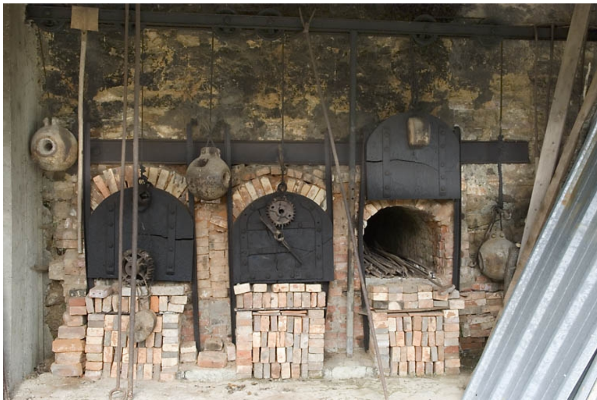
Façade est du four. Gueules de charge.
