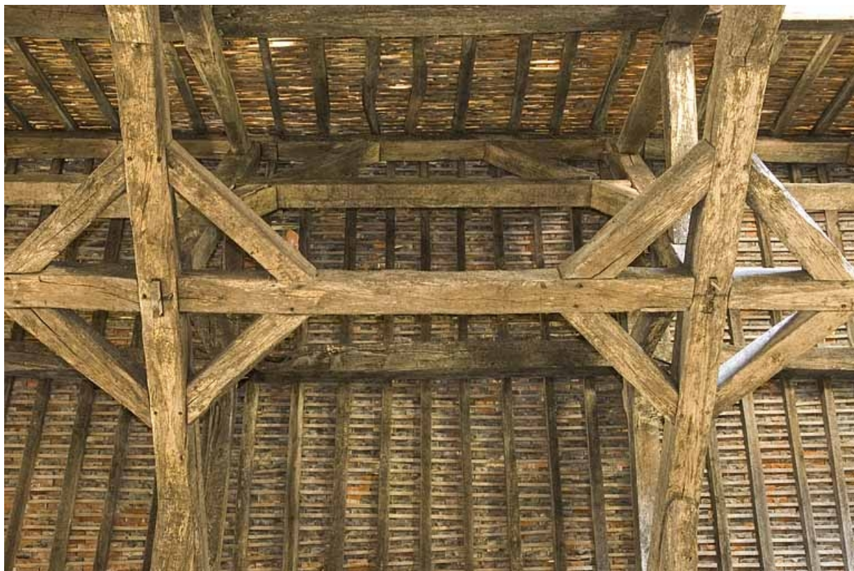
Charpente de la halle à charbon. Travée centrale.
