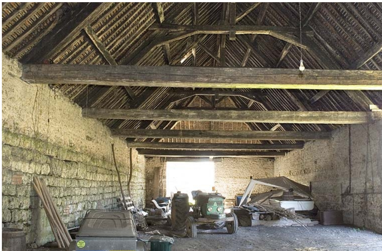
Vue intérieure de la halle à charbon. Partie sud. 70, Essertenne-et-Cecey, lieudit : Echalonge
