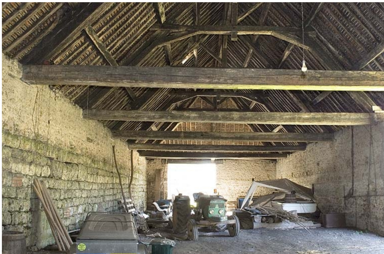
Vue intérieure de la halle à charbon. Partie sud.
