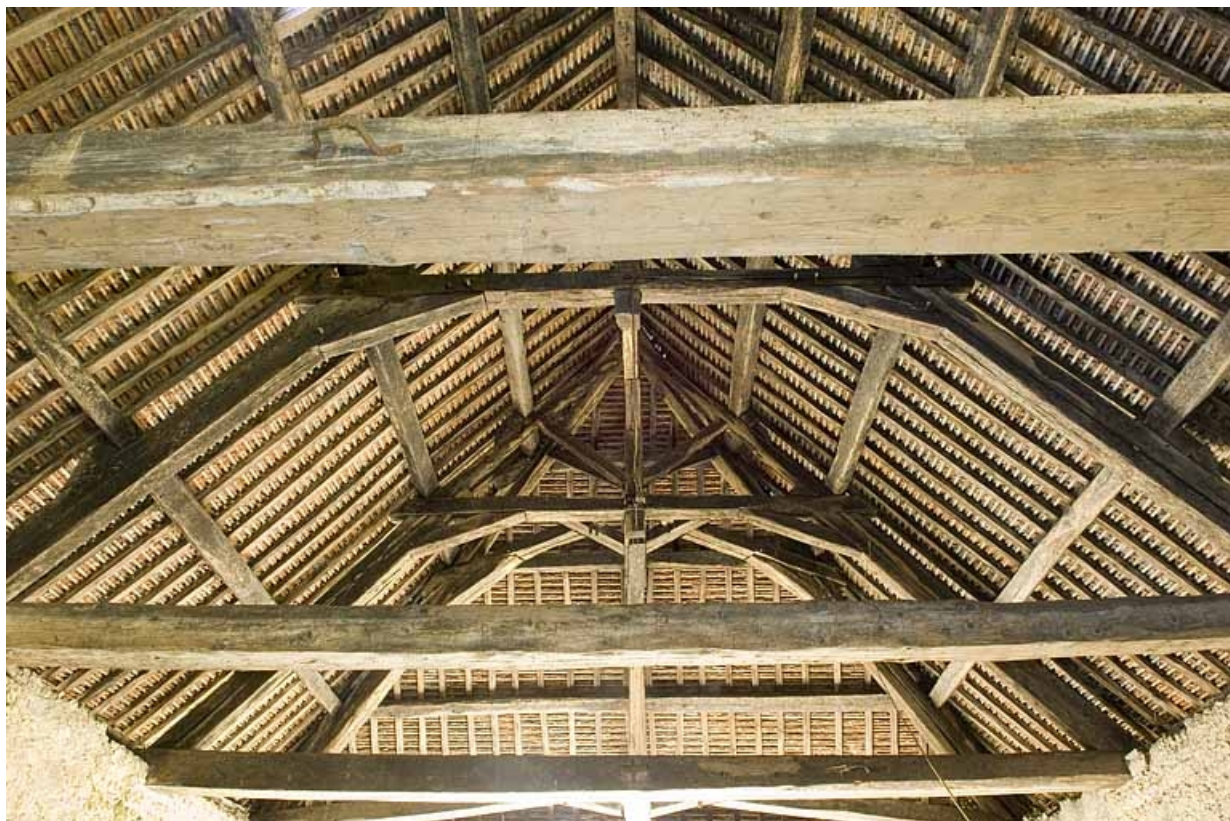
Charpente de la halle à charbon. Extrémité sud.
