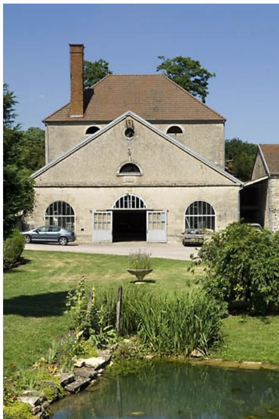
Le haut fourneau vu de face.
