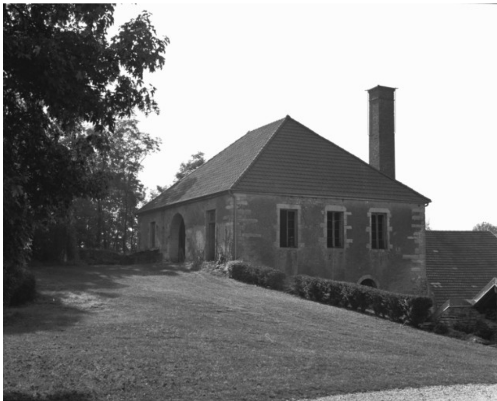
Façades ouest et nord du haut fourneau en 1990.
