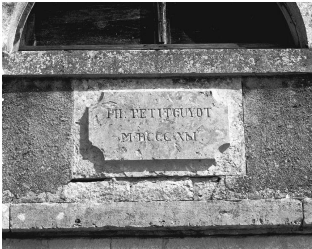
Pignon du haut fourneau. Détail du cartouche en 1989.
