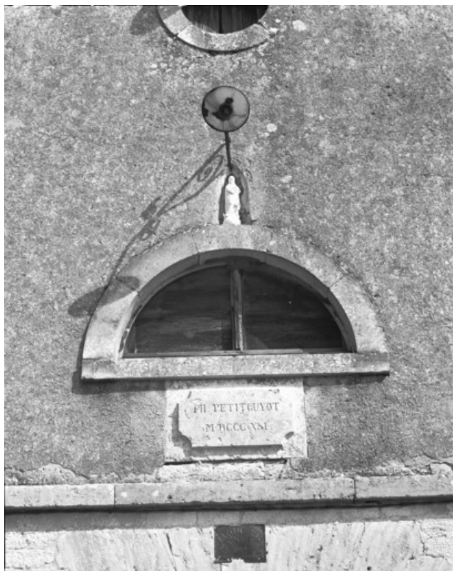
Détail du pignon du haut fourneau en 1989.
