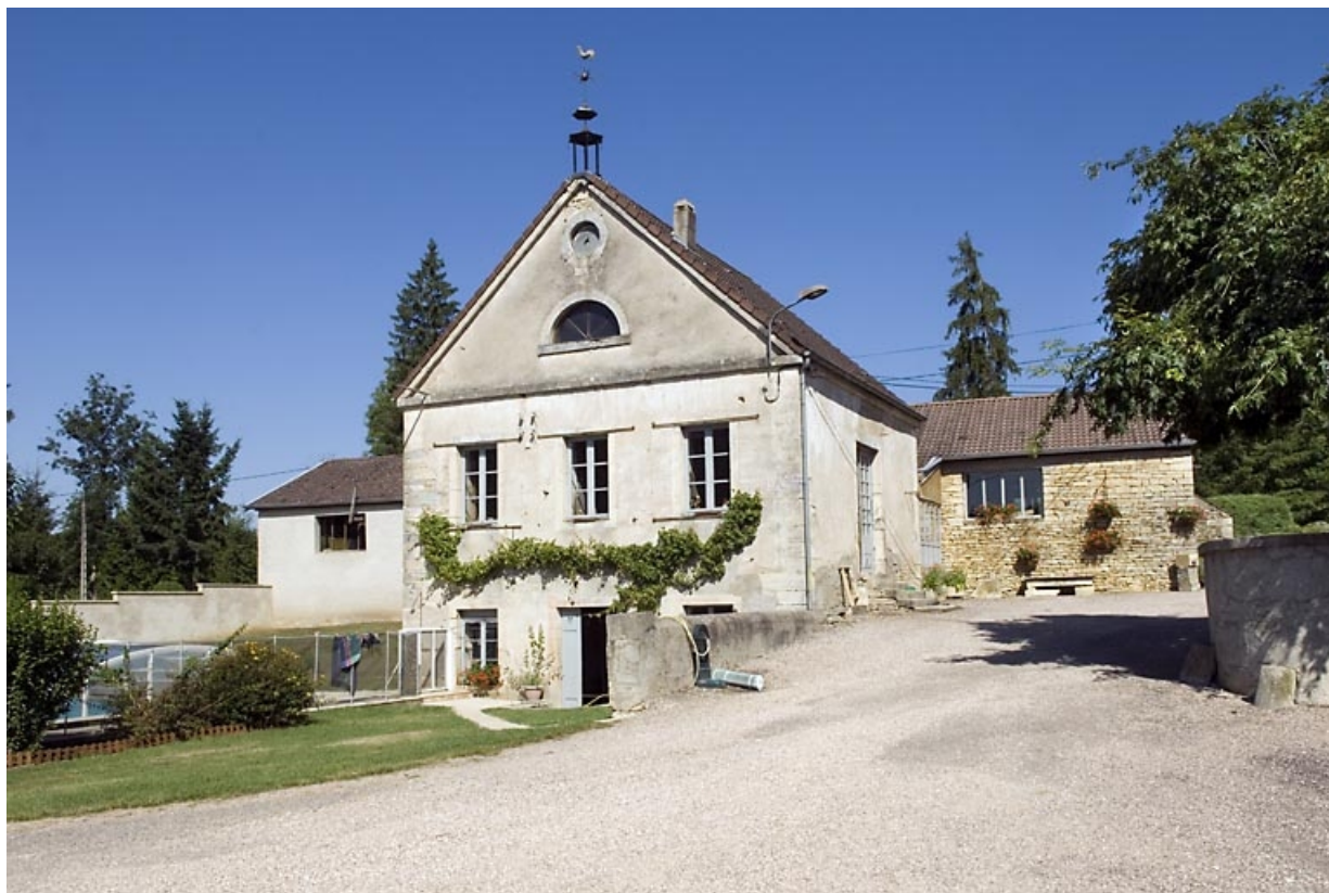
Vue d'ensemble du bâtiment d'eau et de l'atelier de fonderie.
