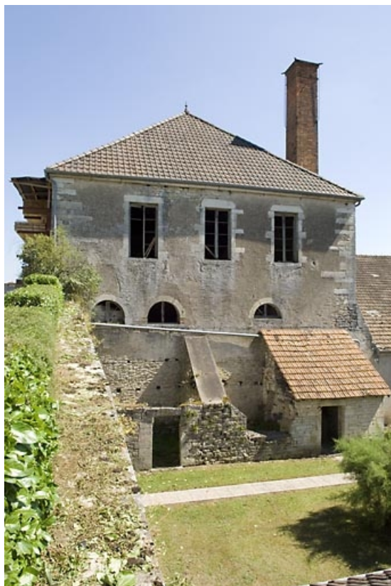
Façade nord-ouest du haut fourneau.
