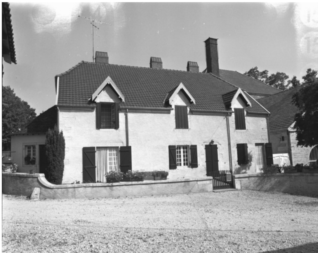
Logement patronal. Façade antérieure en 1989.
