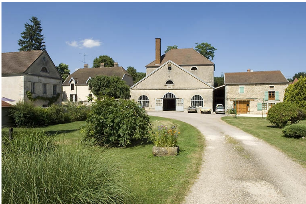
Vue d'ensemble depuis l'entrée, au sud.
