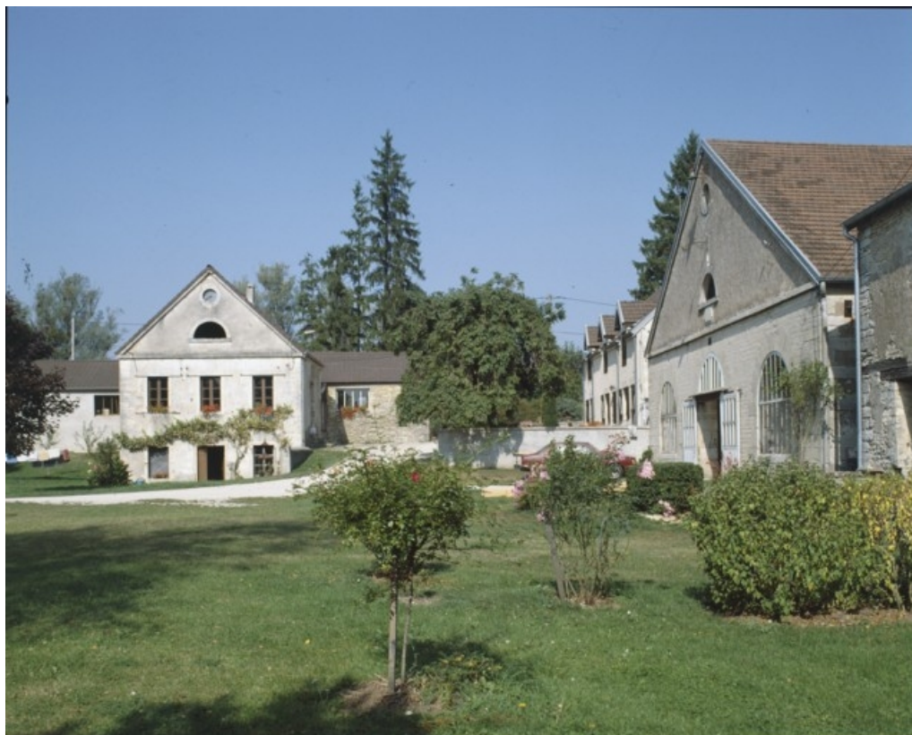
Bâtiment de la soufflerie et haut fourneau depuis le sud-est en 1989.
