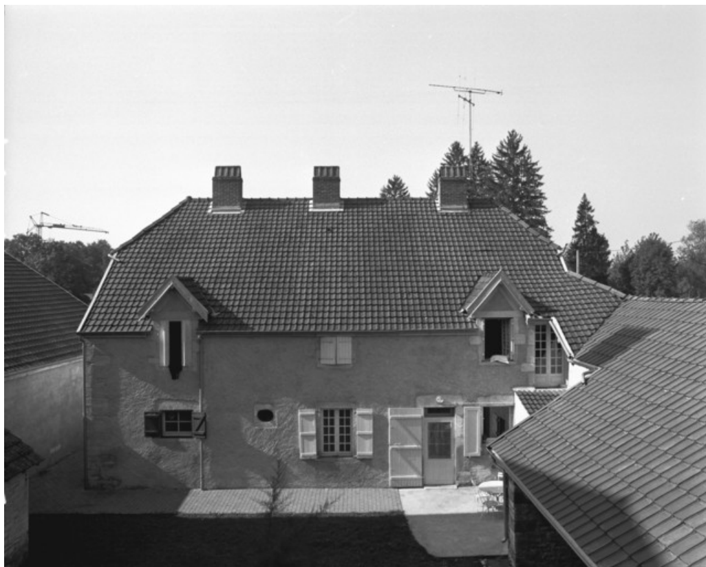
Logement patronal. Façade postérieure en 1989.
