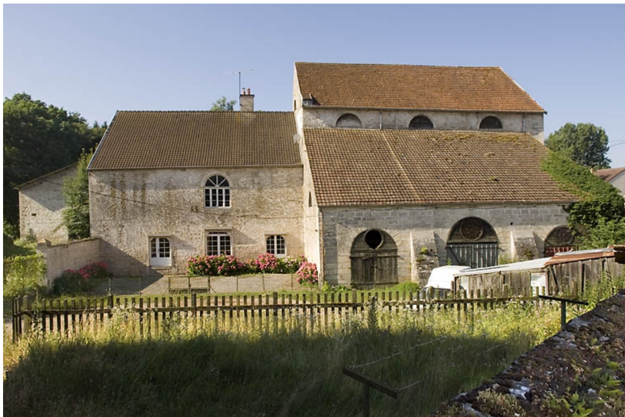
Façade nord du haut fourneau.
