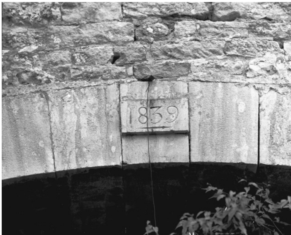
Halle à charbon. Clef d'arcade sur le pignon nord.
