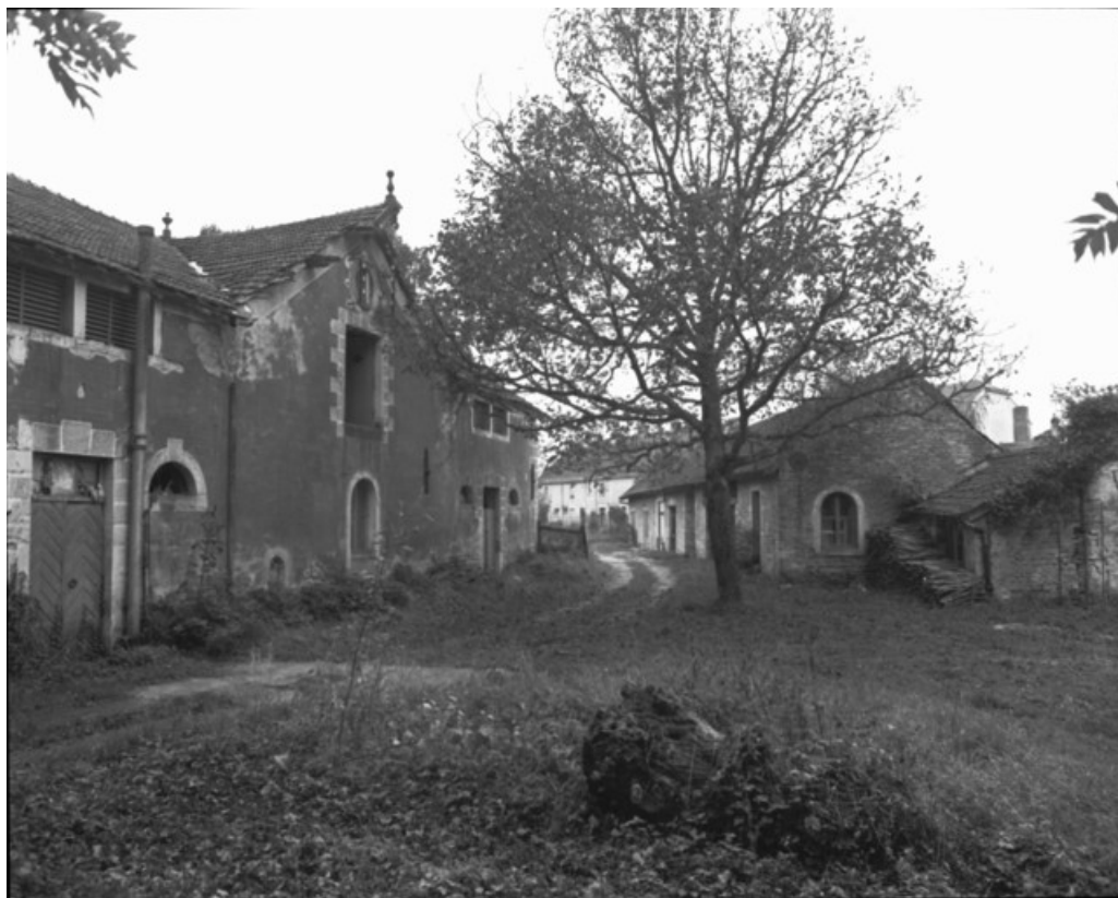
Ecurie et logement ouvrier depuis l'est en 1989.
