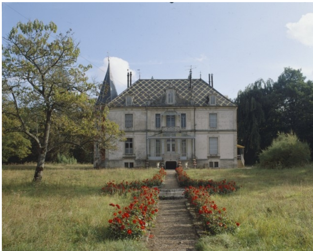
Logement patronal. Vue de face en 1989.
