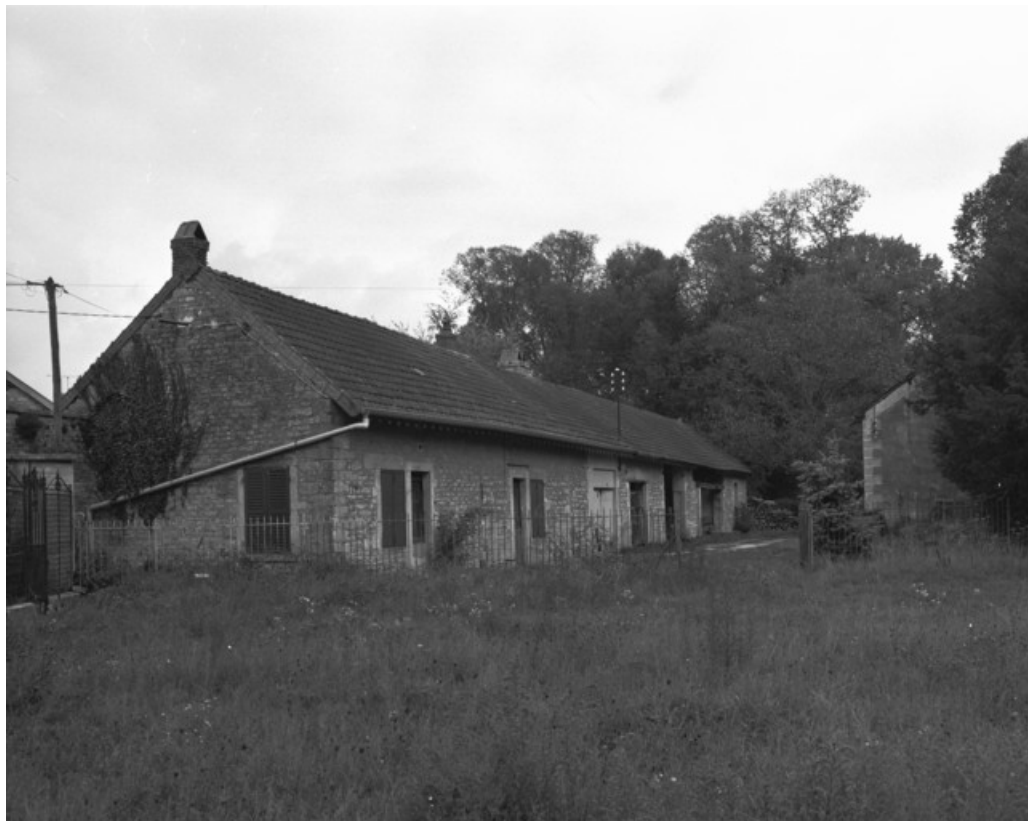
Logement ouvrier en rez-de-chaussée. Vue de trois quarts gauche en 1989. 70, Autrey-lès-Gray, 36 rue du Polon
