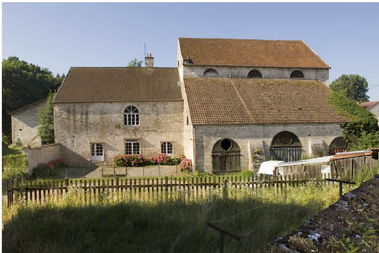
Façade nord du haut fourneau.
