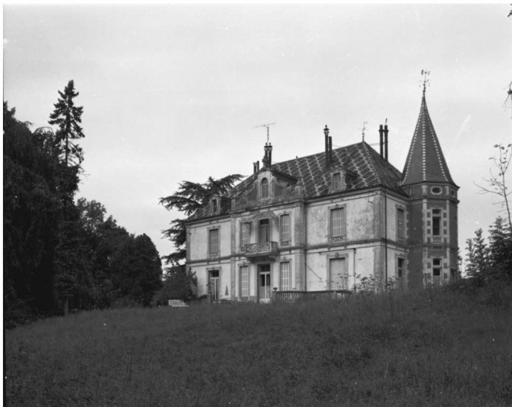
Logement patronal. Vue de trois quarts arrière en 1989.
