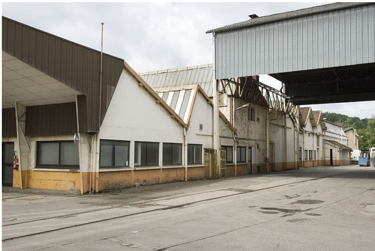
Façades nord des ateliers de fabrication.
