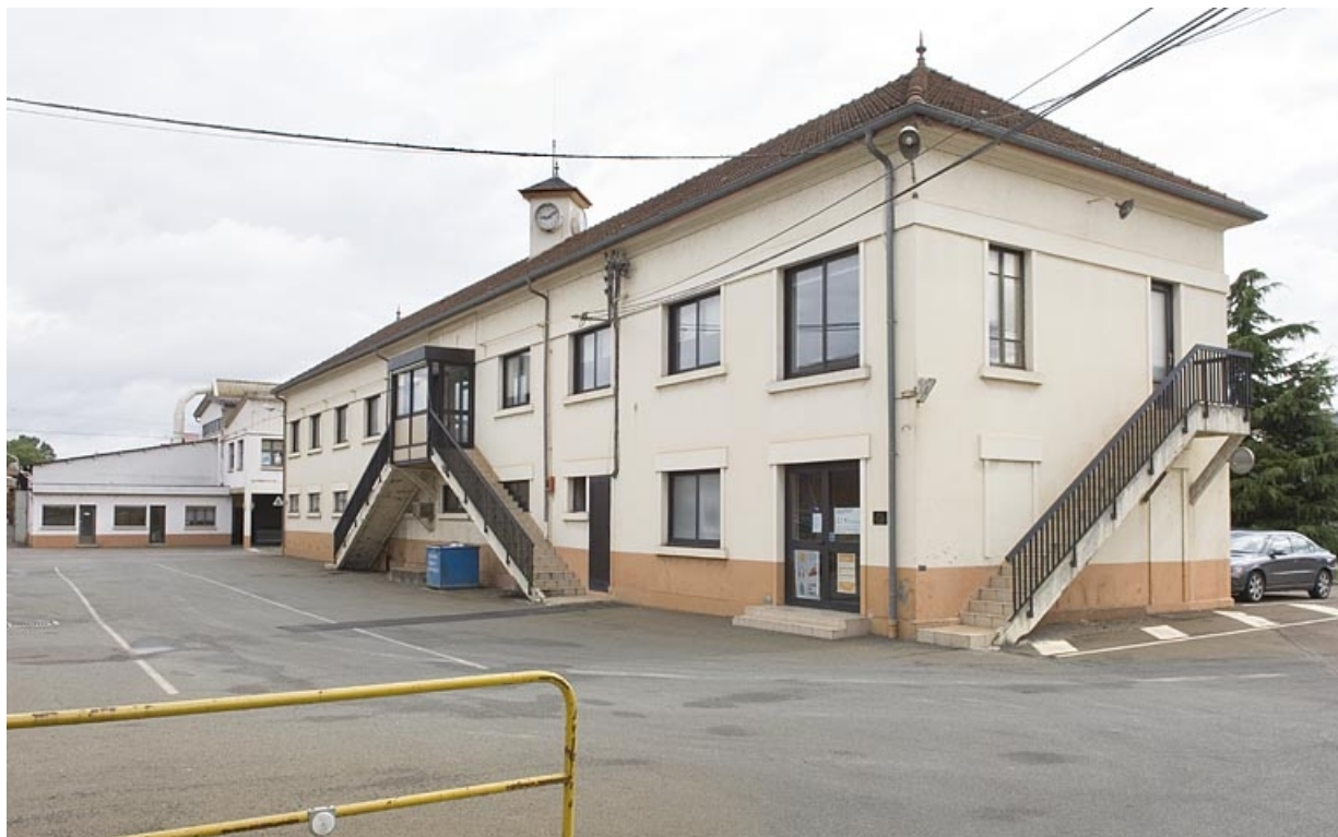
Bureaux. Vue de trois quarts arrière.
