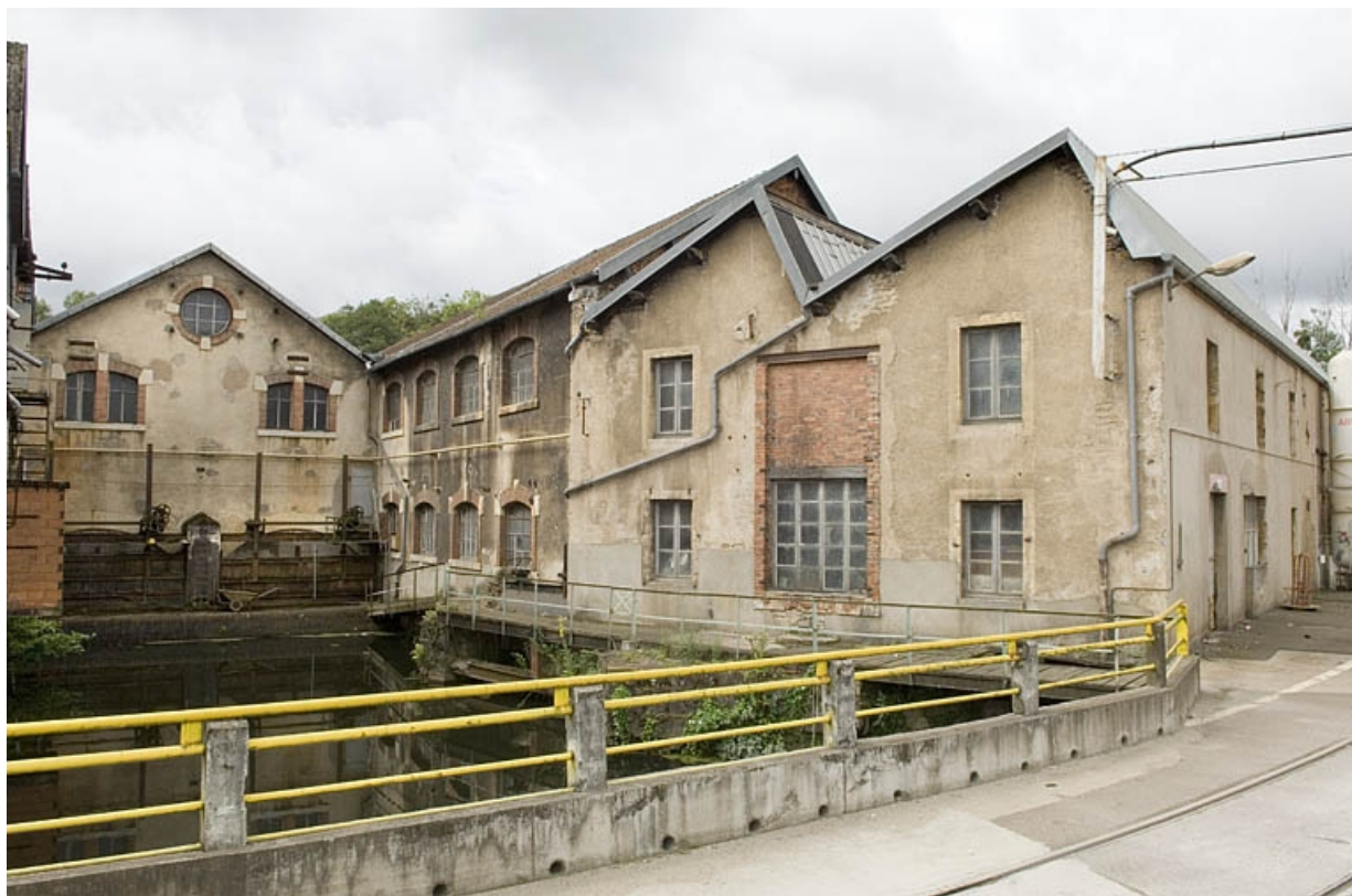
Bief d'amenée, bâtiment d'eau et atelier.
