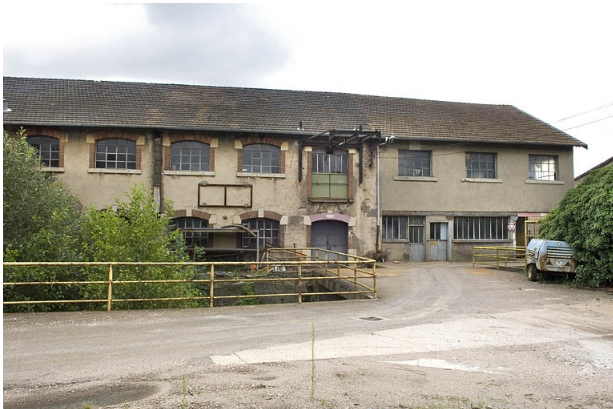
Façade ouest d'un atelier de fabrication (papeterie).
