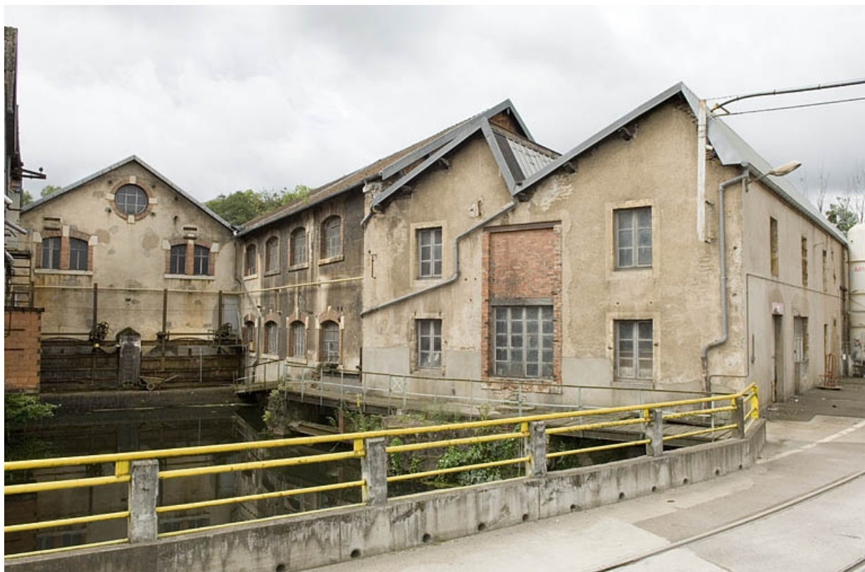
Bief d'amenée, bâtiment d'eau et atelier.
