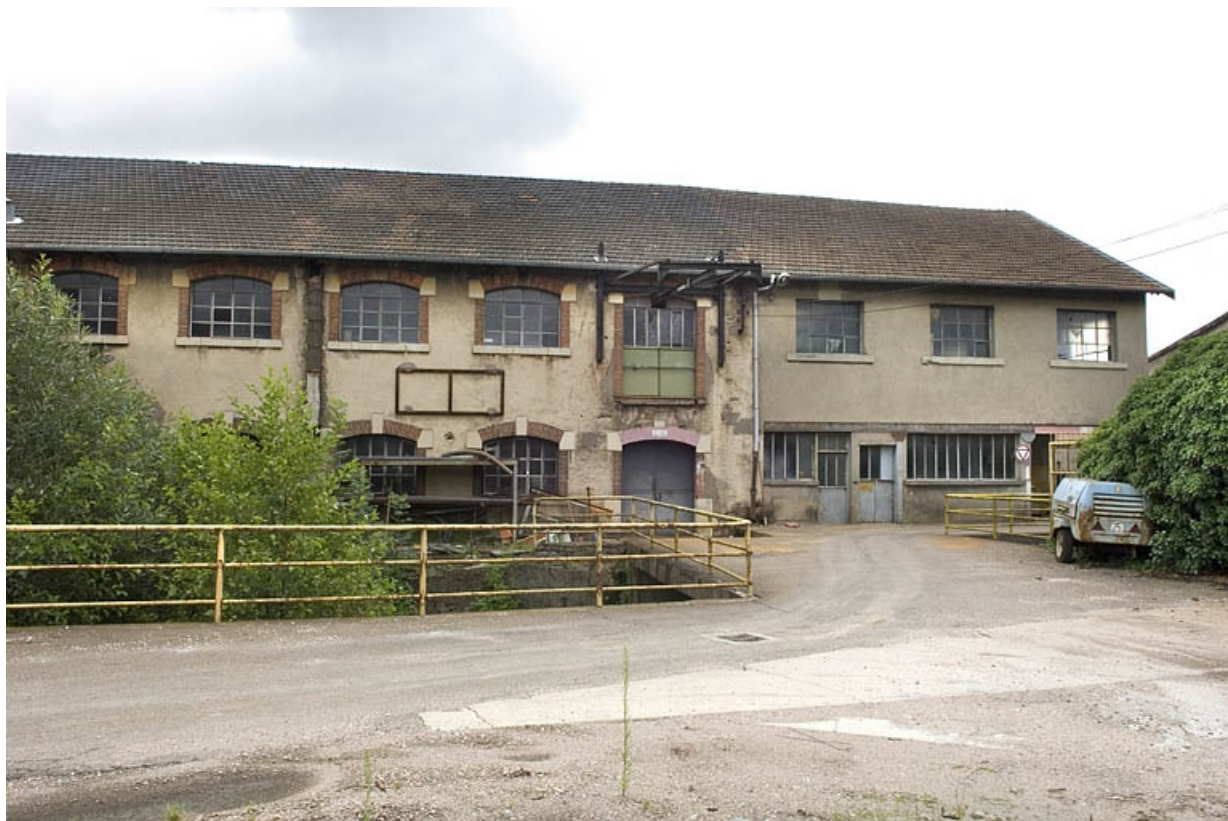
Façade ouest d'un atelier de fabrication (papeterie).
