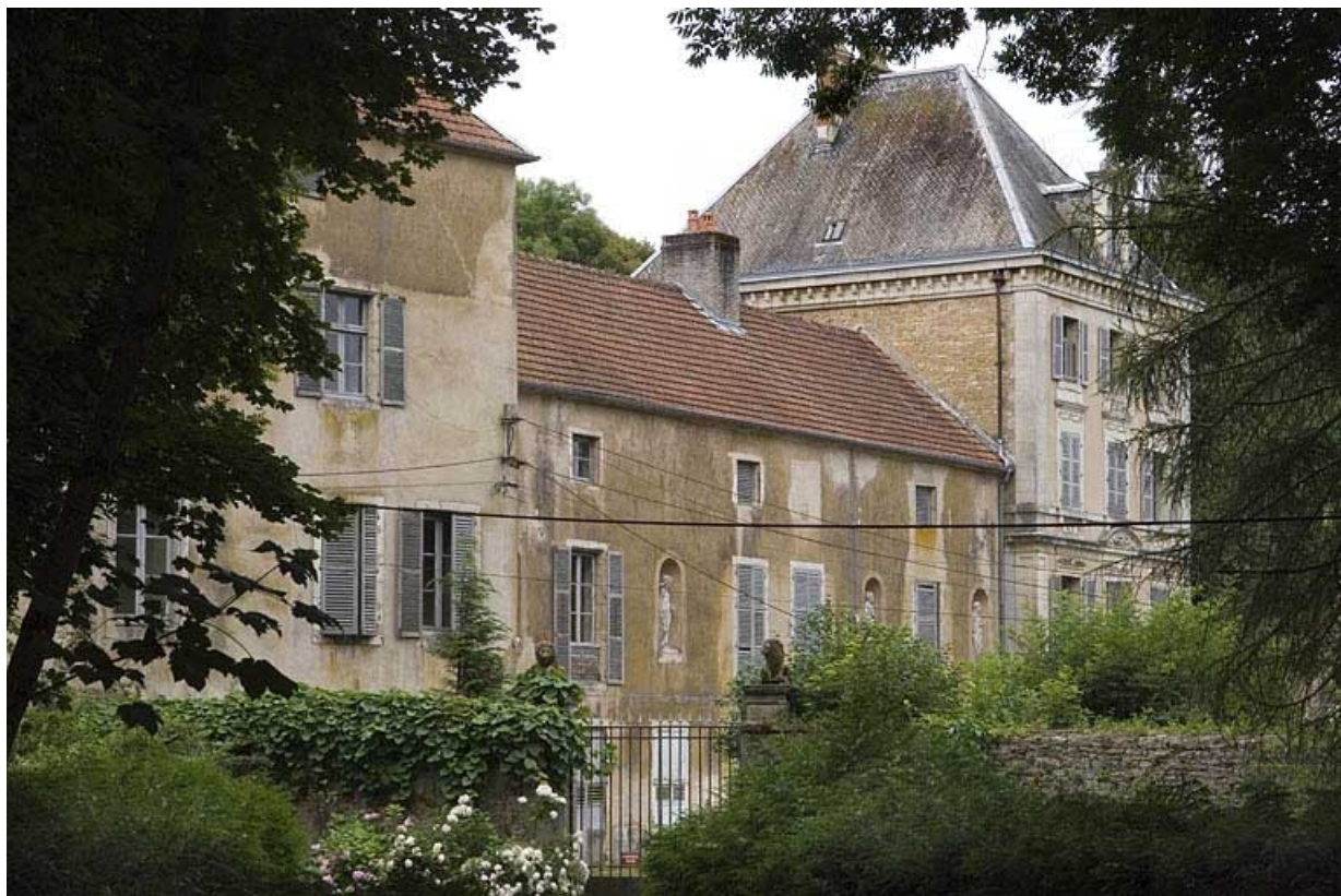
Logement patronal Façade antérieure vue de trois quarts.
