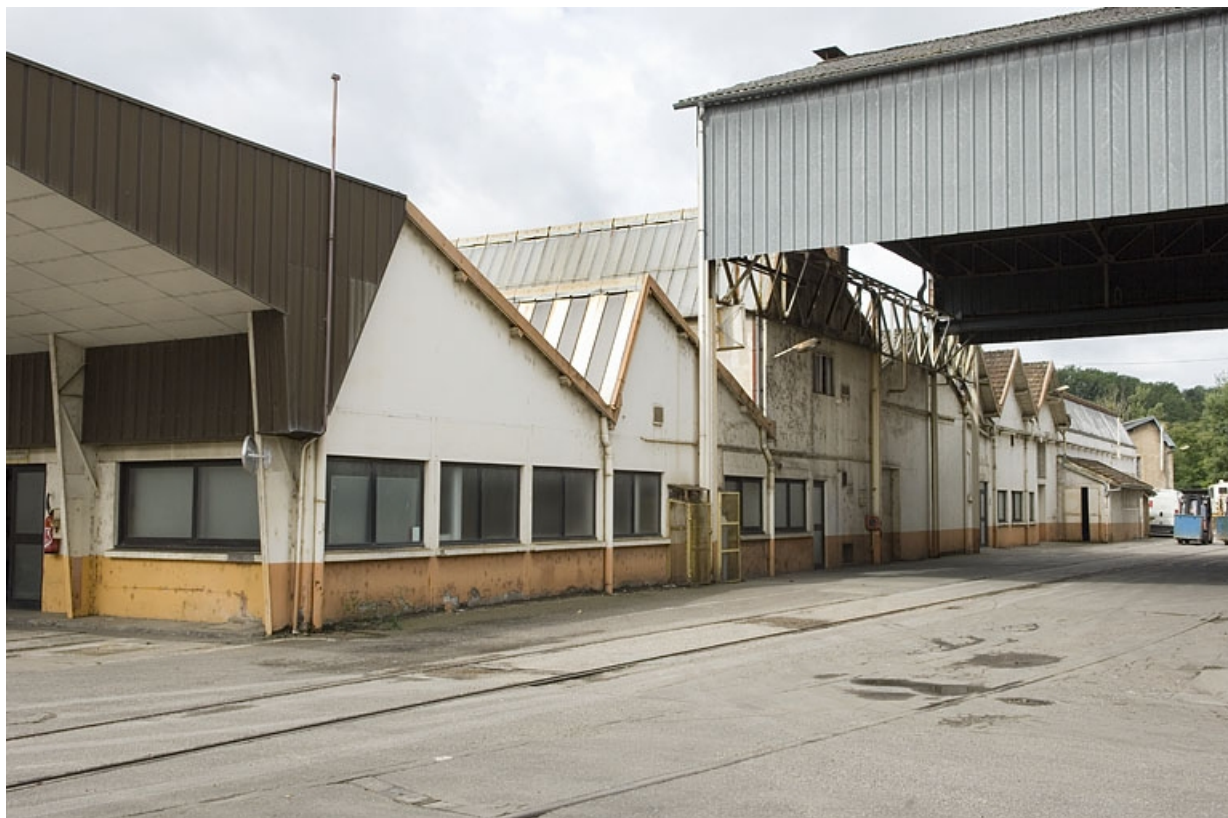
Façades nord des ateliers de fabrication.
