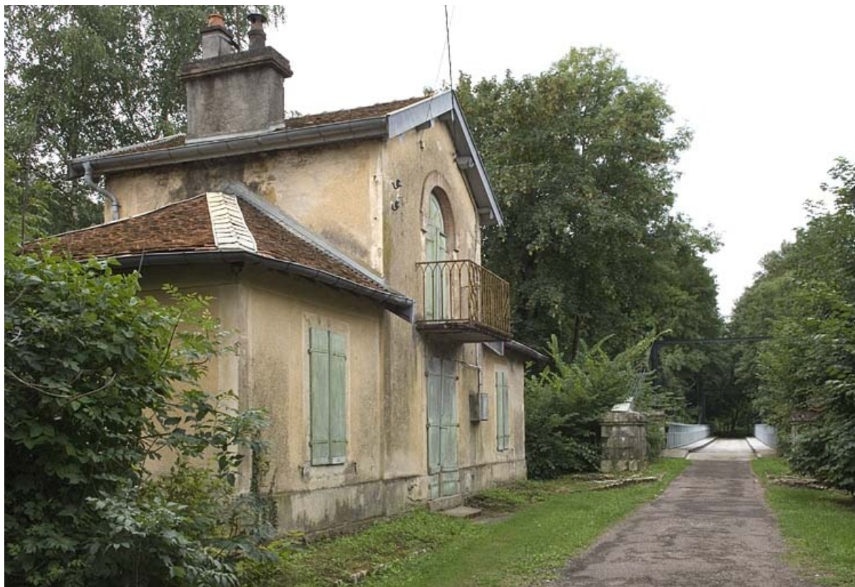
Dépendance (?) du logement patronal à l'entrée de la passerelle.
