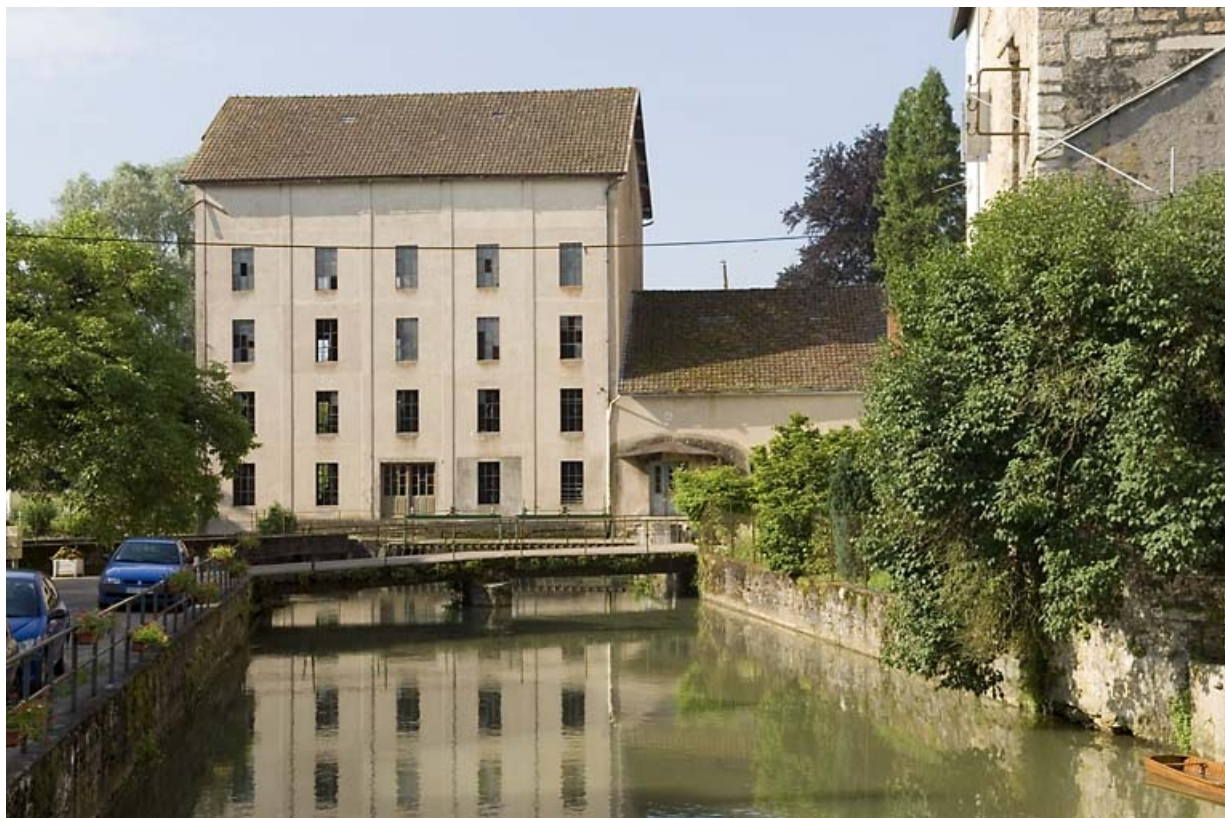
Vue depuis l'amont du bief.
