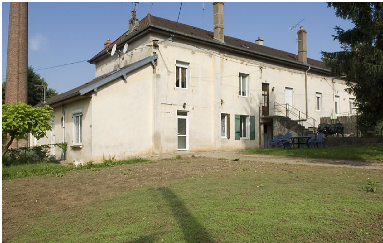
Cheminée, salle des machines et ancien atelier.
