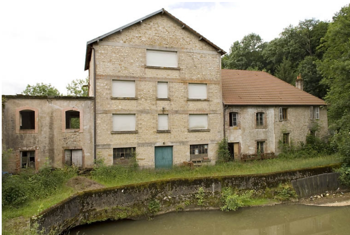
Façade de l'atelier de fabrication et du bâtiment d'eau depuis l'amont. 70, Thieffrans, lieudit : la Rouchotte
