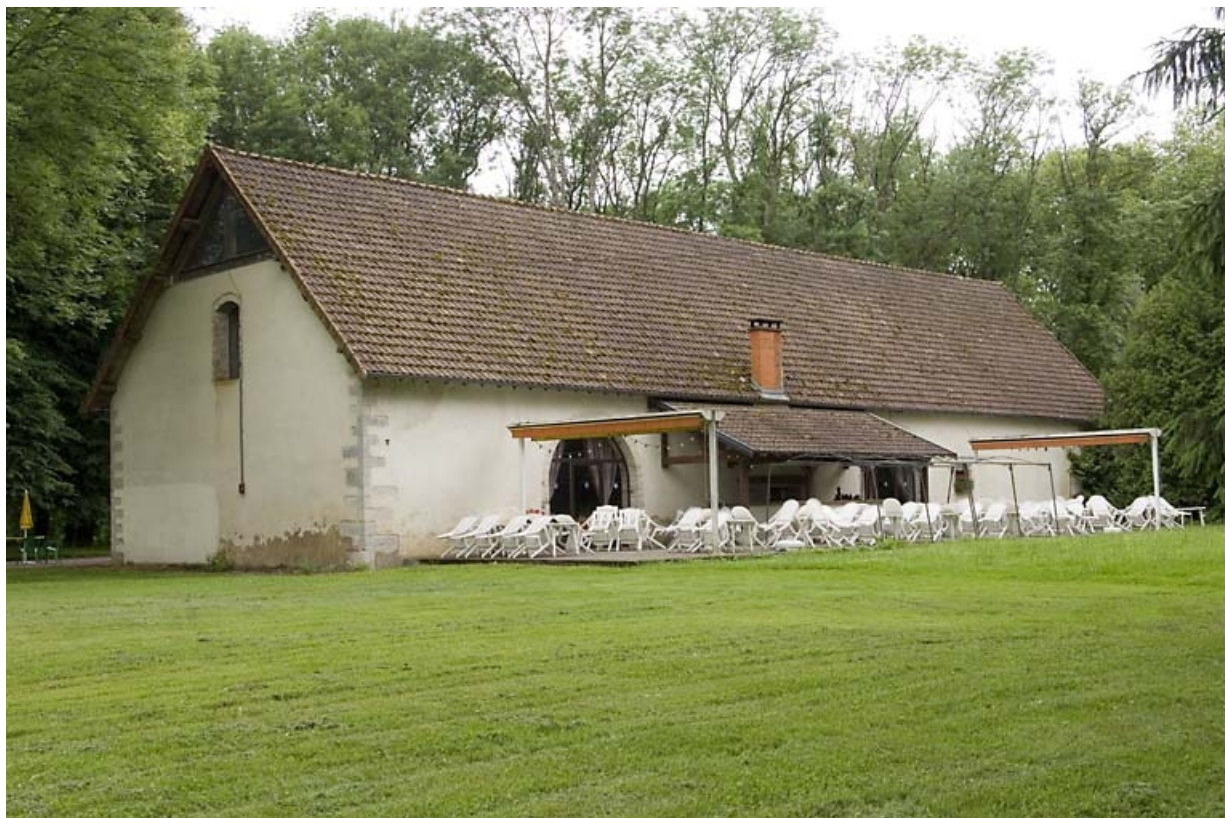
Ancienne halle à charbon depuis le sud. 70, Chassey-lès-Montbozon, lieudit : la Forge
