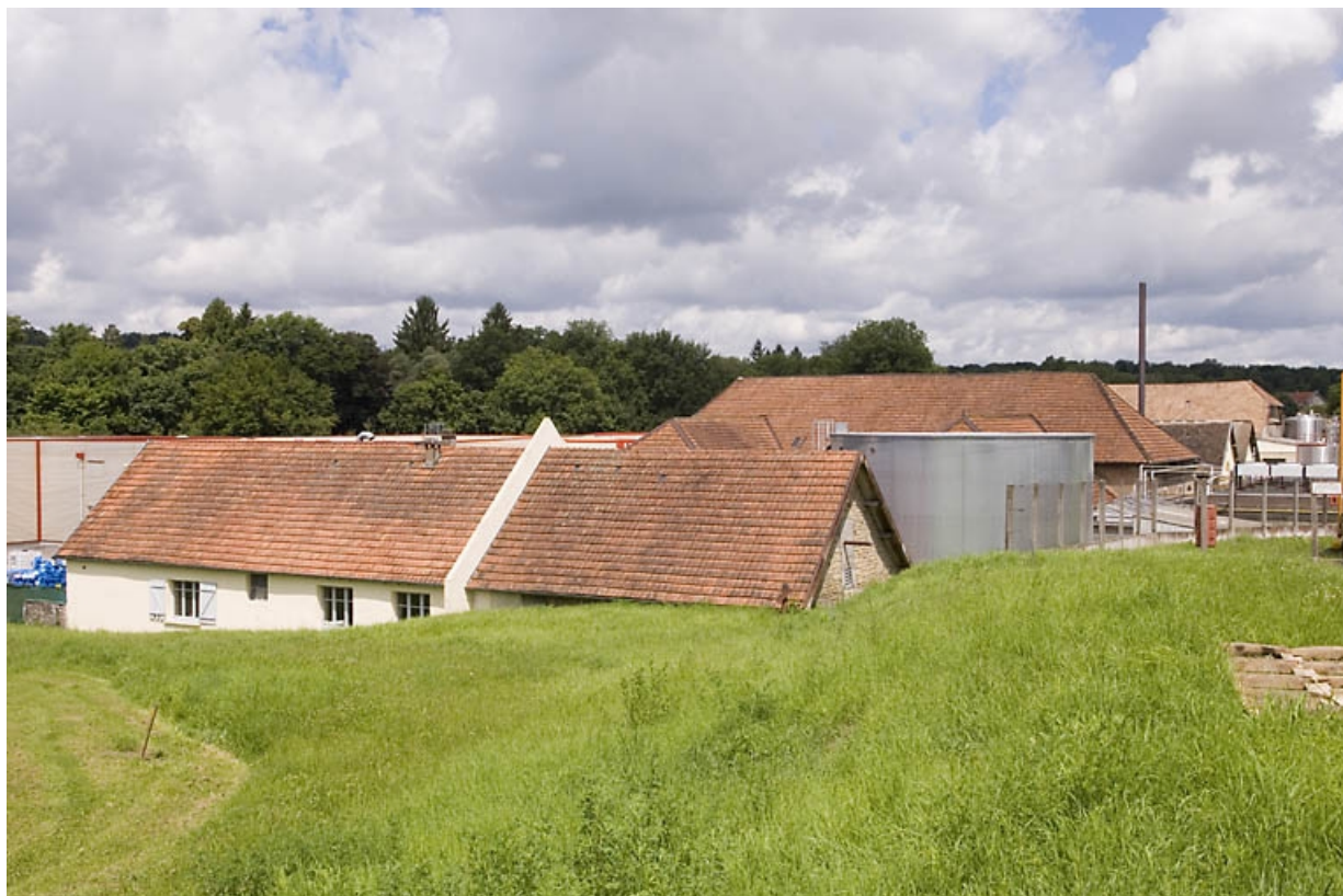
Vue sur les toitures depuis le sud-est.
