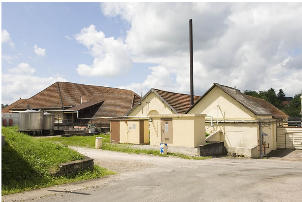
Halle de fonderie et magasins industriels (?) depuis le nord.
