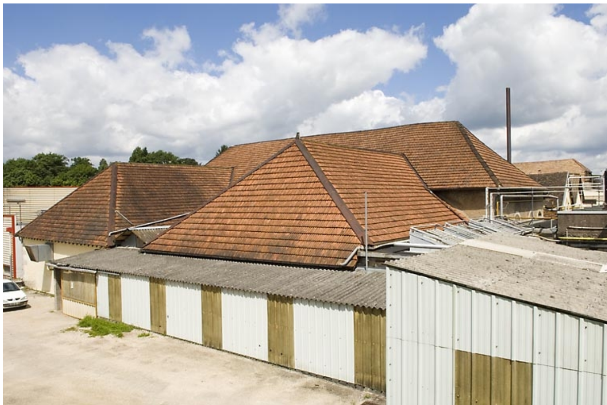
Halle de fonderie depuis le sud-est.
