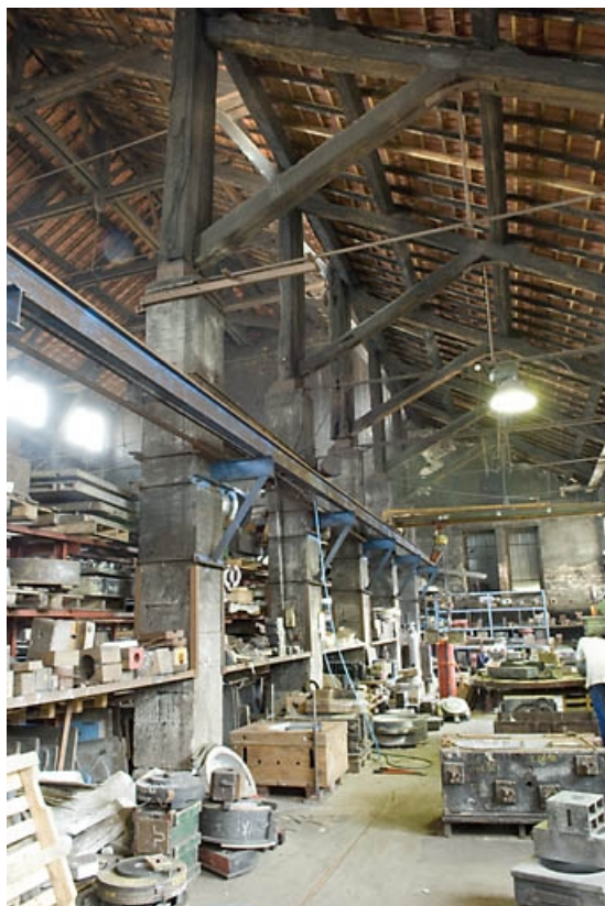
Atelier de fonderie. Le bas-côté sud.
