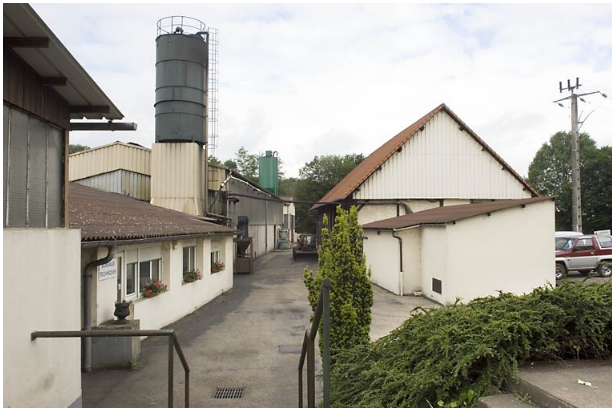
Extension de l'atelier de fonderie et magasin industriel. 70, Larians-et-Munans rue des Fonderies
