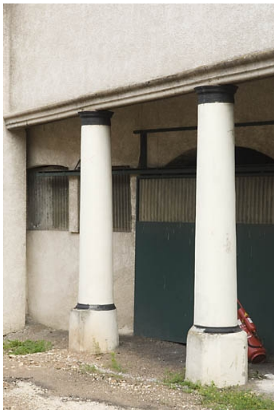
Magasin industriel et atelier de moulage. Portique d'entrée. 70, Larians-et-Munans rue des Fonderies
