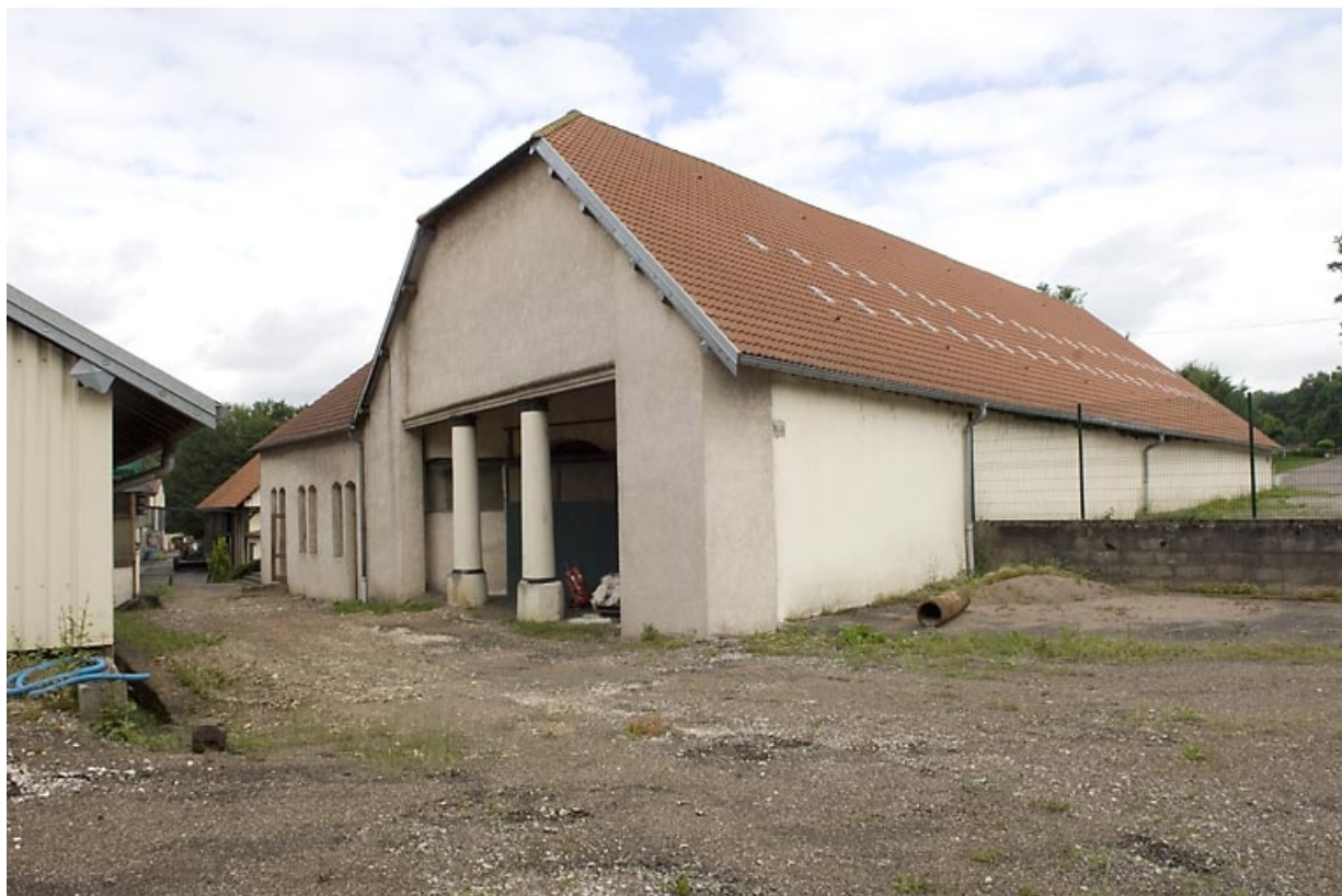
Magasin industriel et atelier de moulage depuis l'est.
