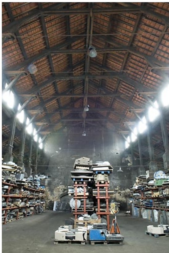
Atelier de fonderie. Vue intérieure.
