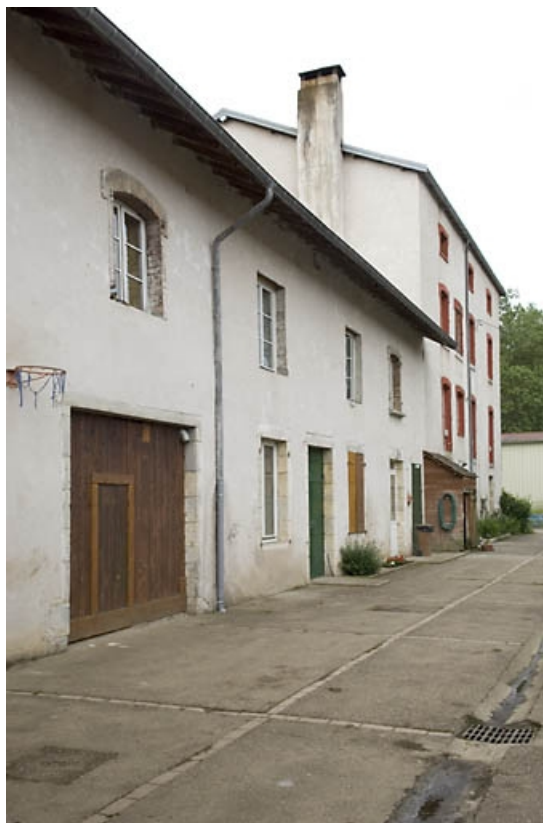
Façade nord vue de trois quarts gauche.
