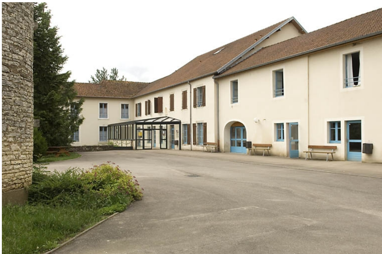
Façade est de l'atelier de fabrication (moulin et papeterie).
